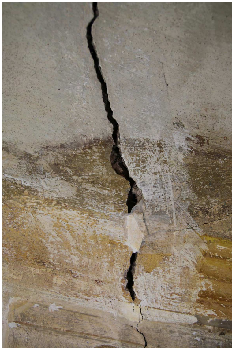
Obr. 28 Detail statické trhliny v průběhu odstraňování sádrových tmelů. Na fotografii je patrná aplikace sádrových tmelů přes originální barevnou vrstvu.
