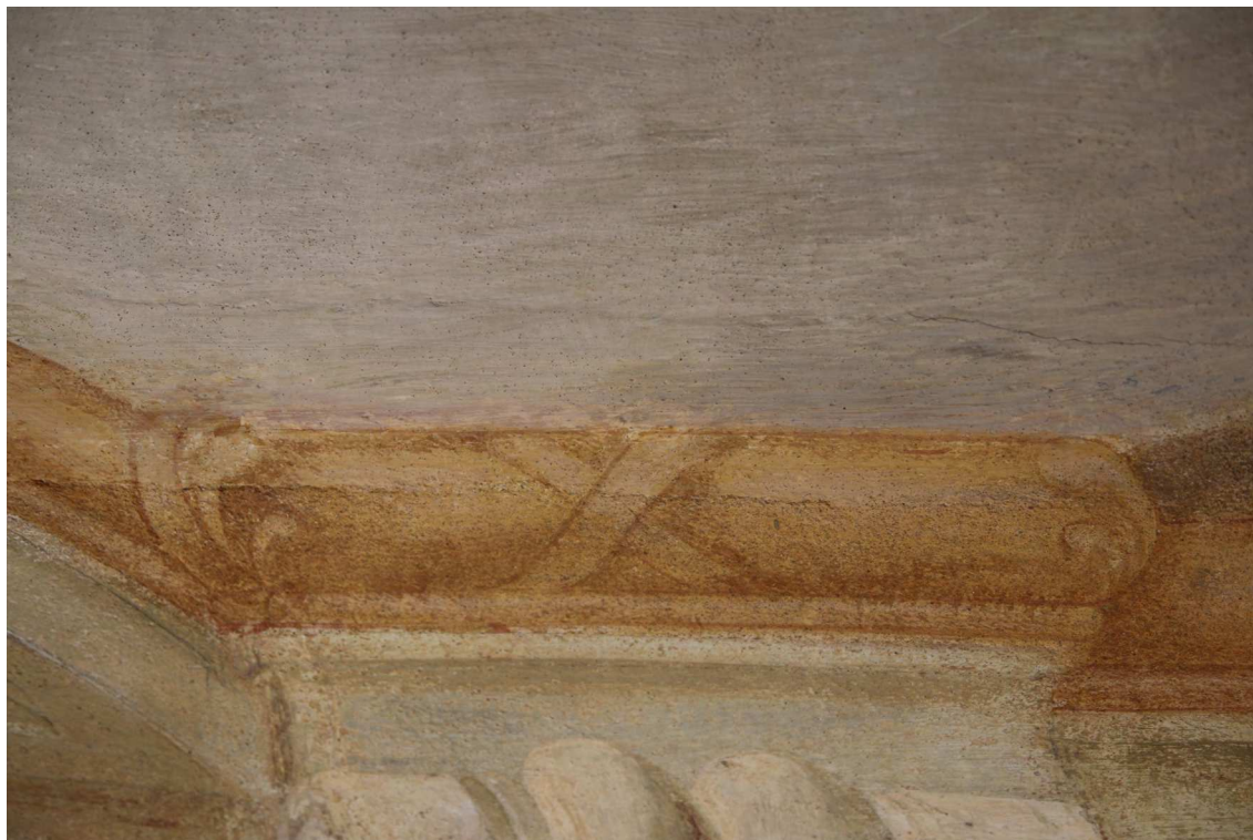
Obr. 63 Detail římsy. Stav po restaurování.
