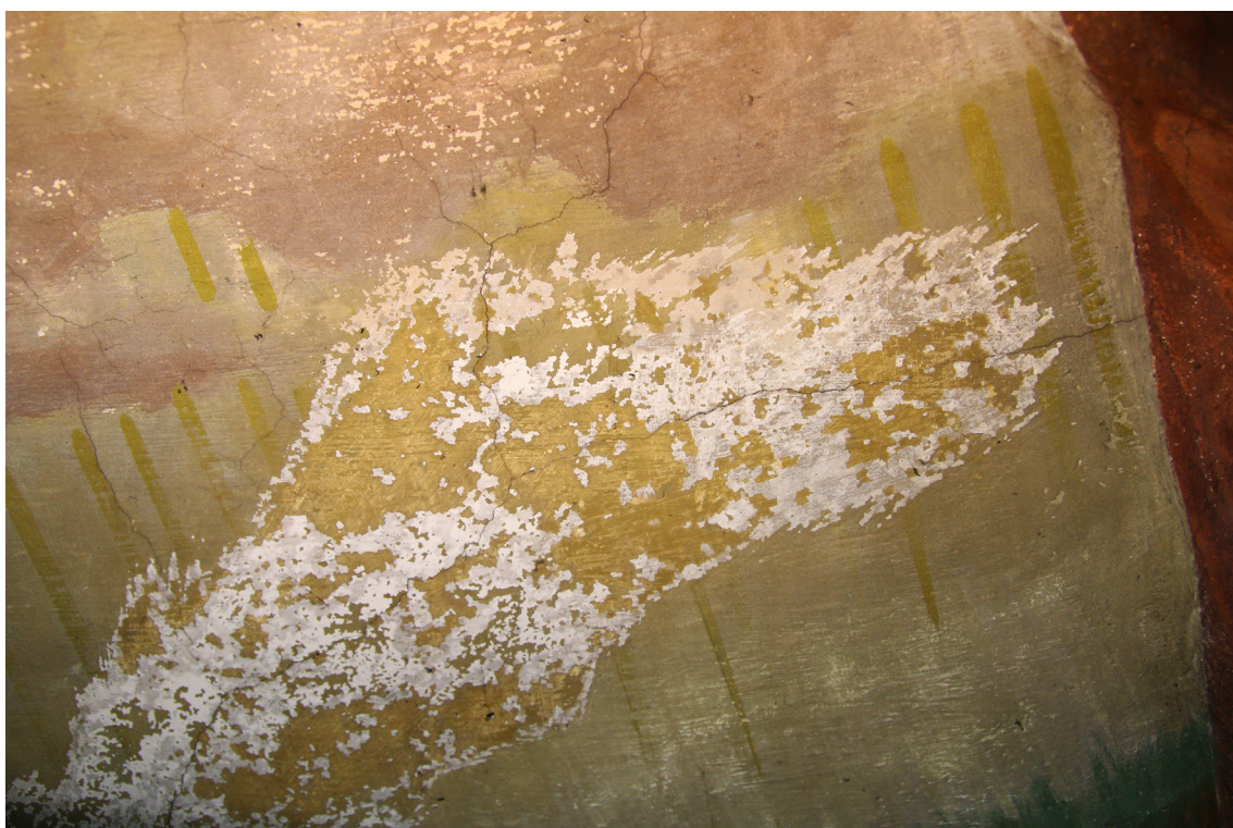
Stav přemalby na vybraných místech - detaily puchýřovitění a zpráškovatění. Nahoře - pod přemalbou prosvítá barokní malba. Dole - vysprávka trhliny se propisuje na povrch.
