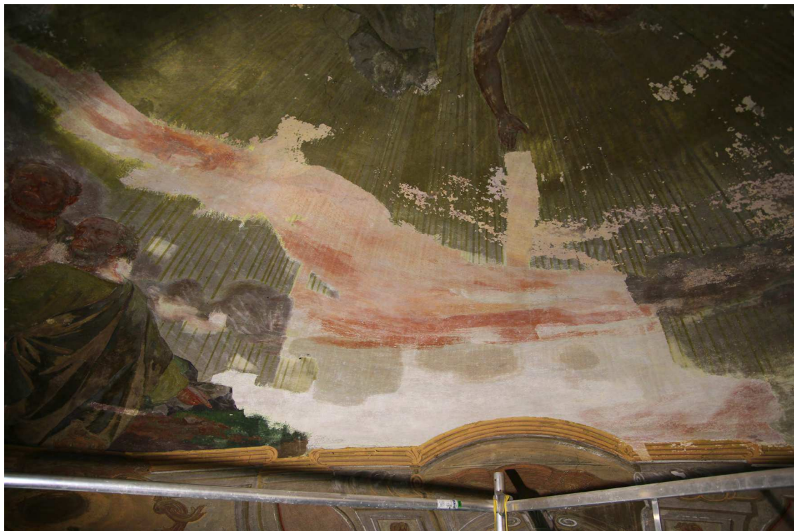
Obr. 45 Odstraňování přemalby z 19. století a odkrytí originální barokní vrstvy. Stav průběhu snímání přemalby z 19. stol.
