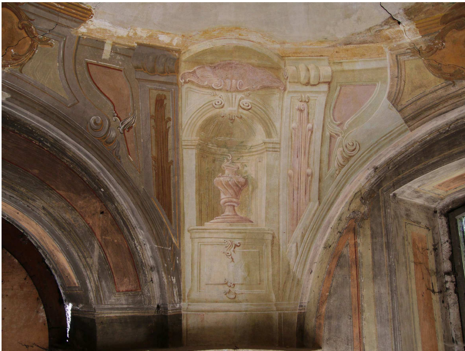
Obr. 84 Část původní barokní nástěnné malby iluzivní architektury. Pendentiv, západní kout kaple. Stav po částečném retušování.
