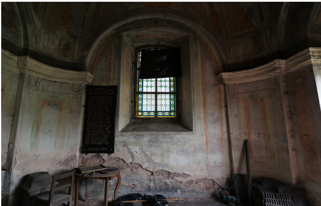
Exterier kaple - přerostlá zeleň, zvýšený terén, nevhodné zaústění okapů, poškození omítek na soklových partiích v interieru (vlhkost, zasolení).
