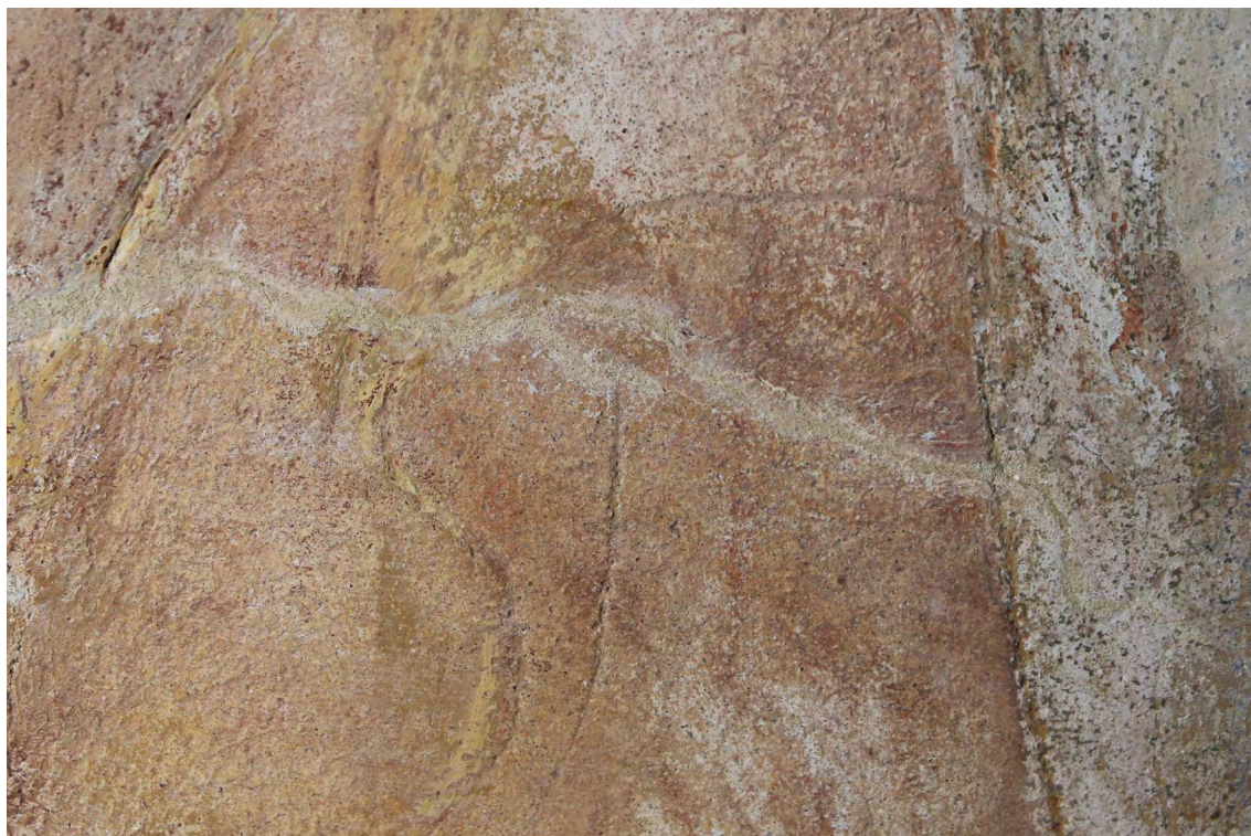
Obr. 62 Trhlina v omítkové vrstvě oblasti figury G. Stav po sejmutí přemalby z 19. stol. a po tmelení.
