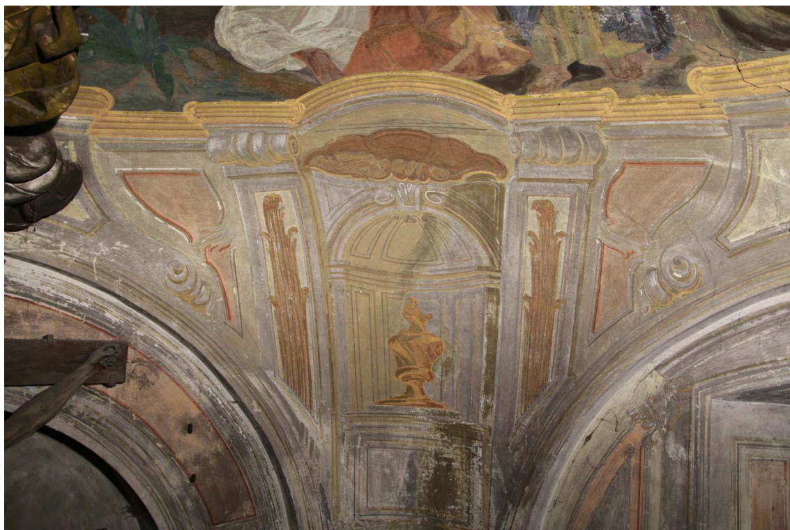
Obr. 34 Průzkum v UV záření. Detail přemalby z 19. stol. v oblasti pendentivu ve východním koutě kaple při umělém osvětlení. Stav před sejmutím přemalby z 19. stol.
