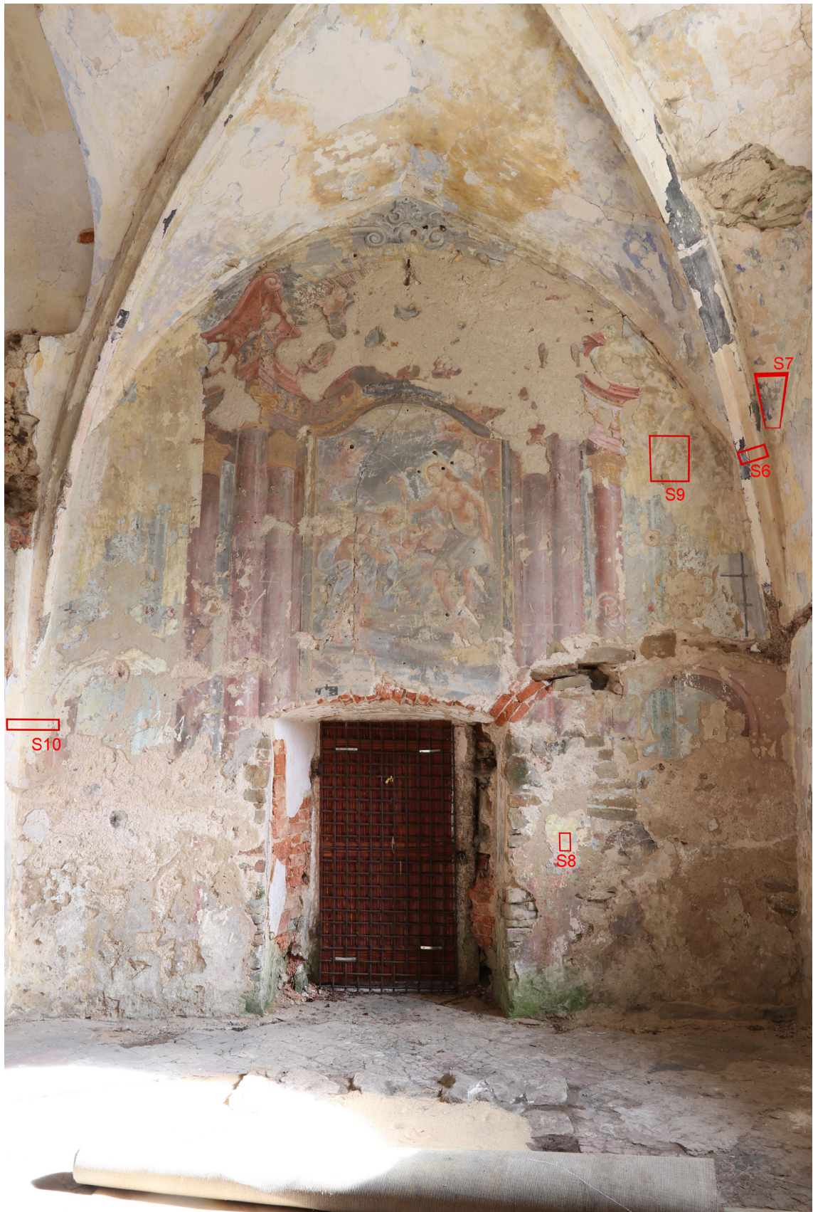
Obr. 01 Východní (oltářní) stěna presbytáře. Lokalizace sond.
