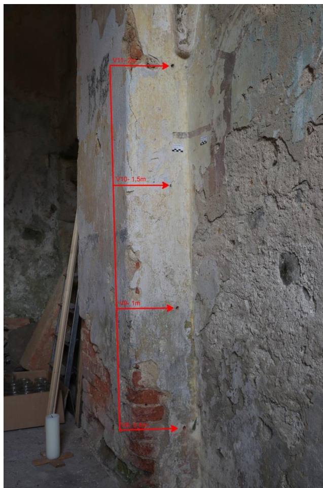
Obr. 73 Místa odběru vzorků určených ke stanovení množství vodorozpustných solí na severovýchodním rohu presbytáře, celkový pohled. Odběr ve čtyřech výškových (0,5 m, 1 m, 1,5 m, 2 m) a následně čtyřech hloubkových úrovních (0–2 cm, 2–5 cm, 5–10 cm, 10–15 cm).
