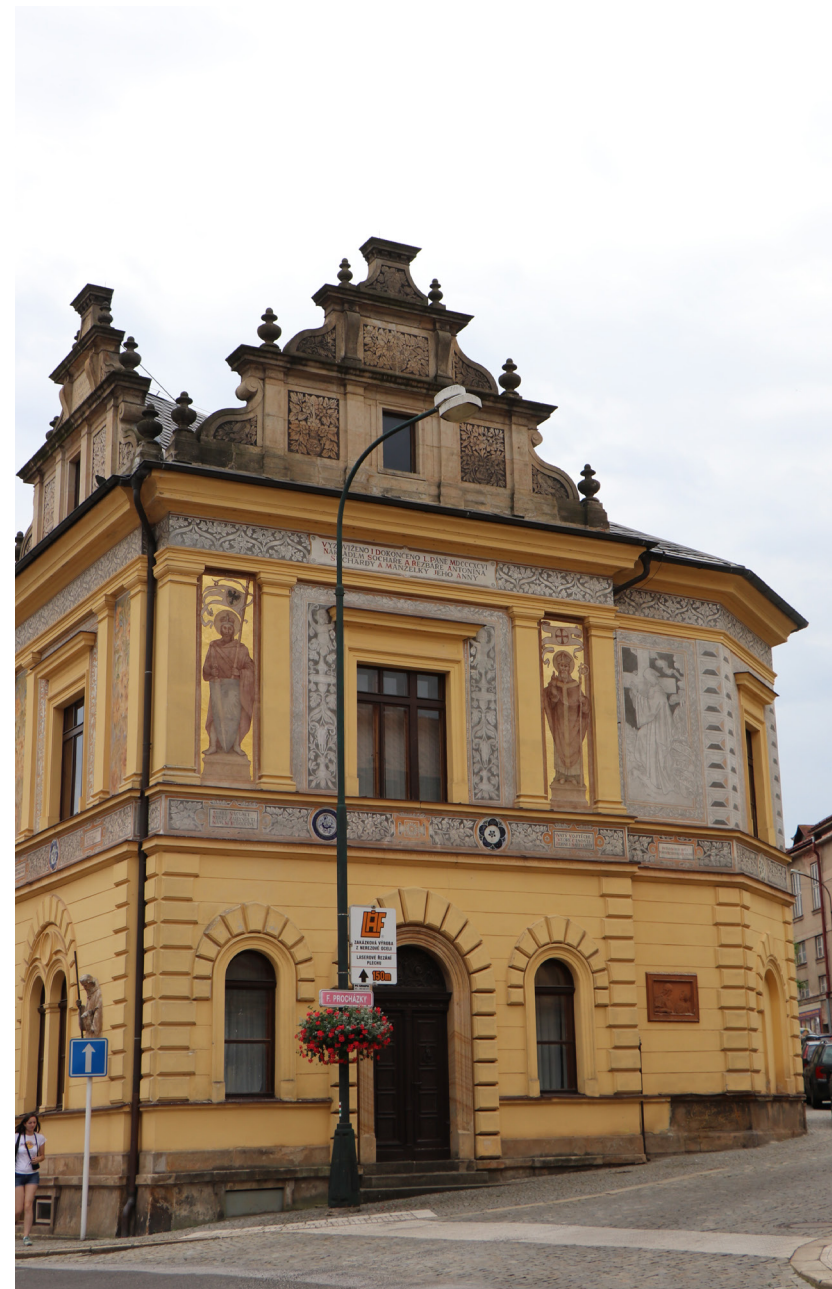
Obr. 117: Pohled na severozápadní fasádu Suchardova domu po restaurování, červenec 2017.
