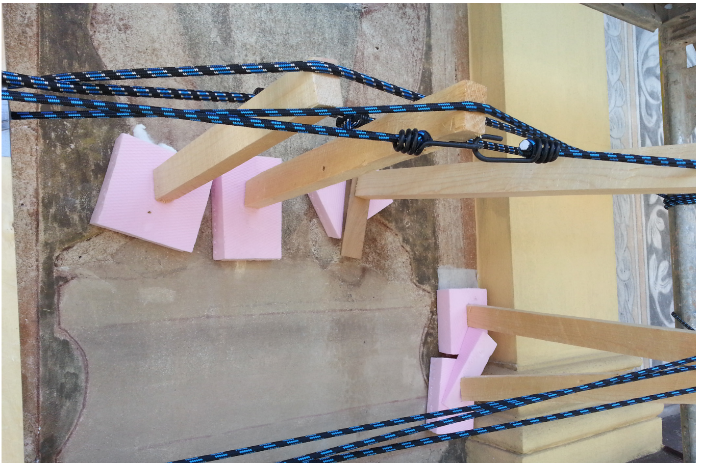
Obr. 53: Postup injektážních prací na malbě sv. Václava. Přítlak za pomoci prakovací metody pomáhá k částečnému navrácení zdvižené omítky do původní roviny. Injektáž byla na této malbě prováděna před i po vyjmutí tmelů.
