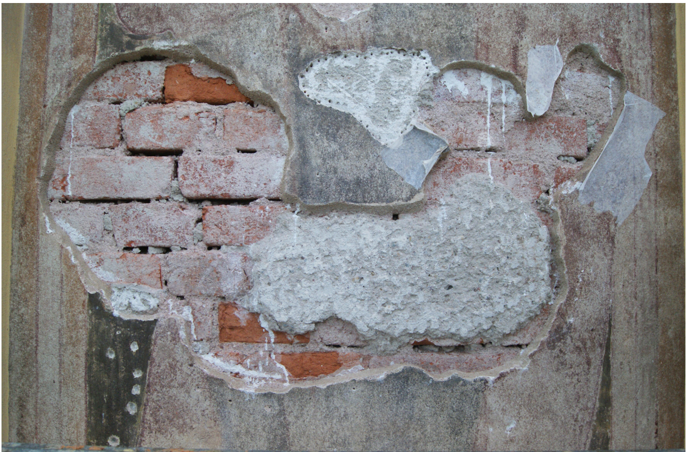
Obr. 59: Část malby sv. Václava po odstranění staršího tmelu a obtmelení po jeho okrajích. V tomto případě byla část jádrové omítky starého tmelu pro její dobrý stav ponechána. Jádro bylo také ponecháno ve vrchní střední části, kde by při nadměrném tlaku při odstraňování hrozila ztráta originální omítky s malbou.
