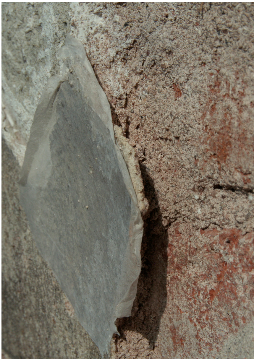
Obr. 56: Detail části omítky malby sv. Václava po odstranění starých tmelů. Omítka musela být lokálně zabezpečena přelepy z japonského papíru, aby nedošlo k její ztrátě.
