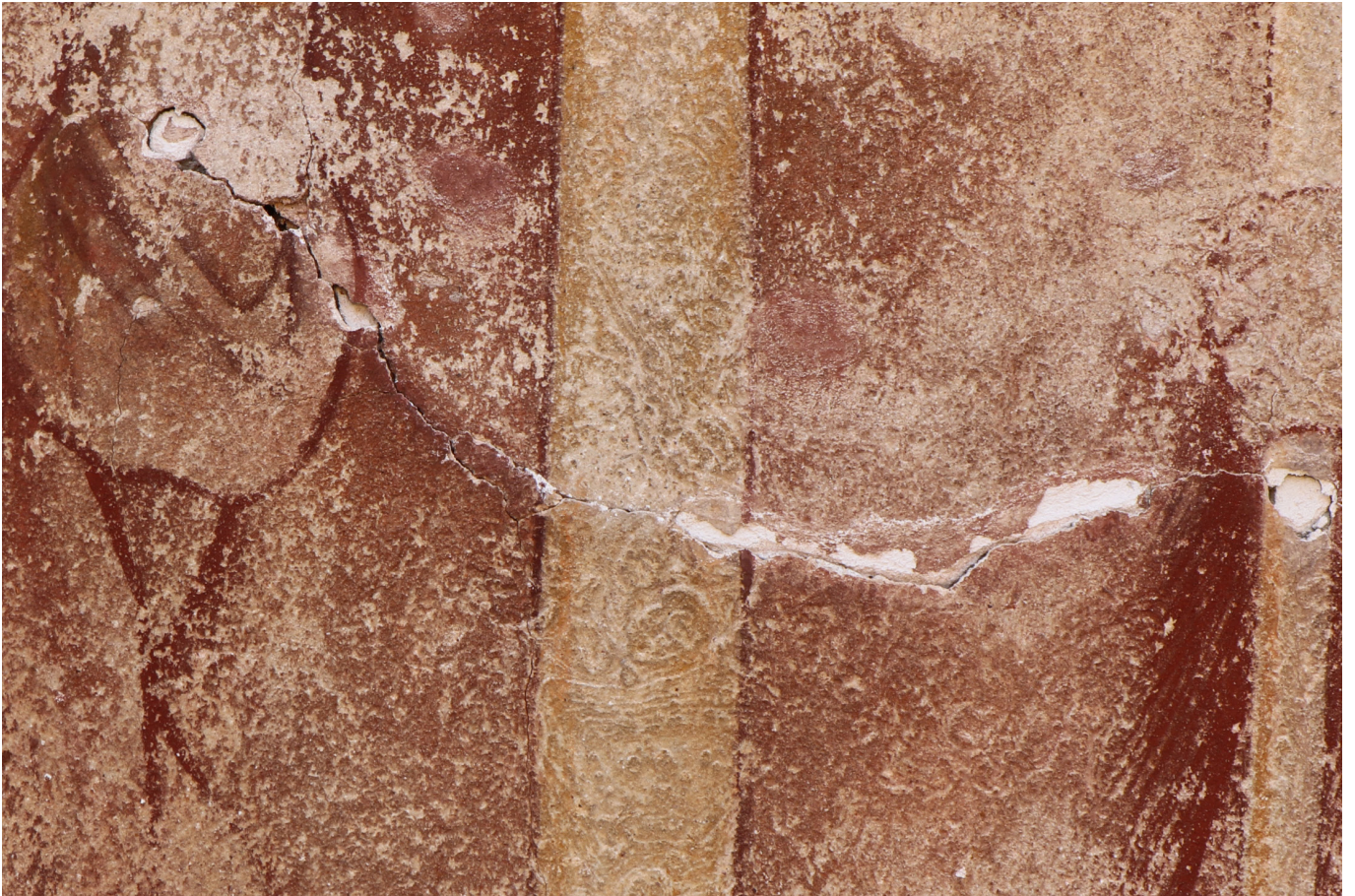
Obr. 98: Část malby sv. Vojtěcha - trup. Místo největší praskliny, před restaurováním. Fotografie v denním světle.
