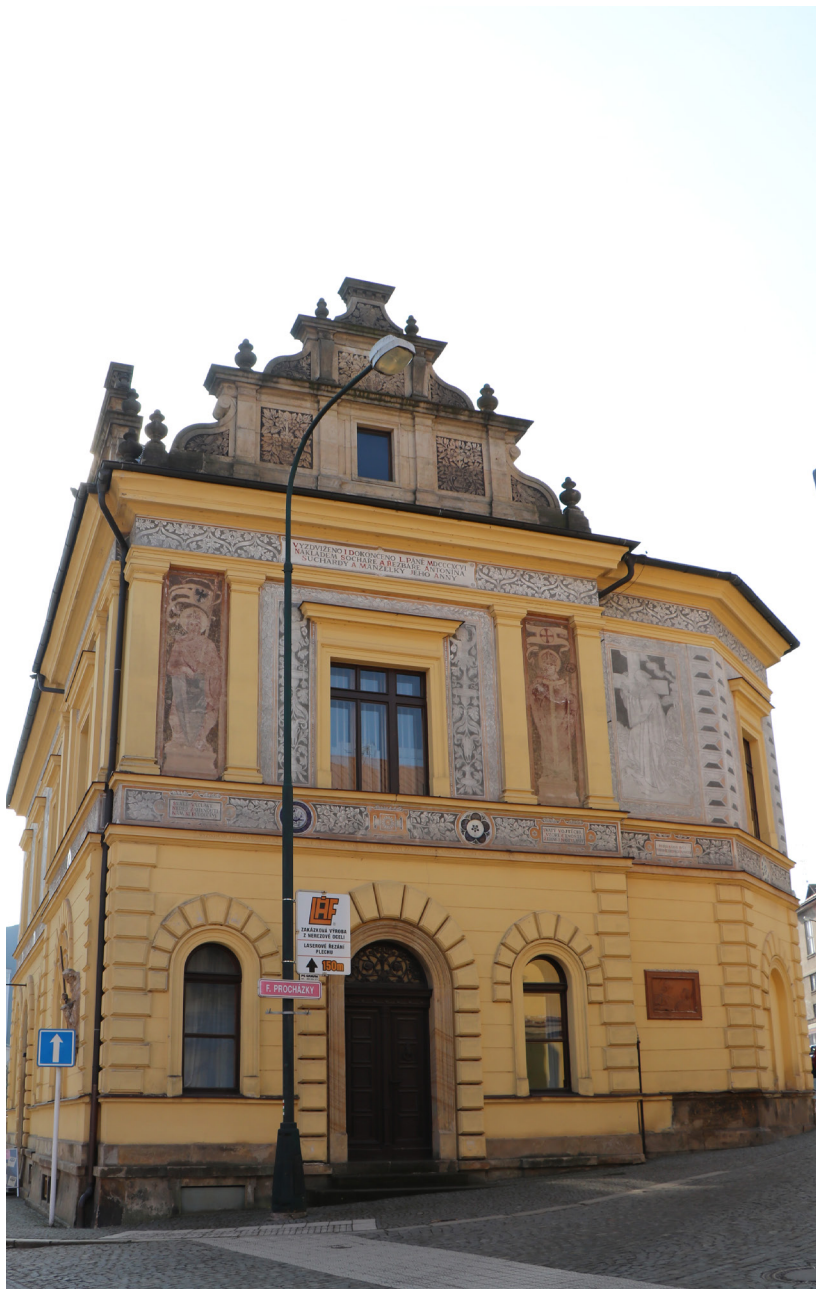
Obr. 116: Pohled na severozápadní fasádu Suchardova domu před restaurováním , duben 2017.
