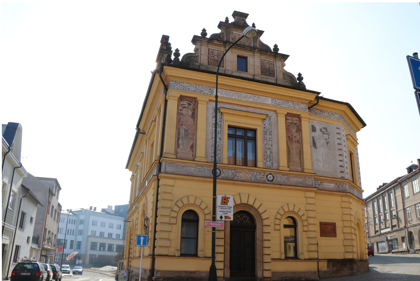
Obr. 3: Severozápadní průčelí budovy Městského muzea - Suchardova domu.
