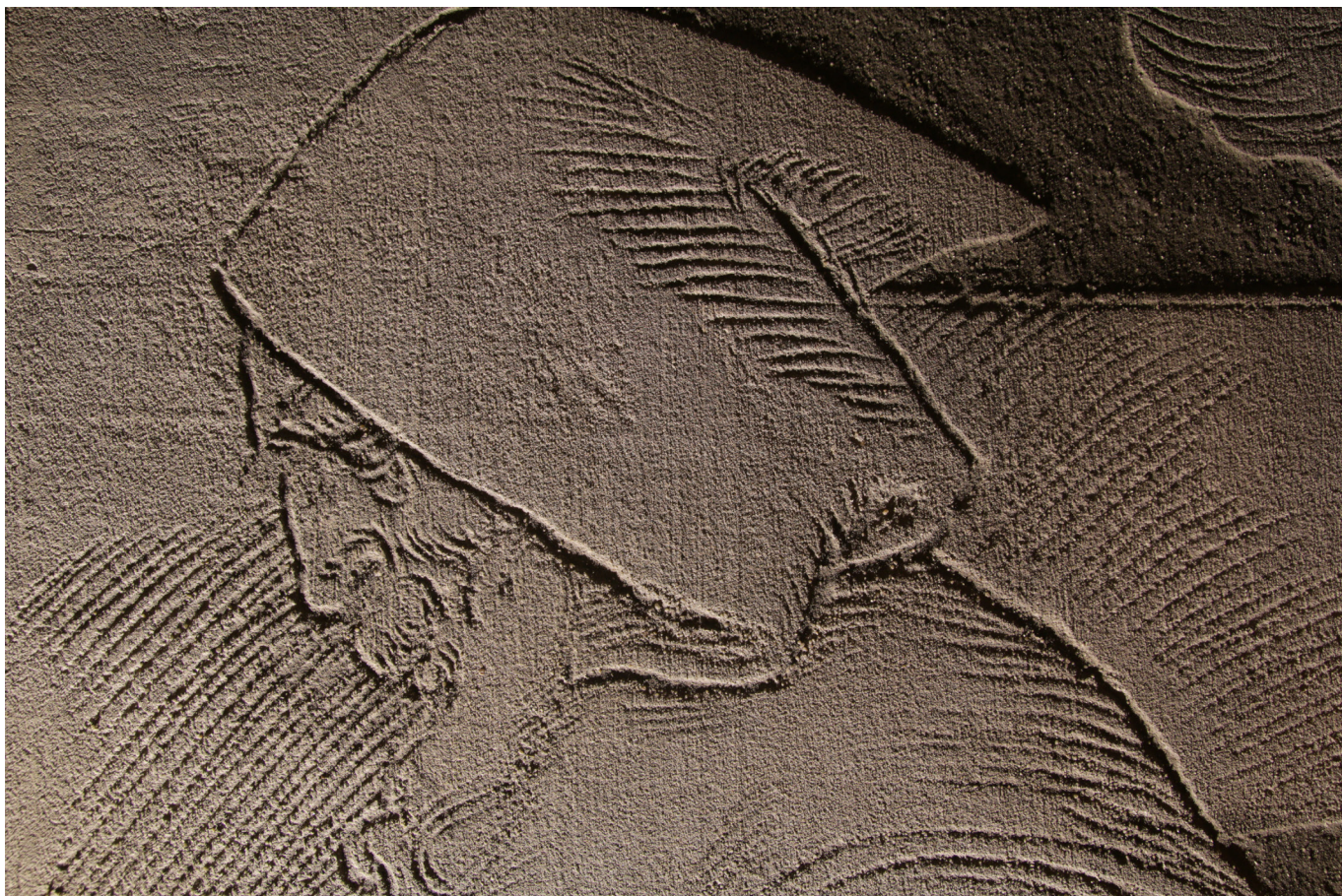
Obr. 44: Portrétní část sgrafita Božetěcha, v ostrém bočním nasvícení před restaurováním. Ve světle vynikla hladká jemně filcovaná struktura omítky. Vynikl také reliéf ryté kresby v omítce a její rozdílná hloubka provedení.
