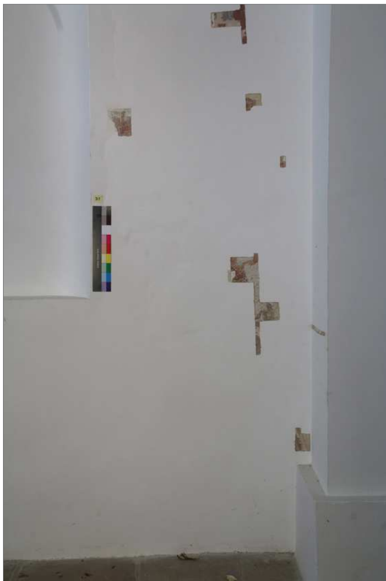
Obr. 18 Prává spodní část restaurované stěny. Stav před odkryvem.
