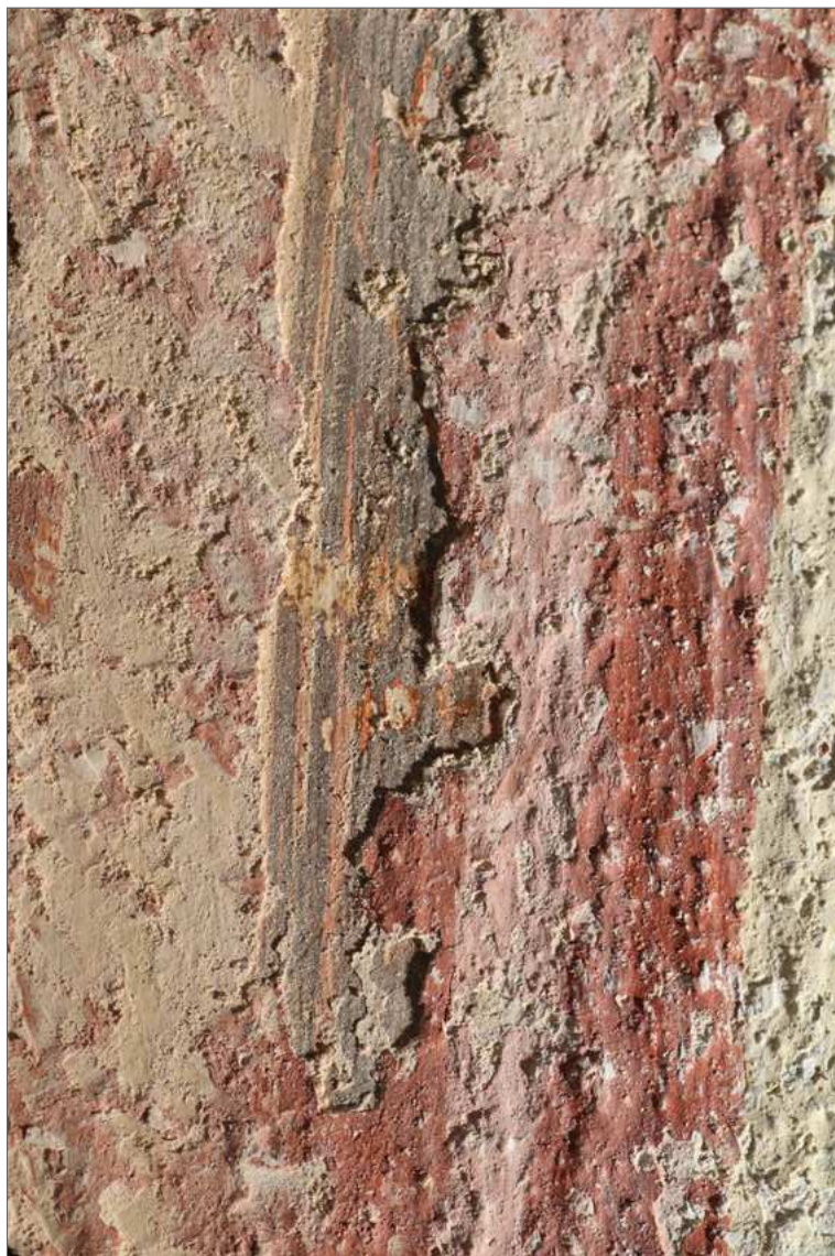
Obr. 35 Detail iluzivní profilované římsy v okolí niky. Detail hrubé struktury rokokové malby (červeno-okrová vrstva) a hladkého povrchu barokní malby (hnedá barevná vrstva ve střední části fotografie). Stav po odkryvu.
