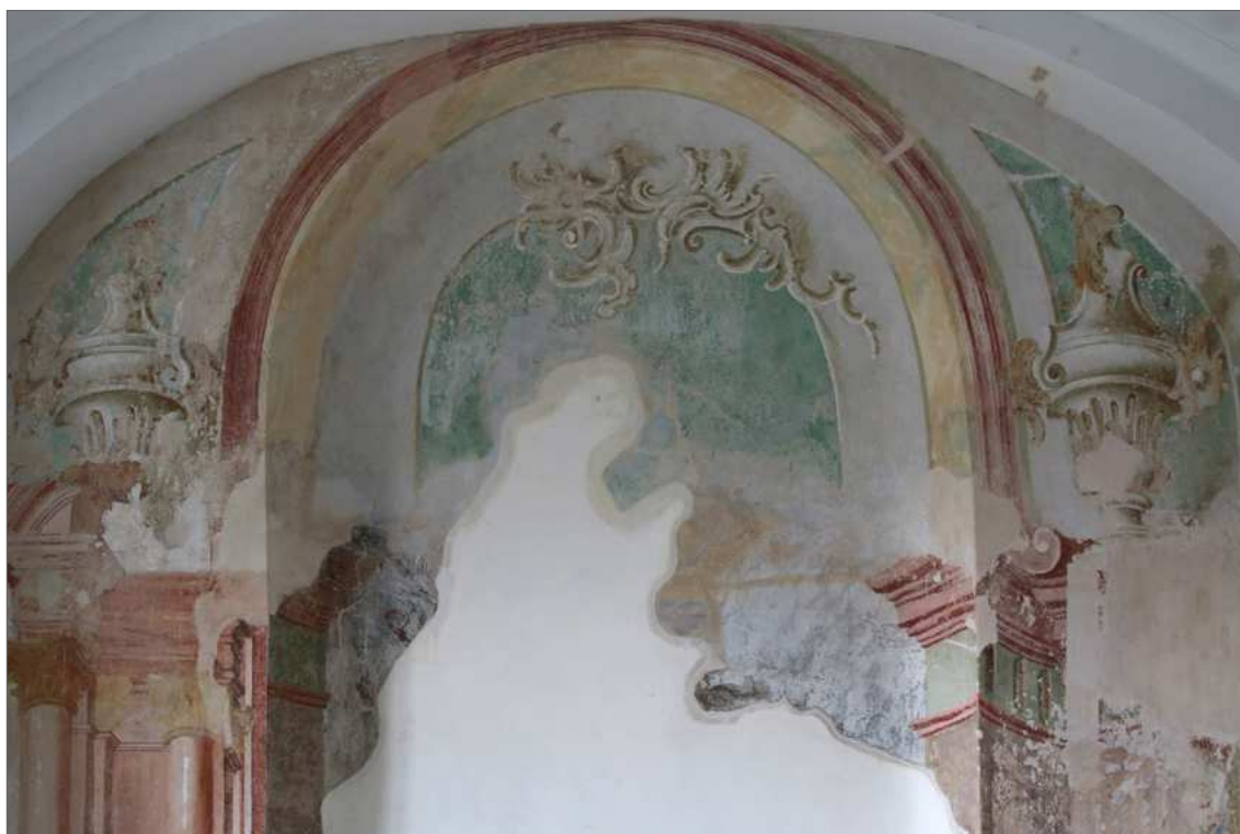
Obr. 78 Pohled na horní polovinu restaurované stěny po aplikaci podkladového nátěru. Stav před retušováním.
