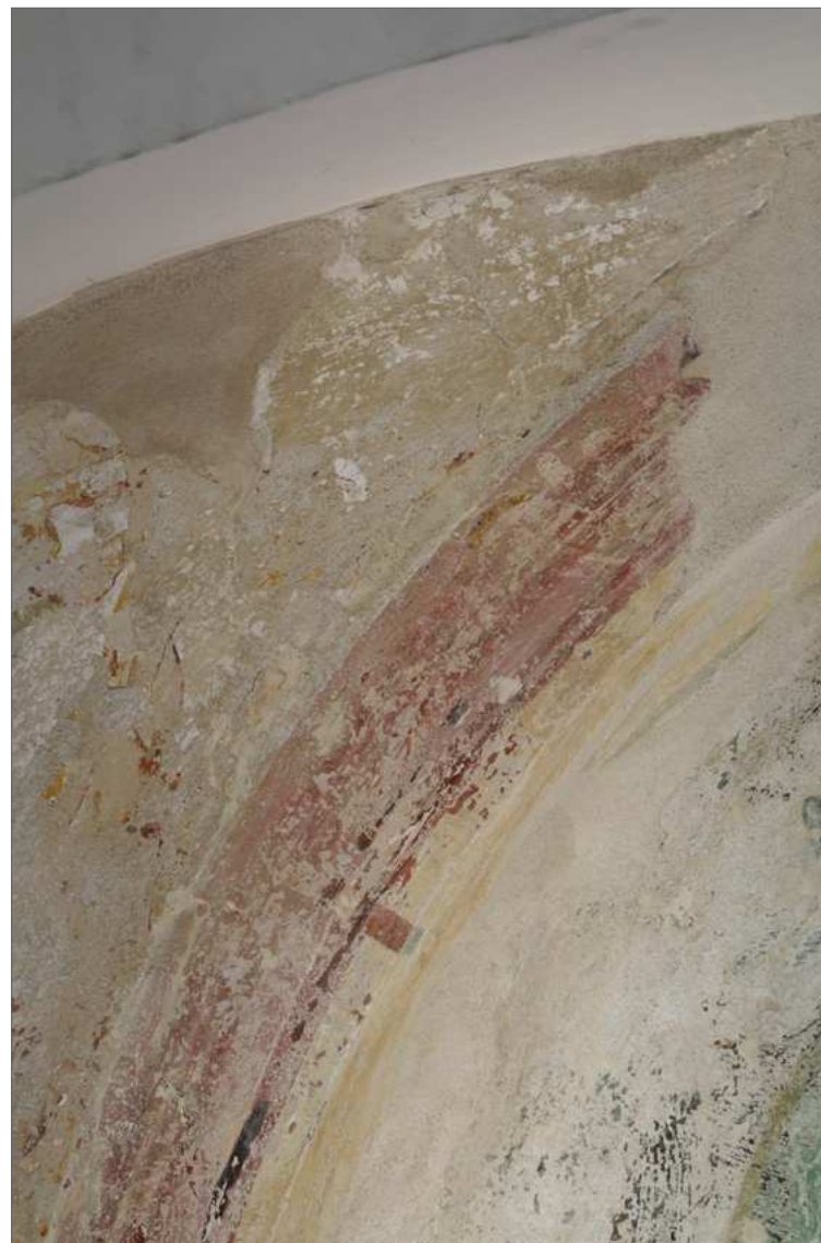
Obr. 73 Horní levá strana restaurované stěny. Stav po vyčištění okrového zákalu.
