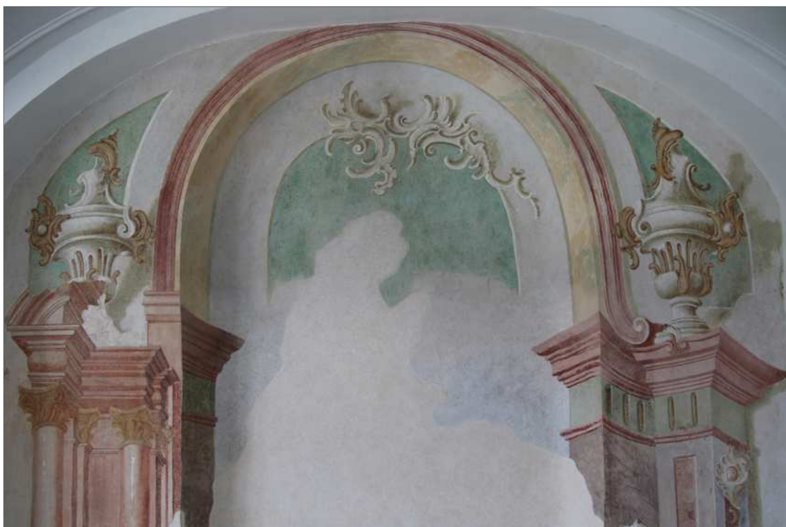
Obr. 92 Pohled na horní polovinu restaurované stěny. Stav po retušování.
