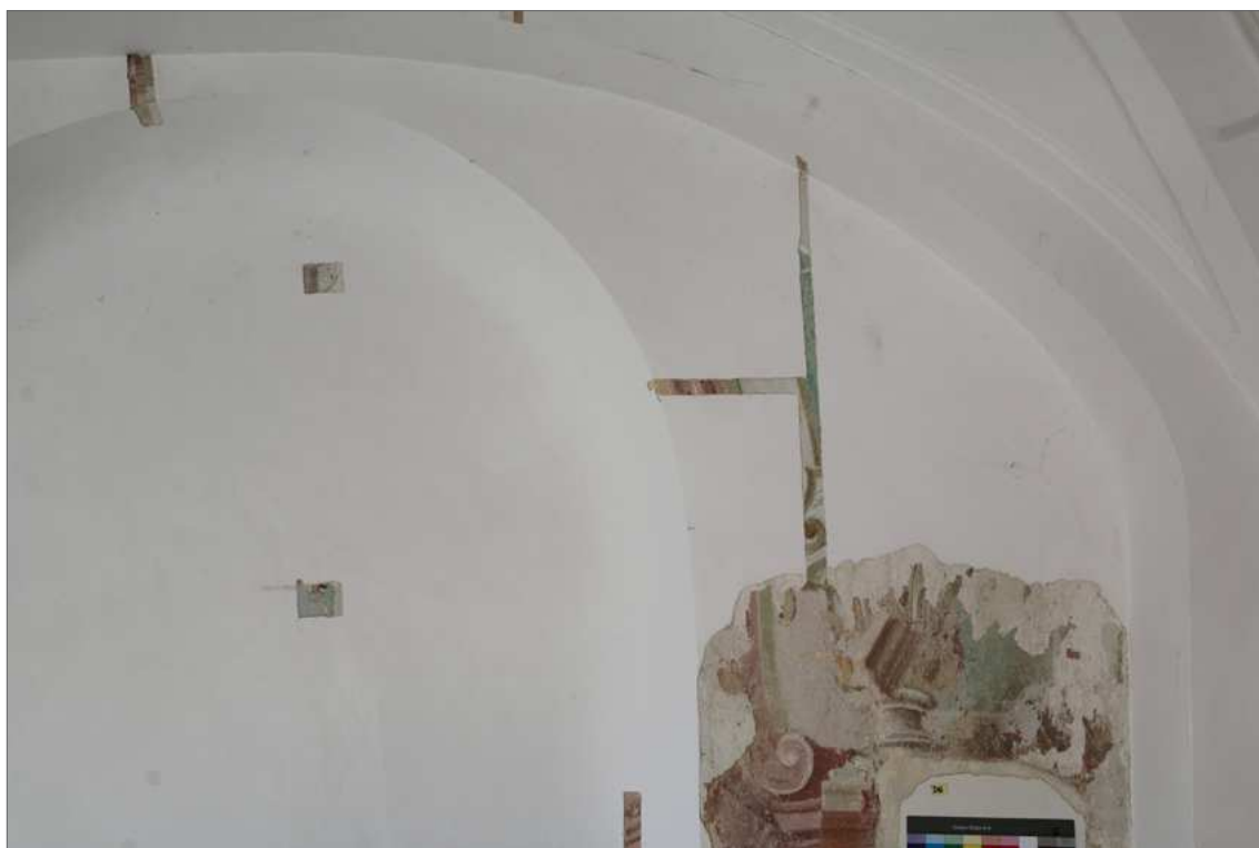
Obr. 17 Pravá horní strana restaurované stěny. Stav před odkryvem.
