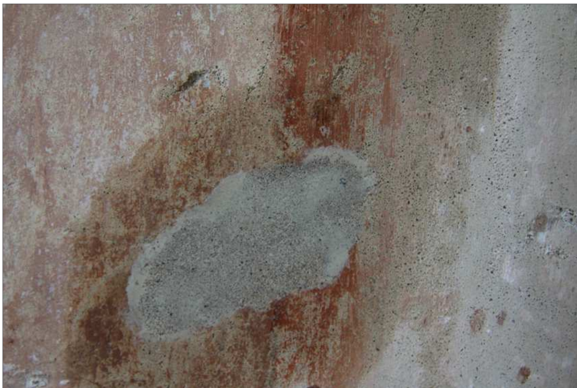
Obr. 71 Detail tmelu na barokní malbě, s hladce kletovanou povrchovou úpravou a dalšími úpravami jemným tmelem v okrajových částech tmelu.
