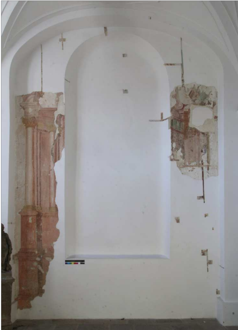
Obr. 15 Celkový pohled na západní oltářní stěnu presbytáře. Stav před odkryvem.
