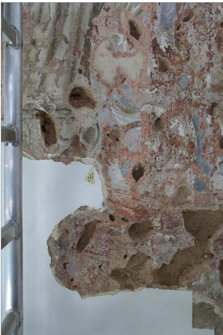
Obr. 49 Detail spodní pravé části malby. Stav po odstranění tmelů a strukturální prekondolidaci vápennou nanosuspenzí CaLoSil E25 .
