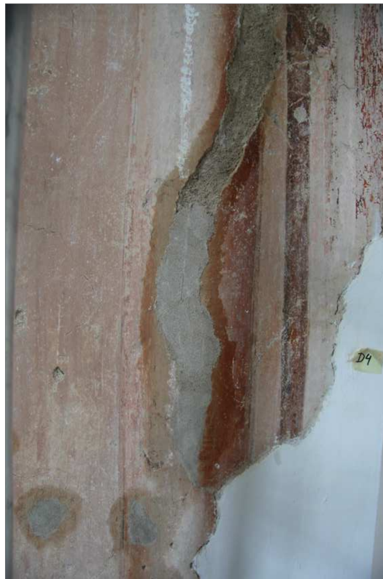
Obr. 69 Proces tmelení statické trhliny ve dvou fázích. První je nanesení a seškrábání povrchu tmelu pod 0,5 cm úroveň barevné vrstvy. Druhá je nanesení do úrovně barevné vrstvy s povrchovou kletovanou úpravou.
