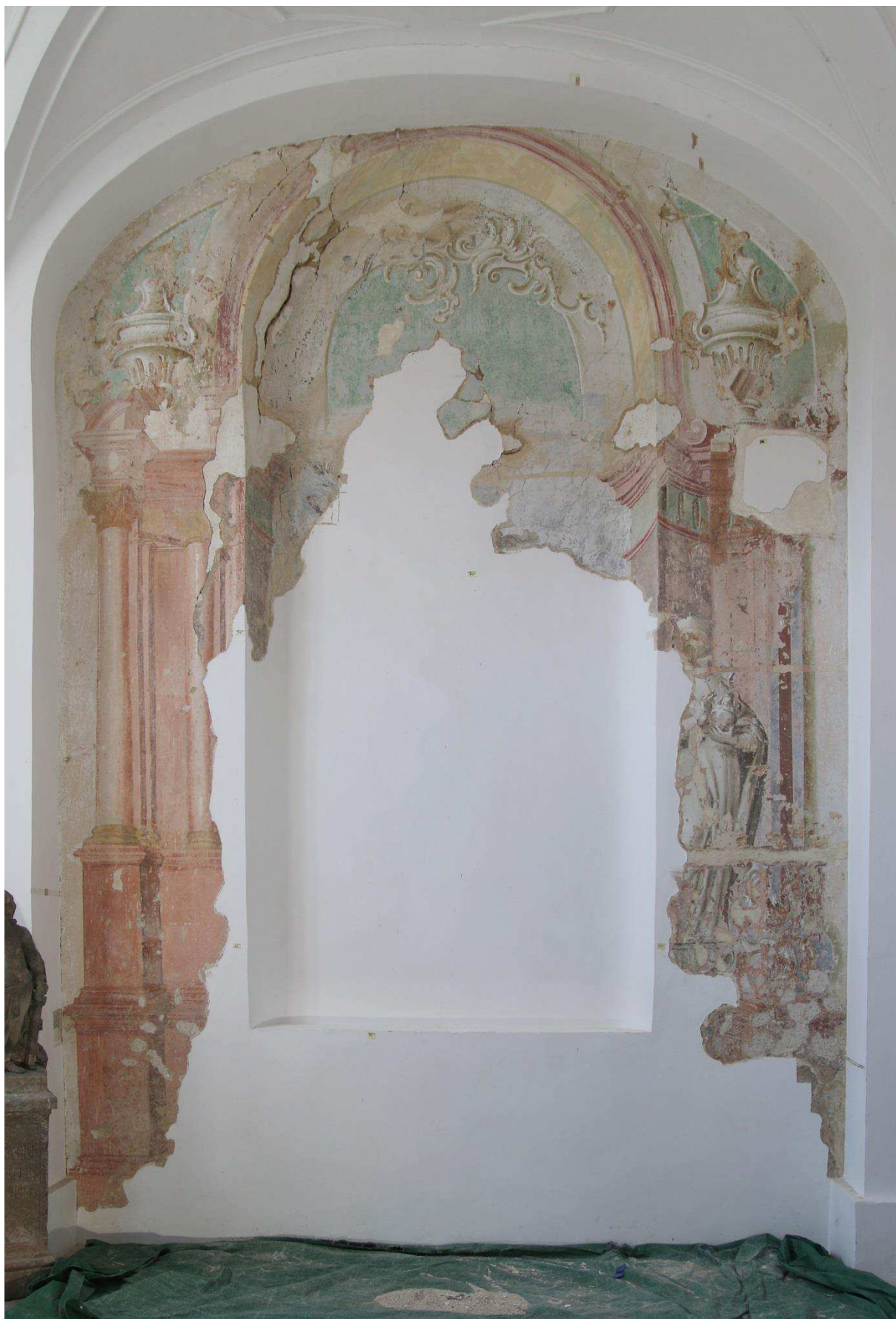
Obr. 04 Celkový pohled na oltářní stěnu. Stav po odkryvu.
