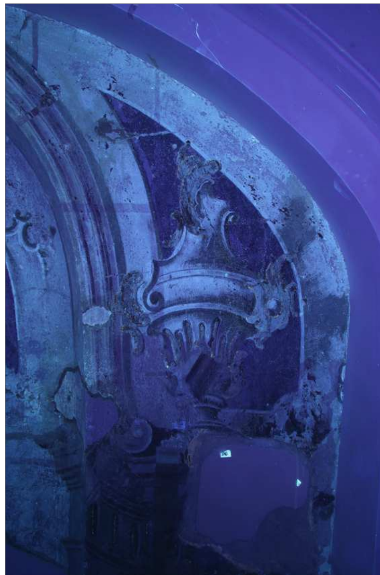
Obr. 46 Vizualní průzkum v UV záření. Horní pravá část restaurované stěny. Stav po odkryvu.
