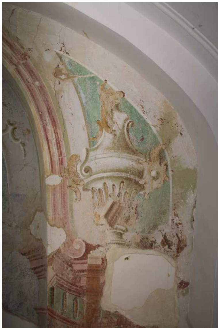
Obr. 45 Vizualní průzkum v rozptýleném denním světle. Horní pravá část restaurované stěny. Stav po odkryvu.
