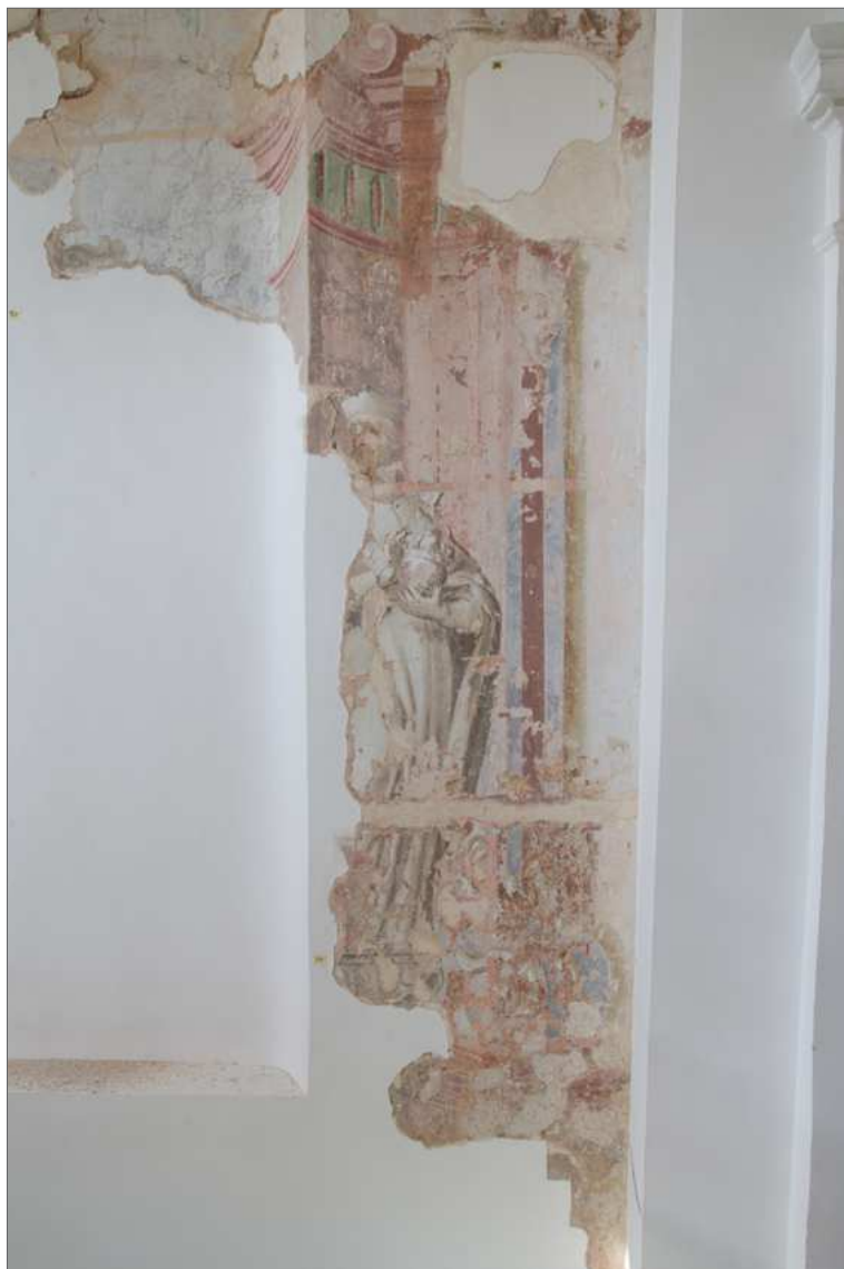
Obr. 93 Pohled na pravou stranu restaurované stěny po odkryvu. Stav po odkryvu.
