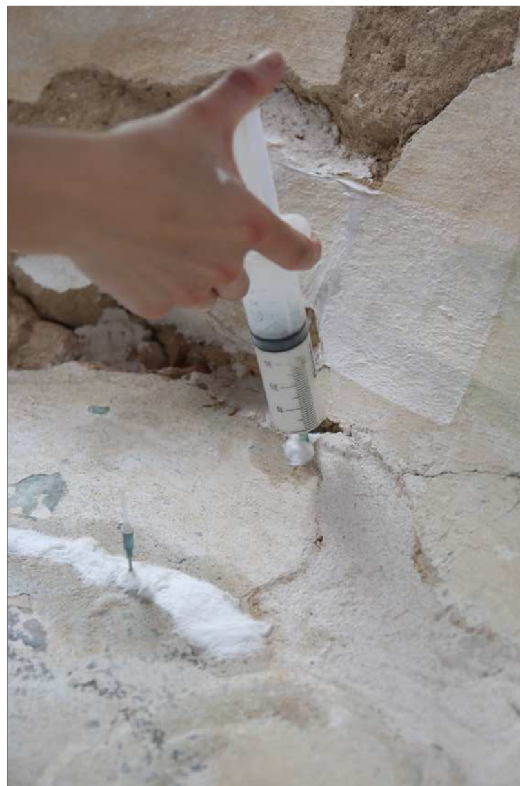
Obr. 65 Detail aplikování injektážní směsi do dutin v oblasti statické trhliny.
