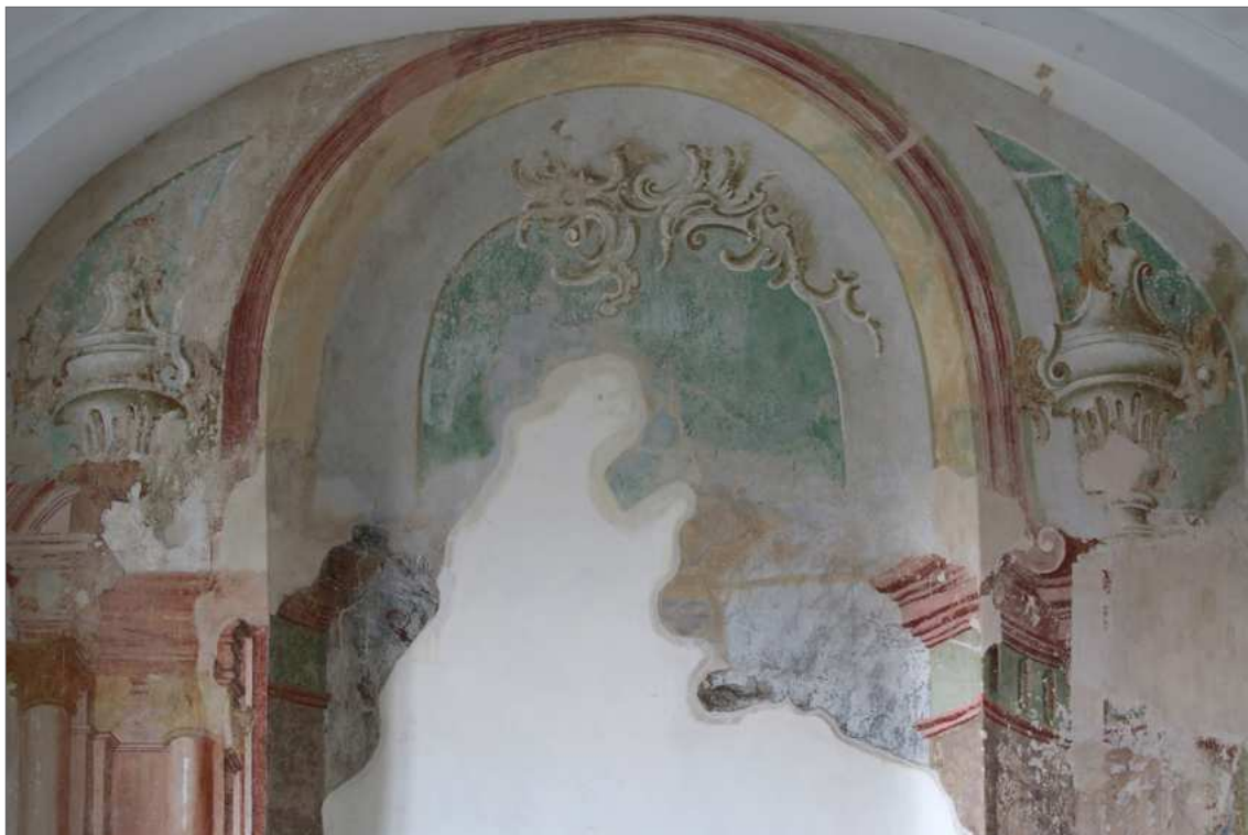
Obr. 91 Pohled na horní polovinu restaurované stěny po aplikaci podkladového nátěru. Stav před retušováním.
