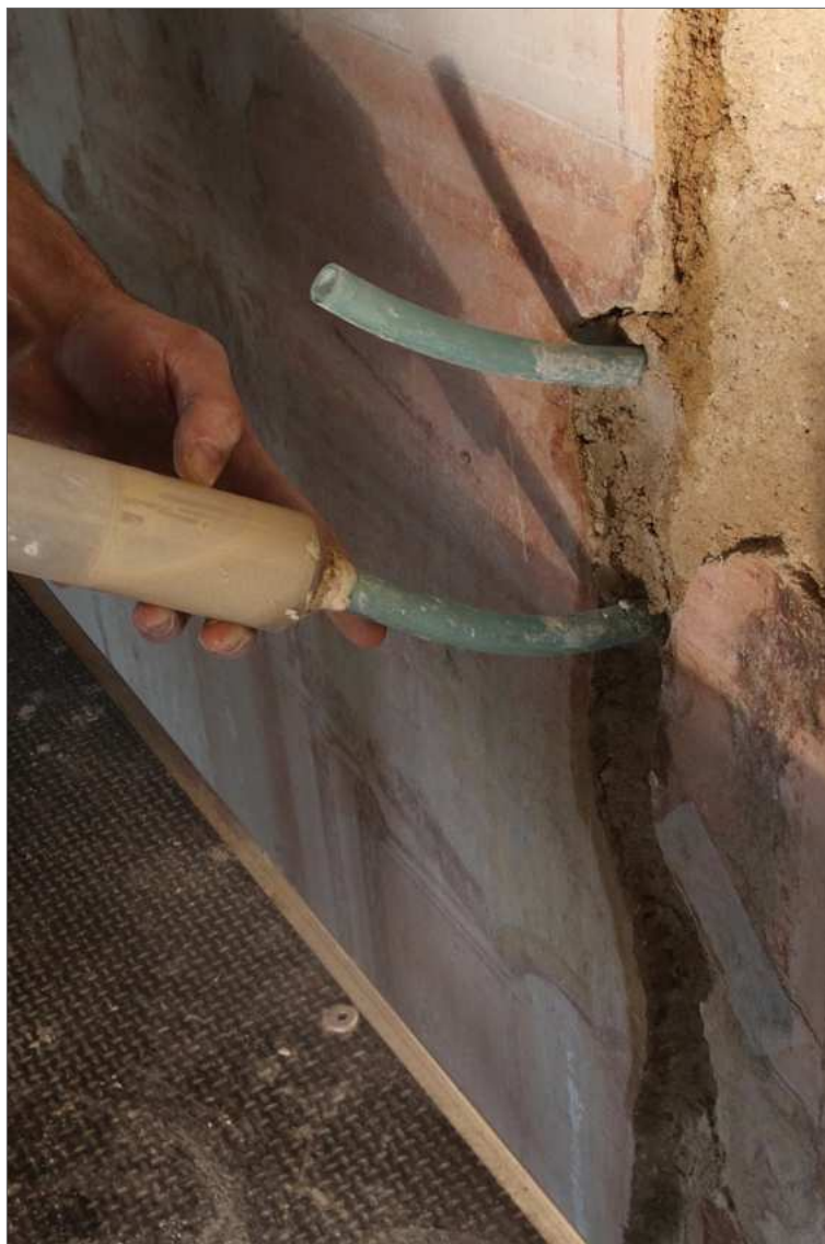
Obr. 67 Injektování předem vytmelené statické trhliny.
