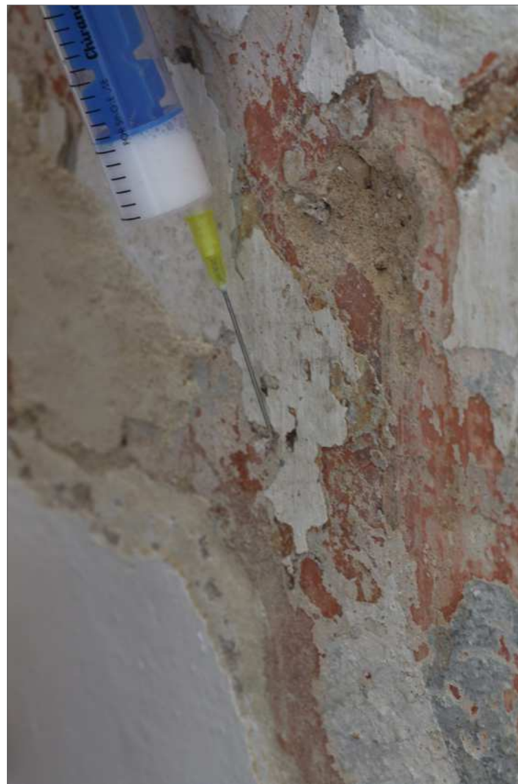
Obr. 61 Detail malby ve spodní části restaurovaného úseku. Lokální zpevňování uvolněných šupin barevné vrstvy 4% (hm.) vodnou akrylátovou disperzí K9.
