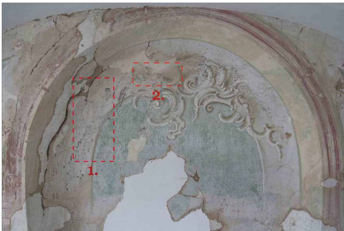
Obr. 52 Lokace zkoušek čištění. V poli 1. se nacházely stékance i zažloutlé skvrny a byla zde aplikována metoda mokrého a mokrého chemického čištění pomocí čisticích štětců za současného mechanického namáhání. V poli 2. se nacházely zažloutlé skvrny větší intenzity, než v poli 1. a byly čištěny formou obkladů.
