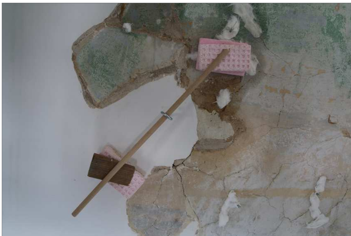
Obr. 64 Injektáž problémové části středové niky za využití přítlačných zařízení, která pomocí tlaku zamezí vyboulení omítky.
