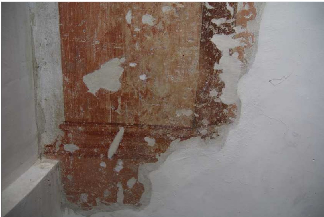
Obr. 79 Soklová část barokní malby s doplněnými tmely a podkladovým nátěrem pro retušování. Stav před retušováním.
