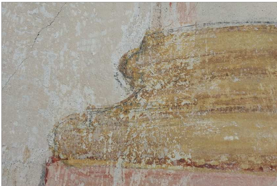
Obr. 27 Detail malby na střední levé straně restaurované stěny. Na barokní malbě je viditelná černá rozkresba. Stav po odkryvu.
