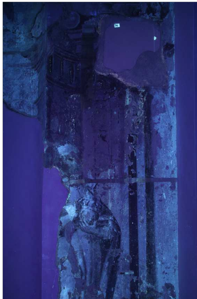
Obr. 42 Vizualní průzkum v UV záření. Střední pravá část restaurované stěny. Stav po odkryvu.
