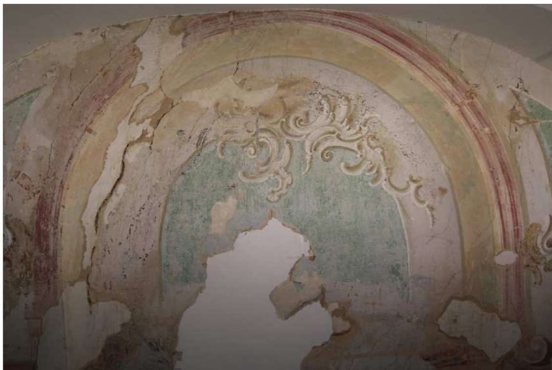
Obr. 43 Vizualní průzkum v rozptýleném denním světle. Horní část niky. Stav po odkryvu.
