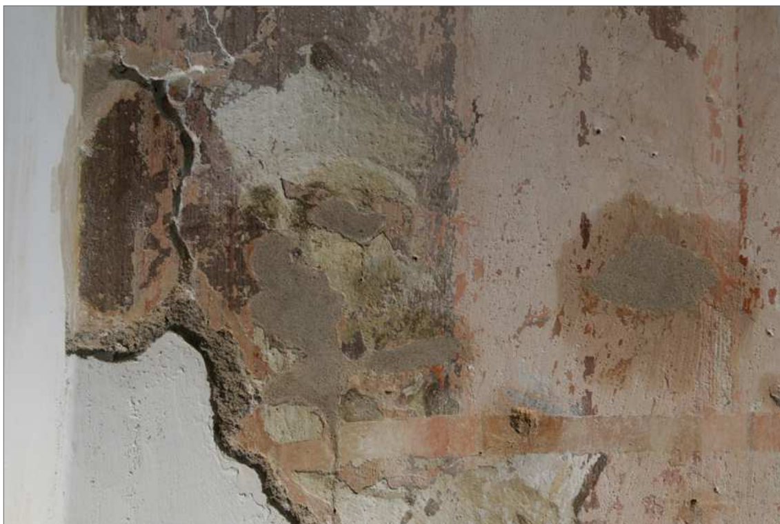
Obr. 70 Tmelení defektů v oblasti hlavy figury. Stav po tmelení.
