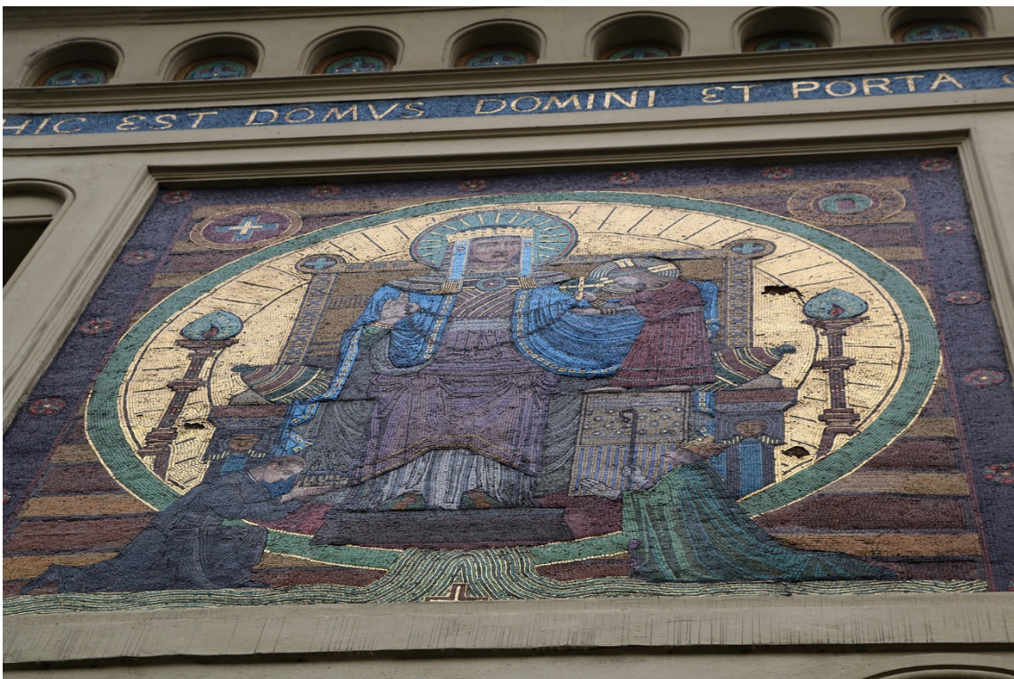
Při bočním pohledu z úrovně chodníku jsou patrné různé úrovně osazení jednotlivých dílů mozaiky.
