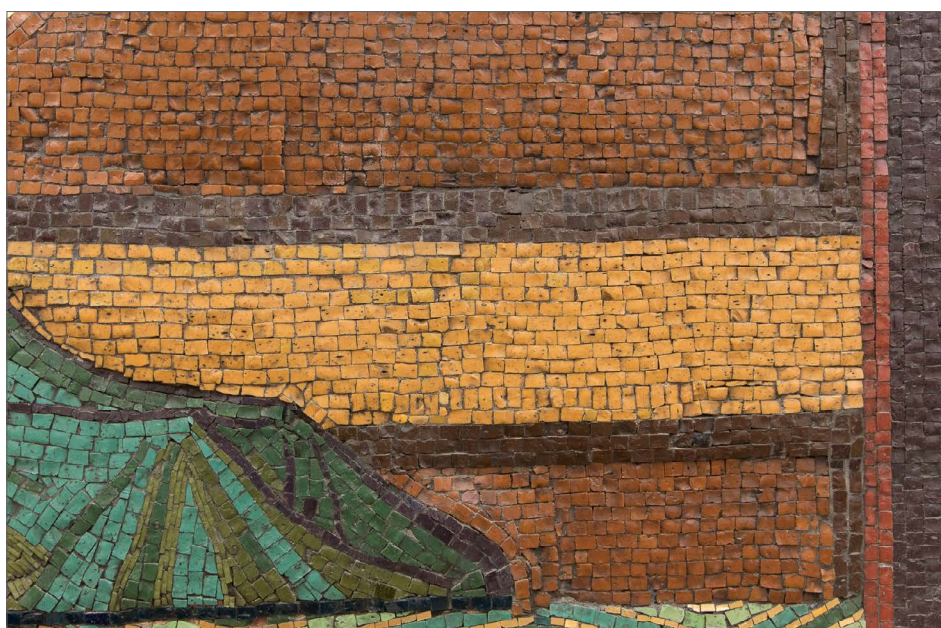
Obr. 38: Sejm ut á část T04/13 – a) po zajištění a očištění ložné malty, b) po sejmutí transfe- ru a očištění lož- né malty, c) po restaurování.
