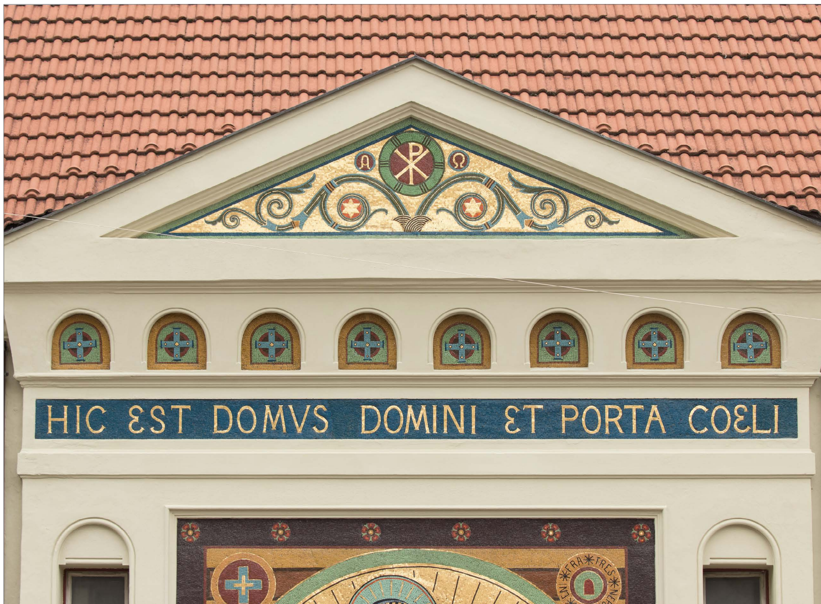
Obr.55: Stav po restaurování – horní část rizalitu s tympanonem čelní fasády.
