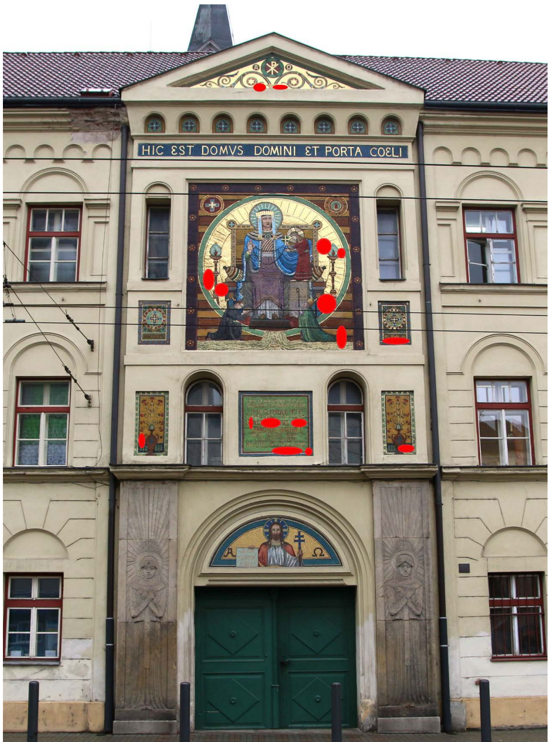
Na obrázku je vyznačení míst, kde budou provedeny kroky č. 3, 5, 6, a 7 tohoto návrhu. Ostatní kroky (s výjimkou č. 2) budou provedeny na celé ploše mozaik.
