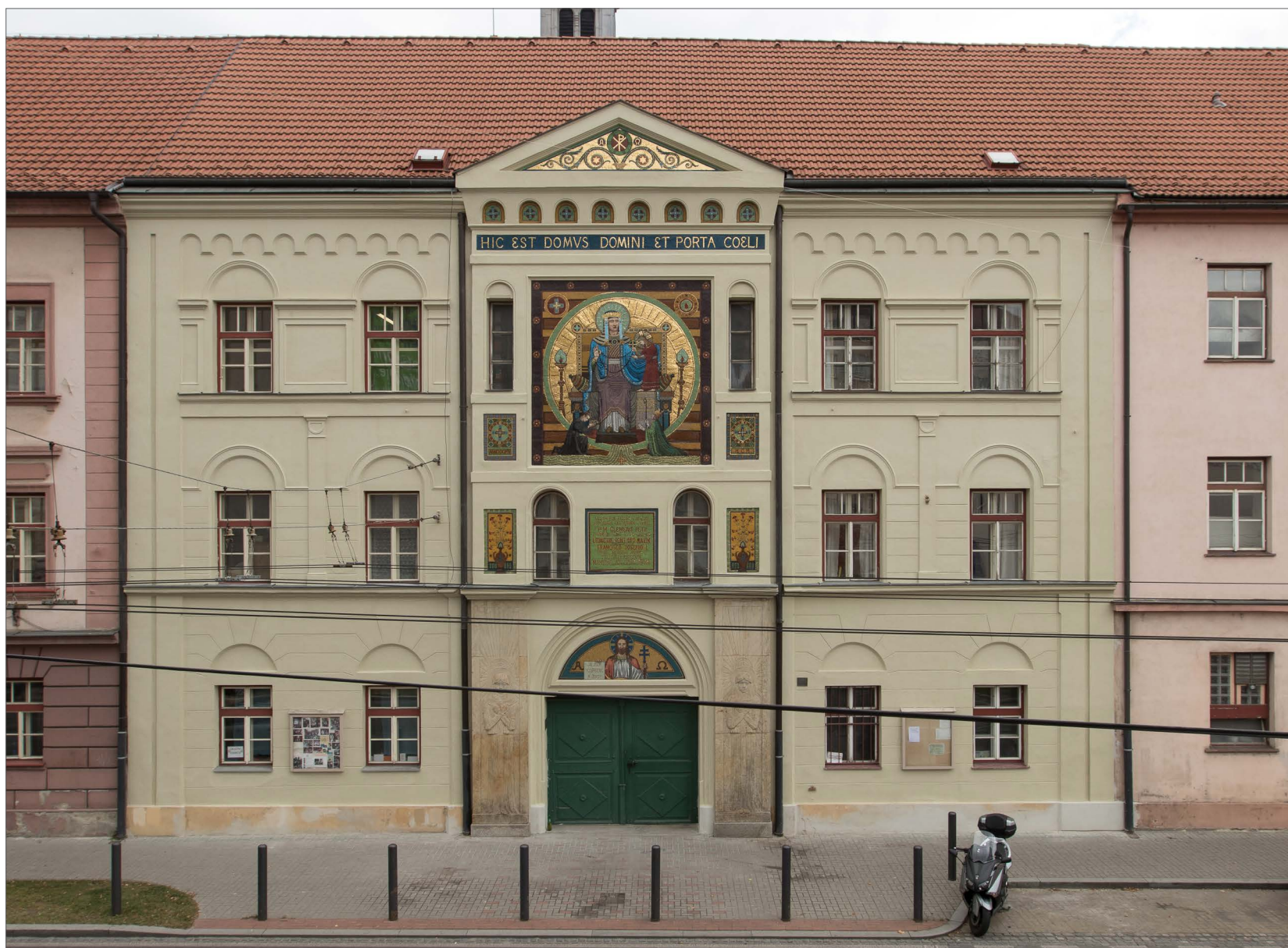
Obr.53: Stav po restaurování – celkový pohled na čelní fasádu domu na Žižkově třídě 512.
