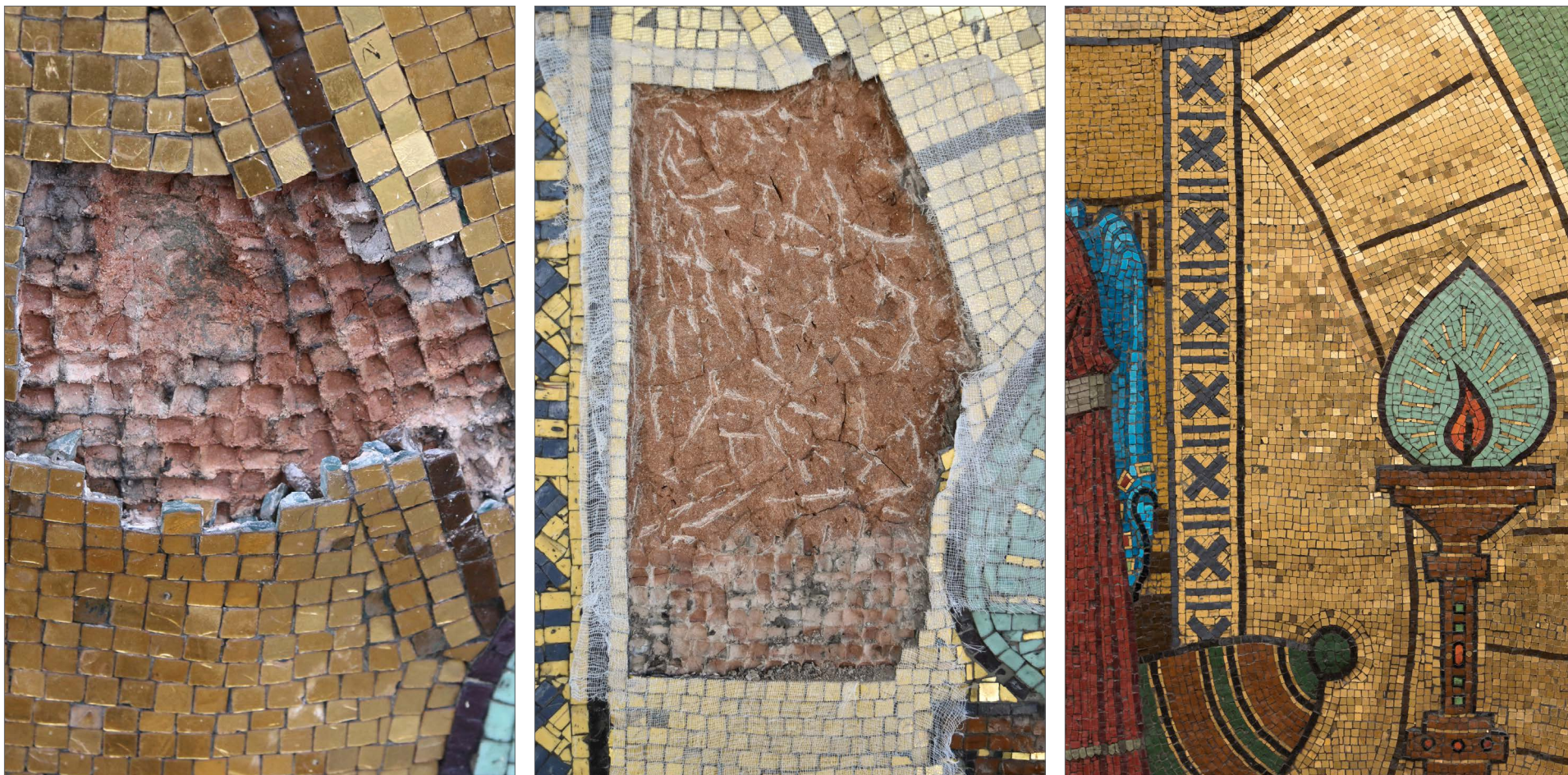
Obr. 33: Sejmutá část T04/8 – a) před restaurováním, b) po sejmutí transferu a v průběhu očištění ložné malty, c) po restaurování.
