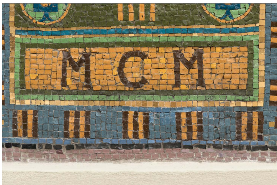
Obr.44: Sejmутá část T06/1 – a) před restaurováním, b) po sejmutí transferu a očištění ložné malty, c) po restaurování.
