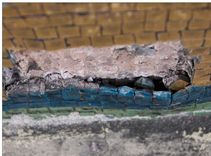
Obr.26: Sejmутá část T01/1 – a) před restaurováním, b) před restaurováním, c) po sejmutí a očištění původní ložné malty, d) po restaurování.
