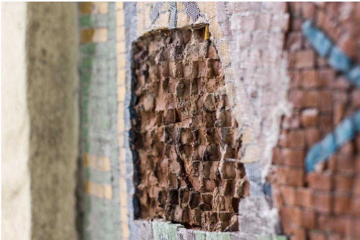
Obr. 20 Místo odběru vzorku osazovací malty mozaiky, detail.
