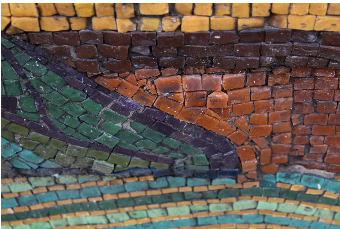
Lokálně dochází také uvolňování jednotlivých kostek, které může vyústit v rozsáhlejší poškození.
