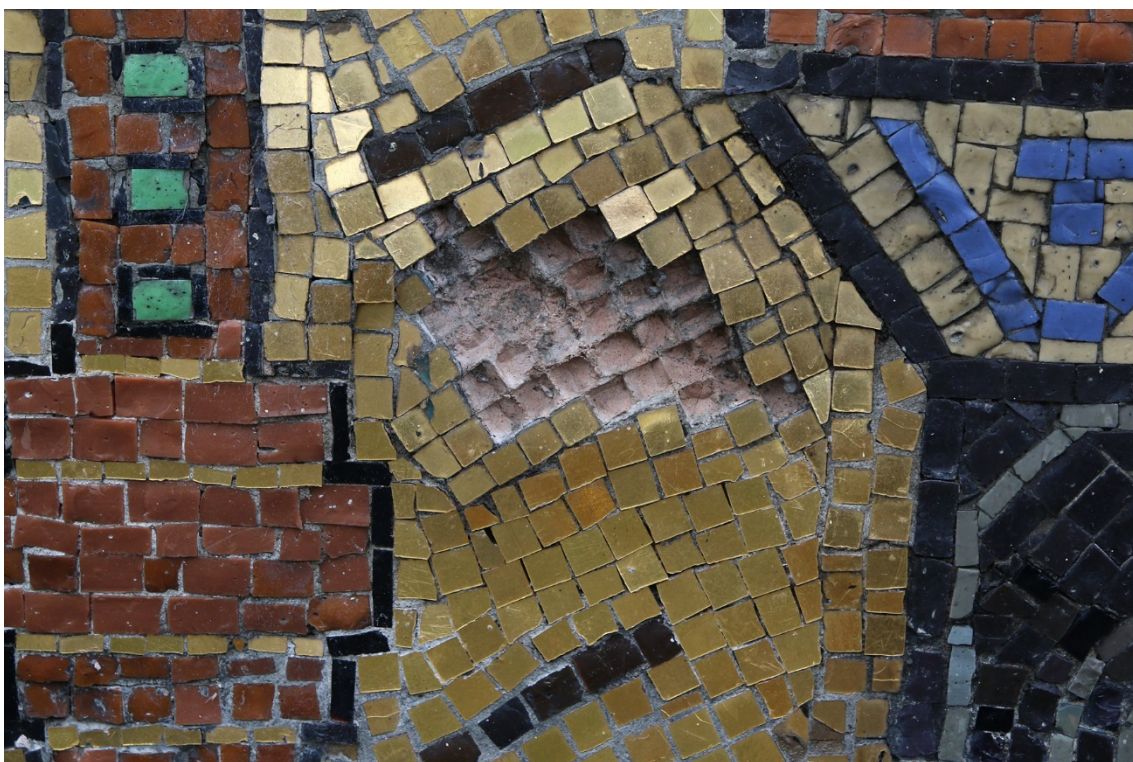
Ke ztrátě kostek dochází i v blízkosti dříve opravovaných partií.
