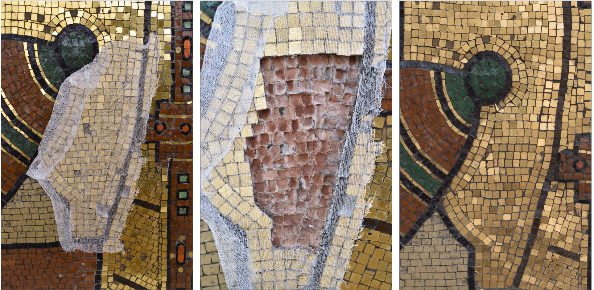
Obr. 35: Sejmutá část T04/10 – a) po zajištění, b) po sejmutí transferu, c) po restaurování.
