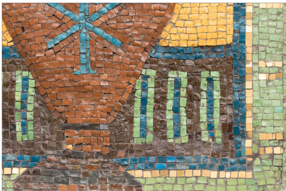
Obr. 49: Sejm ut á část T09/1 – a) po za- jištění, b) po sejmutí transferu a očištění ložné malty, c) po restaurování.
