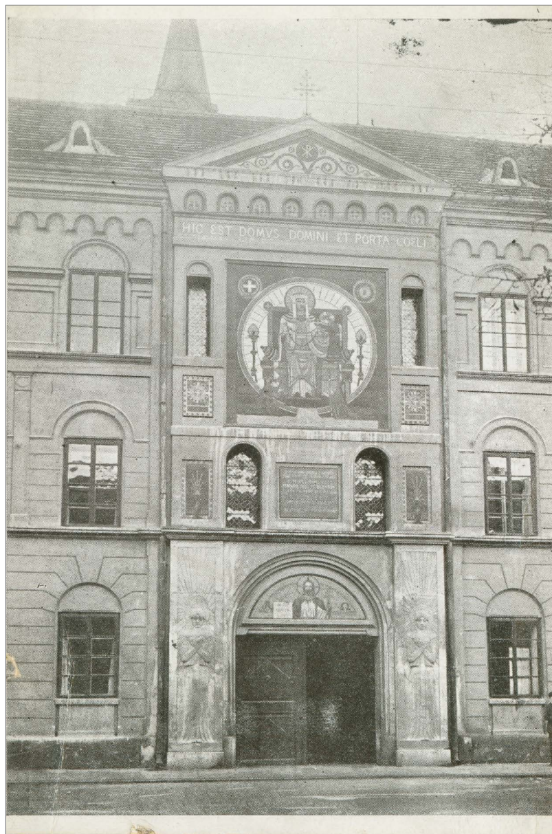
Obr.01: Historická fotografie – rizalit čelní fasády domu na Žižkově třídě 512 (nedatováno – pravděpodobně před rokem 1948, kdy byla zavedena trolejbusová doprava).
