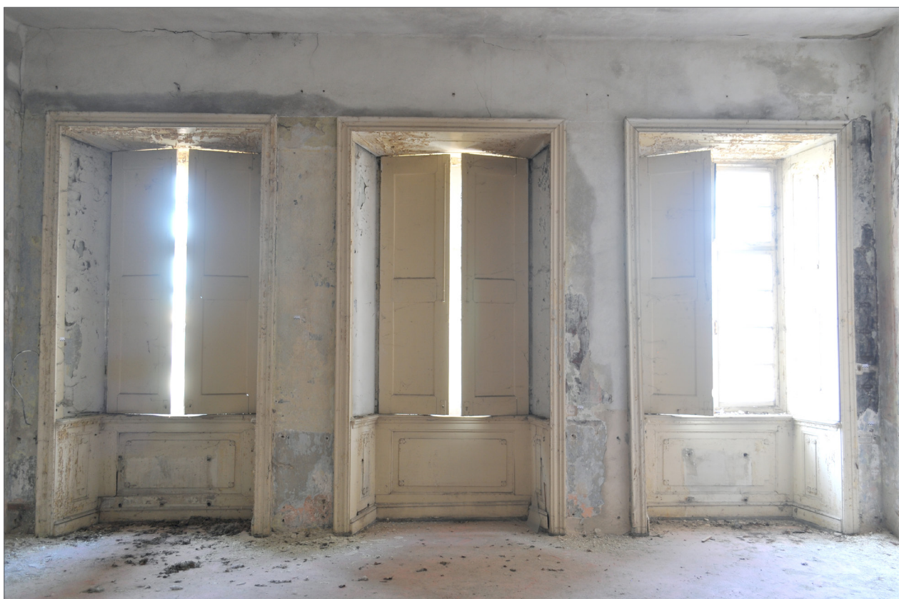
Obr. 11 Místnost 3 „Renesanční“ - severní stěna celkový pohled
