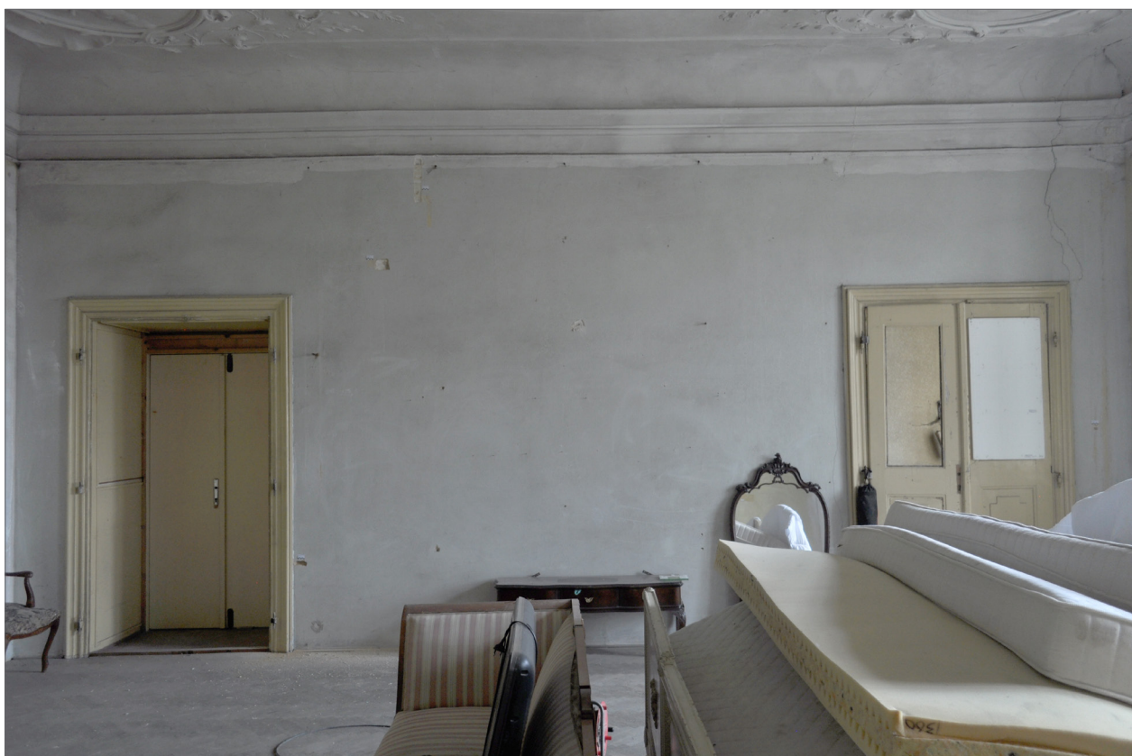
Obr.01 Místnost 1 „Jídelna“ - východní stěna celkový pohled
