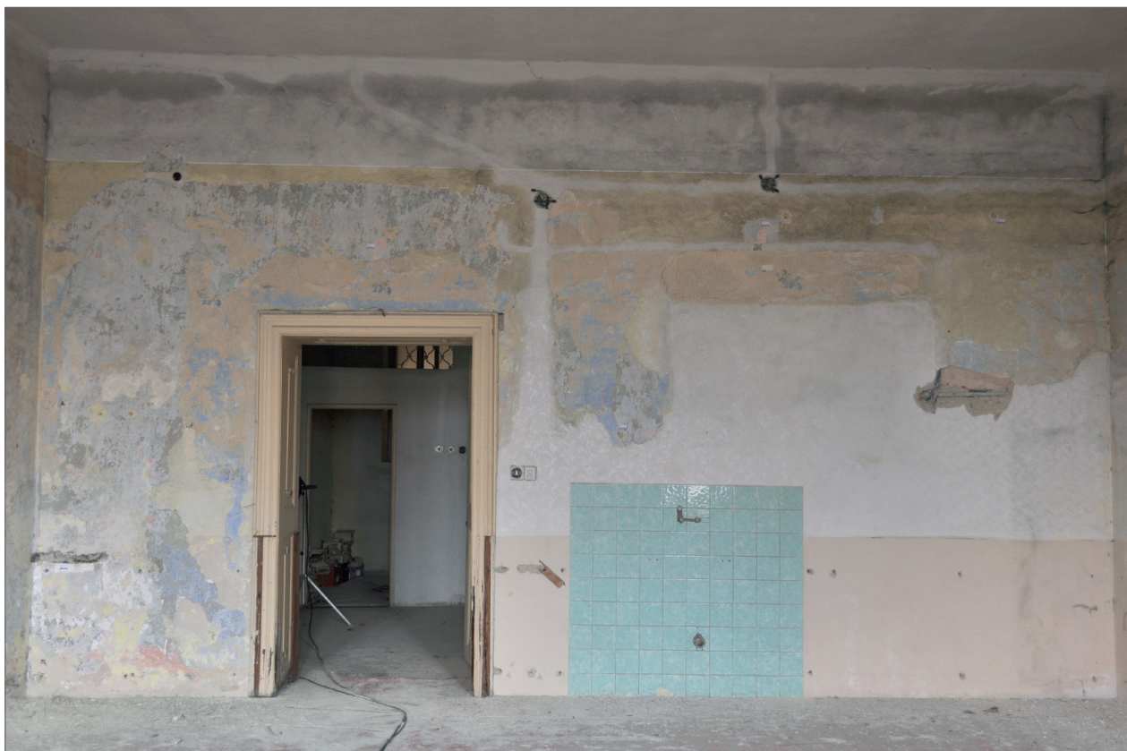
Obr.09 Místnost 3 „Renesanční“ - jižní stěna celkový pohled
