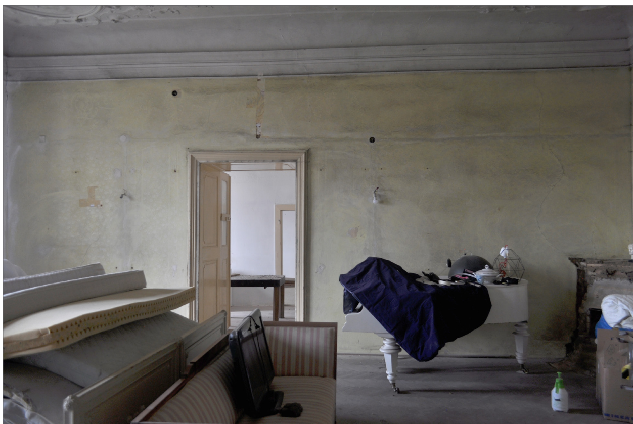
Obr.03 Místnost 1 „Jídelna“ - západní stěna celkový pohled
