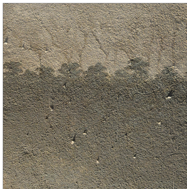
Obr.19 Veduty - Detail transparentních stékanců nacházejících se na výjevech. Na spodním okraji stékanců dochází k odlupování barevné vrstvy
