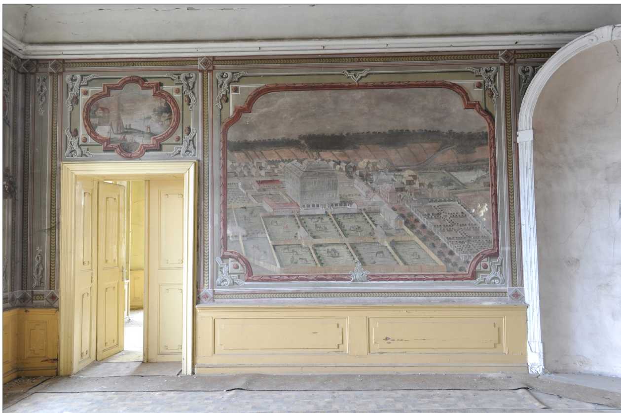
Obr.07 Místnost 2 „Veduty“ - východní stěna celkový pohled
