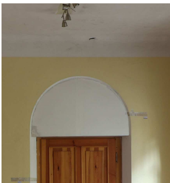
Obr.04 Zaslepení oblouku původně půlkruhového zakončení vstupu.
