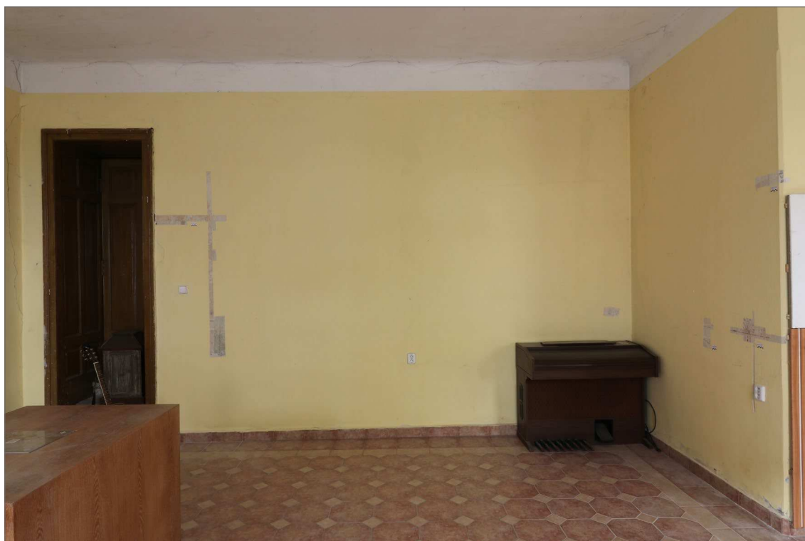
Obr. 10 Celkový pohled na jihovýchodní stěnu.
