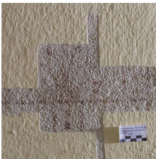
Obr.14 Sonda odkryté nejstarší barevné dekorativní vrstvy v bočním nasvícení. Patrná hrubost povrchu.
