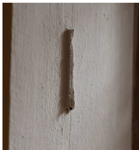
Obr.05 Pozůstatek druhotného, nyní odstraněného zaslepení oken.
