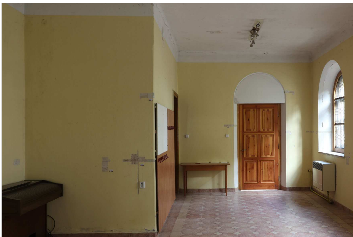
Obr. 12 Prává polovina severozápadní stěny.
