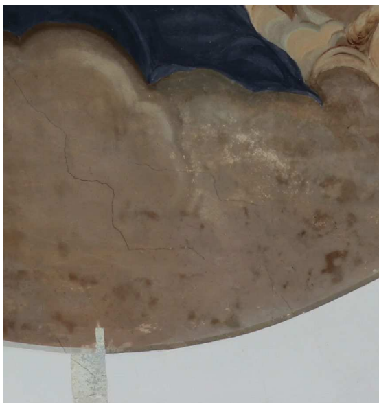
Obr.02 Detail trhlin a tmavých skvrn nacházejících se na figurálním výjevu.
