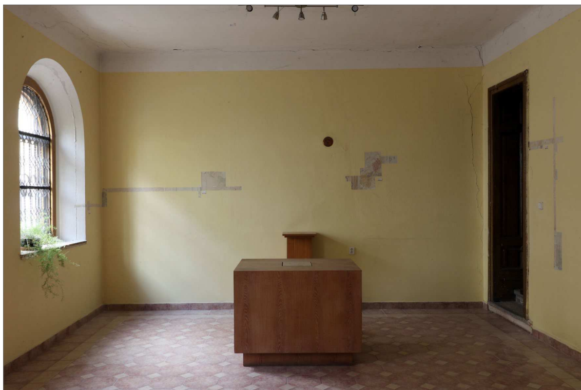
Obr.09 Celkový pohled na jihozápadní stěnu.
