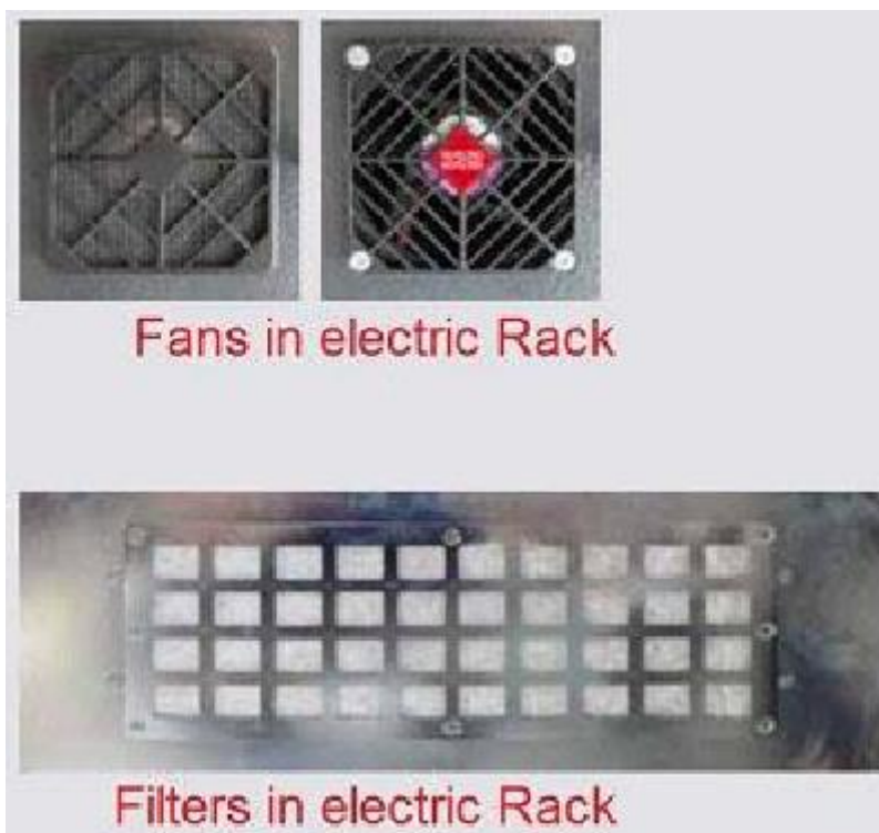
5. Čištění filtrů elektrického stojanu
