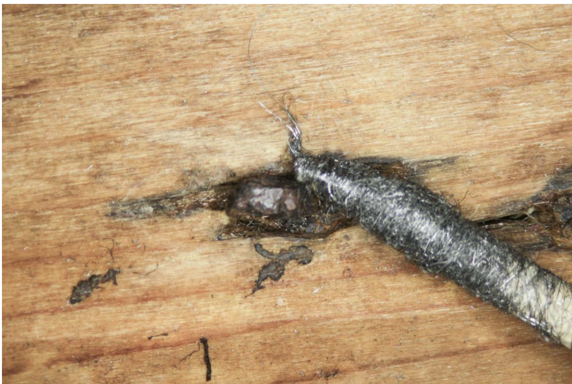
Foto. 23 Mechanické čištění ocelových hřebíků fixující řemínky k desce
