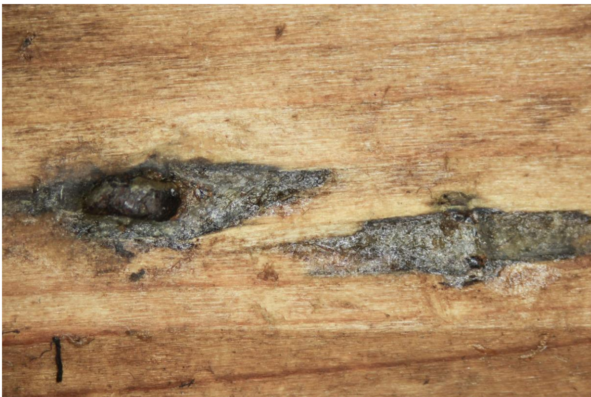
Foto. 25 Doplnění ztrát dřevěné desky v okolí ocelových hřebíků
