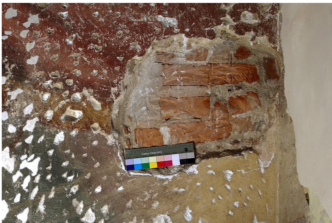
Obr. 69 Sekvence oblasti defektu po instalaci topení. Stav po konsolidaci, injektáži, dozdění a obtmelení.
