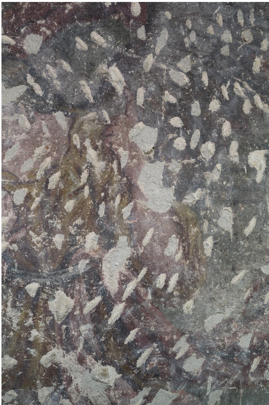
Obr. 20 Detail figury anděla. Na povrchu je viditelný zákal a residua druhotné omítky vyplňující peky. Stav před restaurováním.
