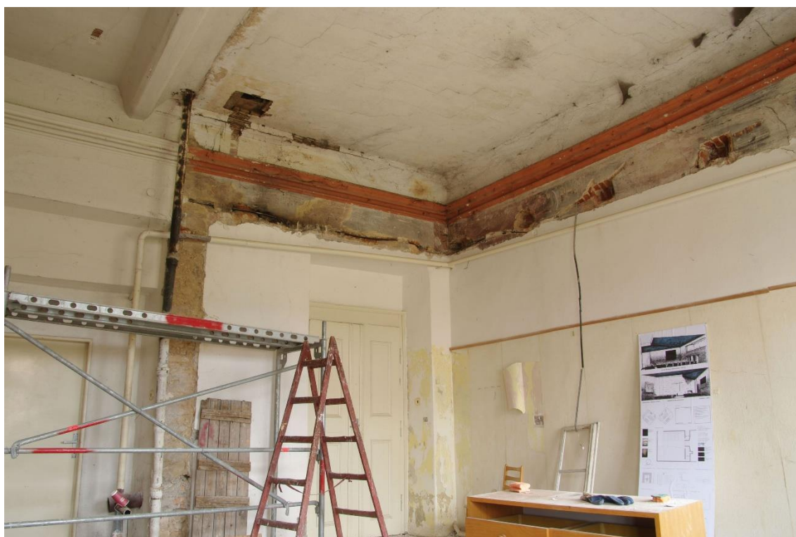
Obr. 12 Fotografie pořízená po odstranění přepážky a stropních trámů. Autor fotografie: Akad. mal. Jana Frühaufa.
