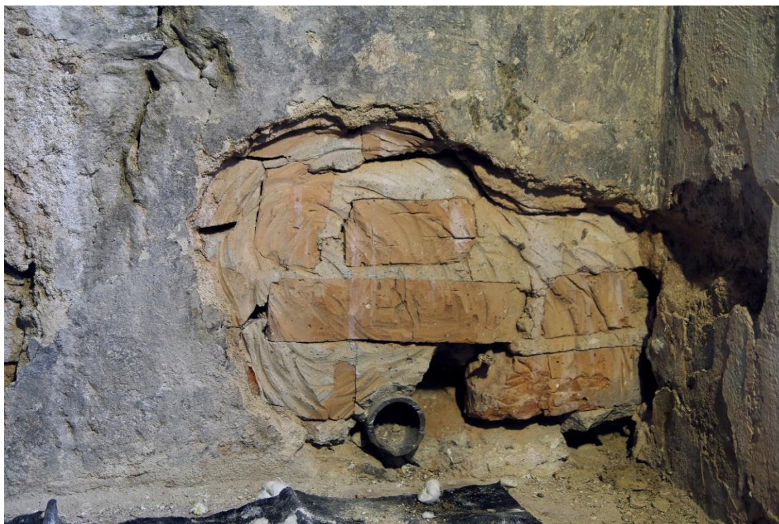
Obr. 41 Detail soklové části v okolí elektrifikace a topení, stav po odkryvu a odstranění druhotného, šedého tmelu.
