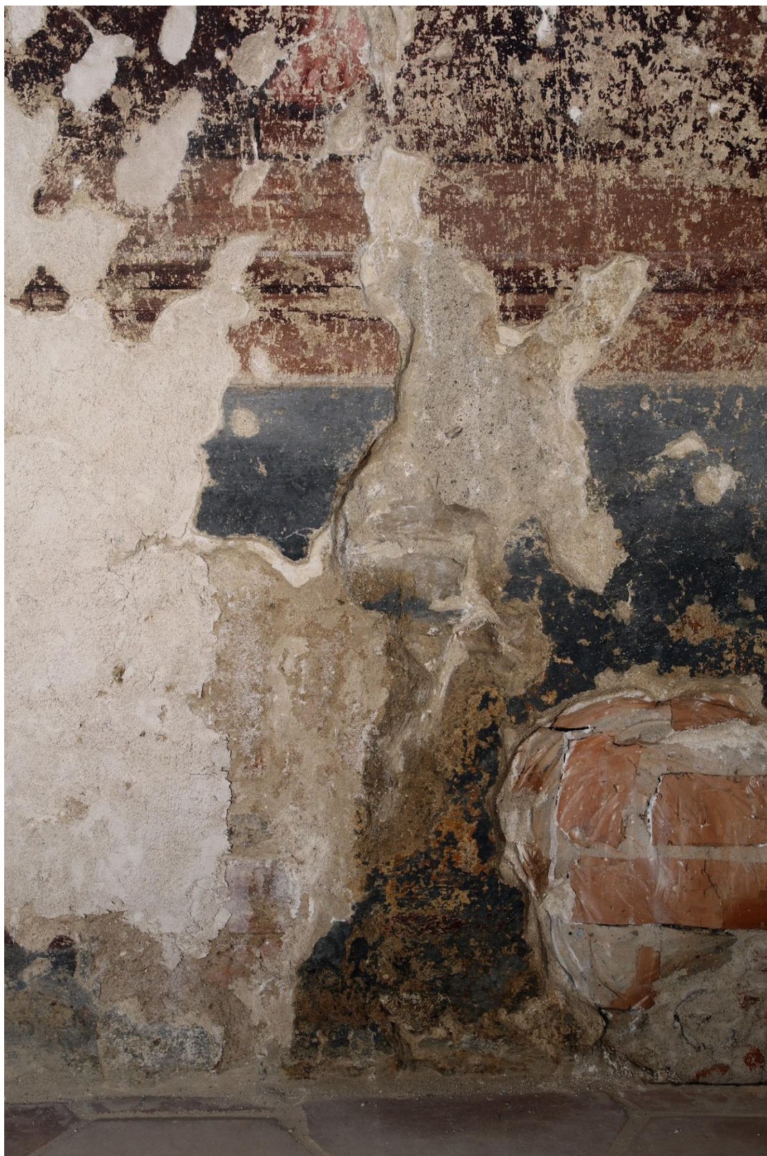
Obr. 47 Detail soklové části, část s druhotným šedomodrým nátěrem překrývajícím původní dekor s iluzivním mramorováním. Druhotná vrstva je neoddělitelně spojena s fragmenty původní malby – její odstranění nebylo možné bez ztrát. Stav po čištění.
