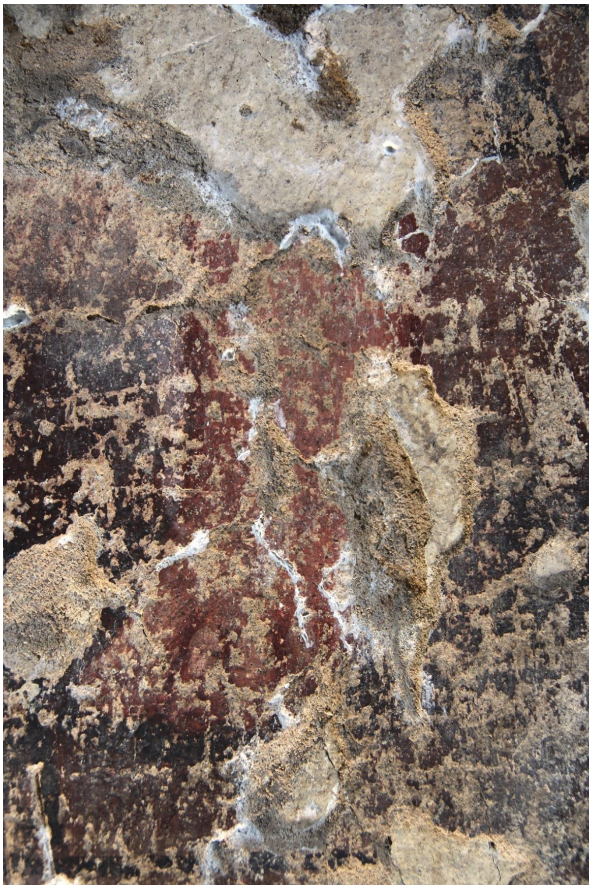
Obr. 45 Detail poškozeného levého chodidla, stav po konsolidaci, injektáži a částečném obtmelení.
