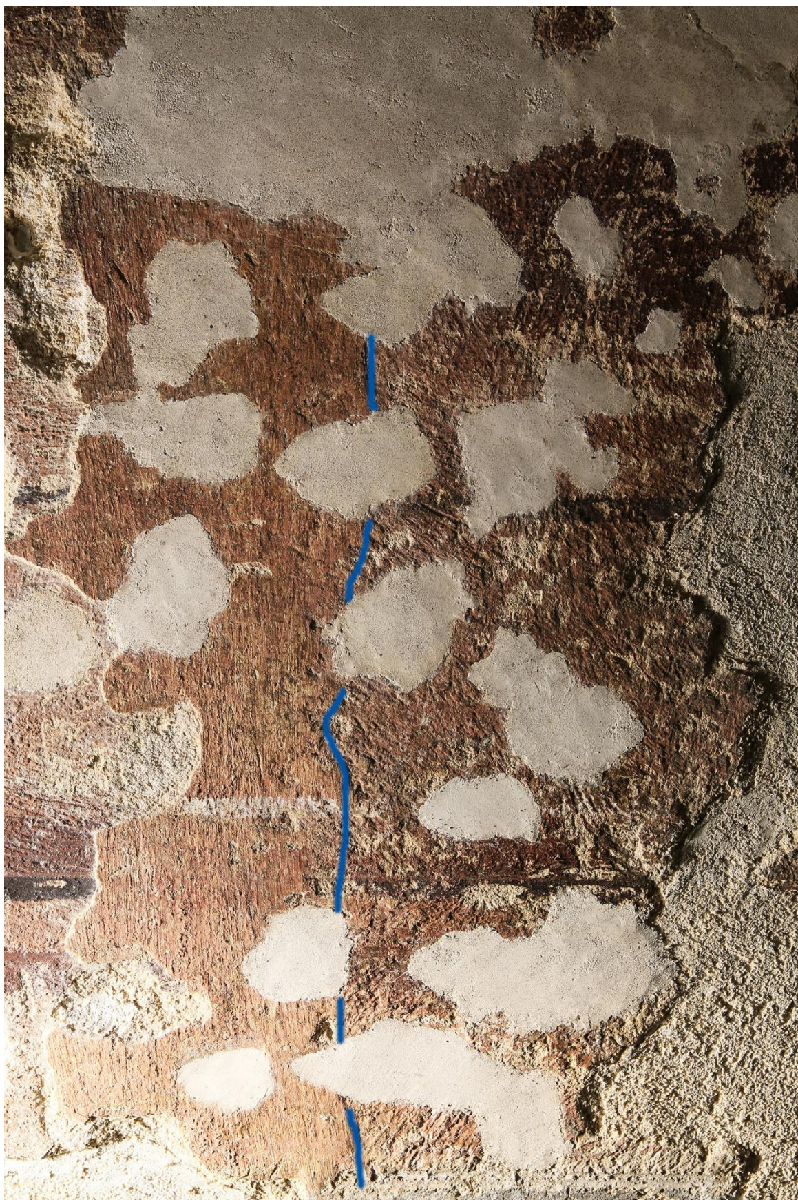
Obr. 38 Detail malby v ostrém bočním nasvícení. Modrou linkou je označeno rozhraní dorovnávací vrstvy a vrstvy s původní barokní malbou. Stav v průběhu tmelení.
