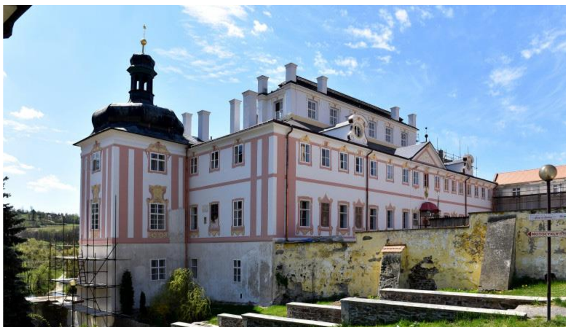
Obr. 06 Pohled na zámek ze severo-východní strany, stav po rekonstrukci v roce 2020. Zdroj fotografie: https://www.zamek-kacov.cz/ .
