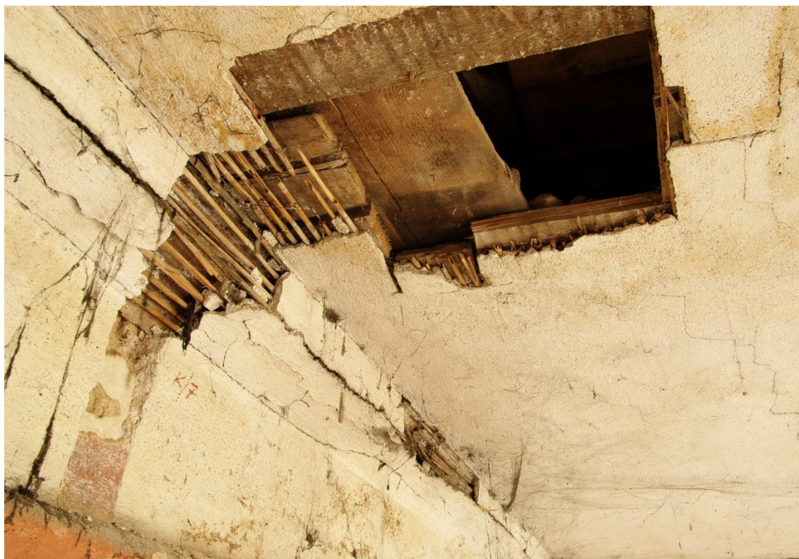
Obr. 13 Fotografie pořízená při odstraňování stropů. Autor fotografie: Akad. mal. Jana Frühaufa.
