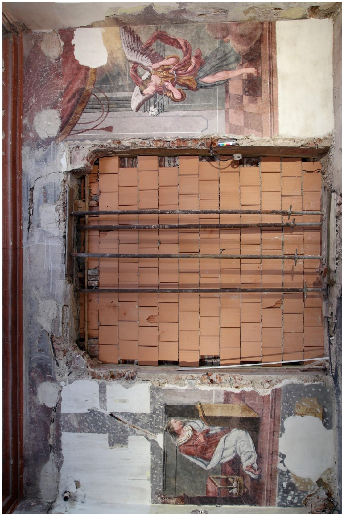
Obr. 63 Celkový pohled na jižní stěnu. Stav po restaurování.
