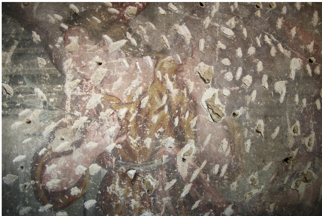
Obr. 40 Detail poškozeného povrchu v ostrém bočním nasvícení zobrazující rozsah poškození pekováním a škrábance. V pecích je patrná tmavá historická omítka s bílým nátěrem. Stav po odkryvu.
