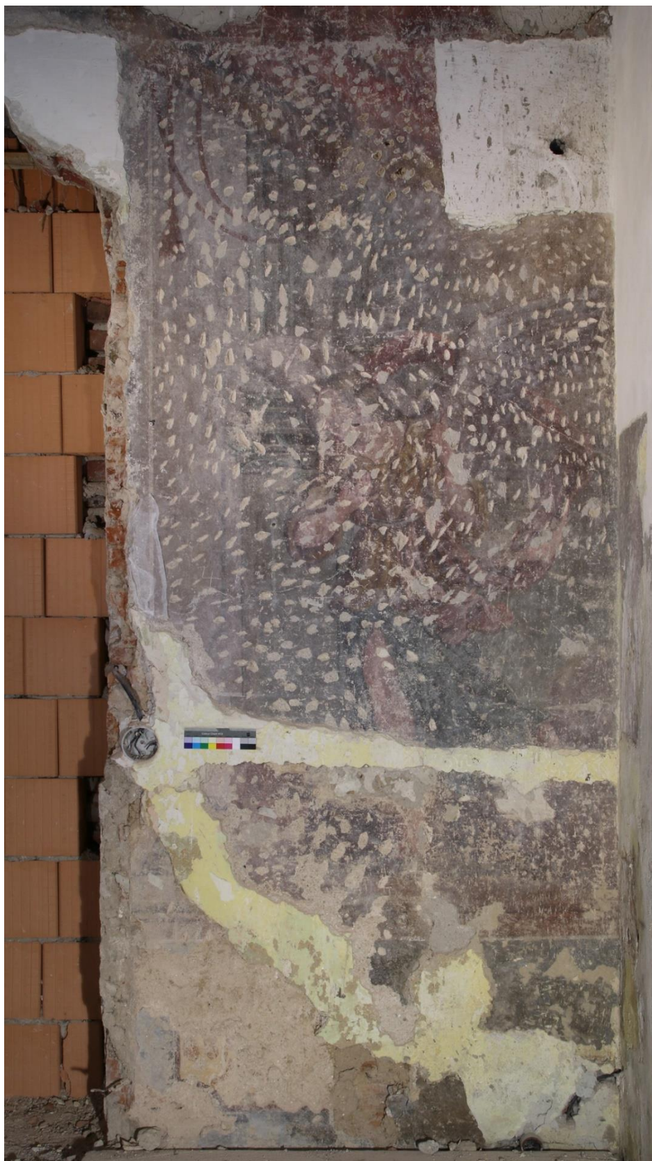
Obr. 17 Celkový pohled na restaurovaný úsek s archandělem Gabrielem. Stav před restaurováním.
