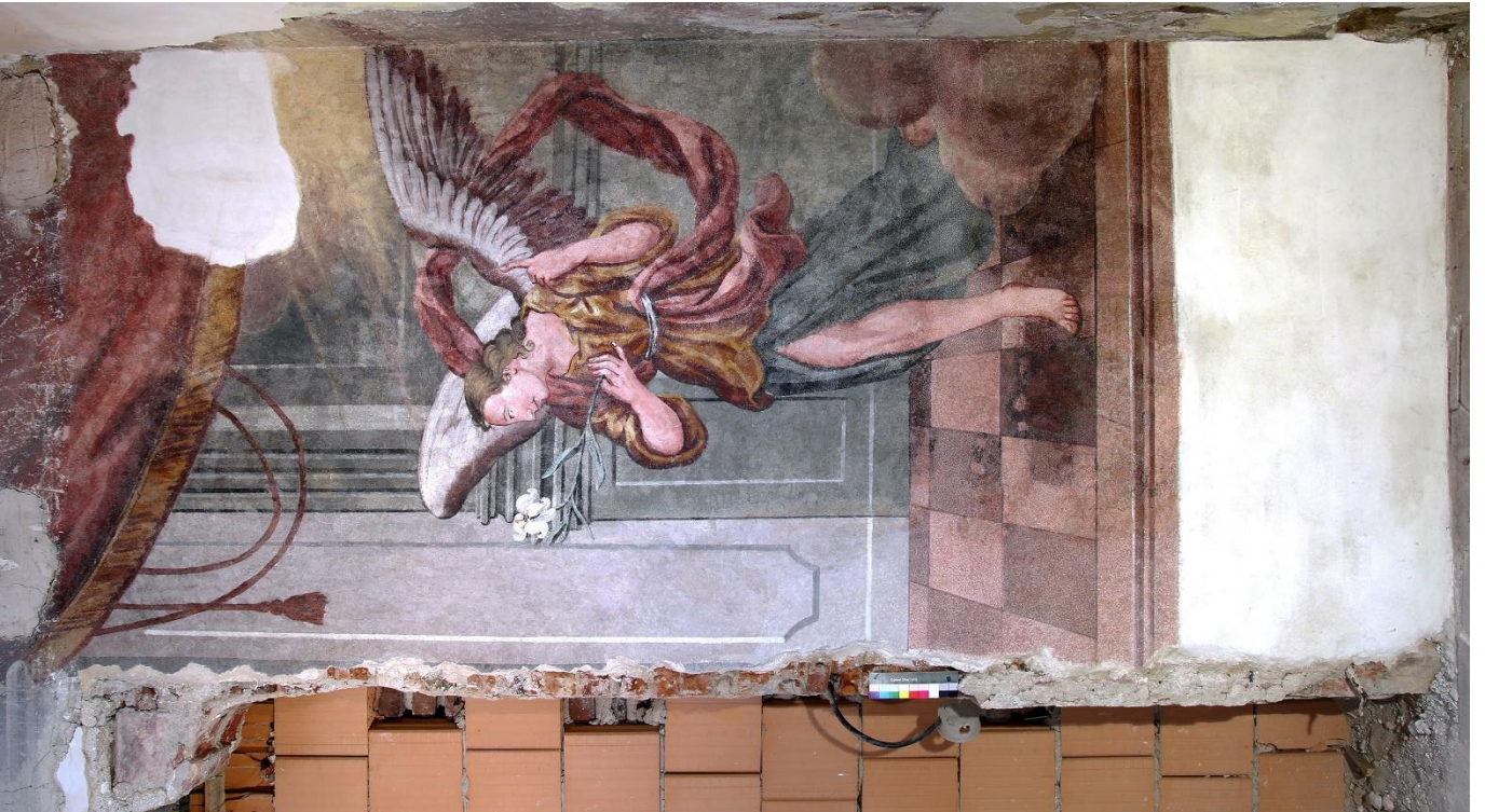
Obr. 66 Sekvence, celkového úseku. Stav po tmelení.
