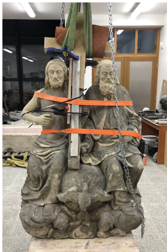
Obr. 95 Osazování výdusků z umělého kamene
