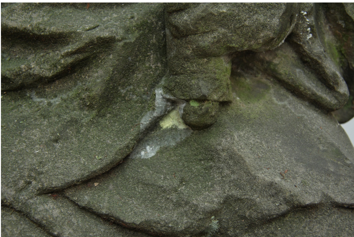
Obr. 45 Stav před restaurováním – detail povrchu s plísní
