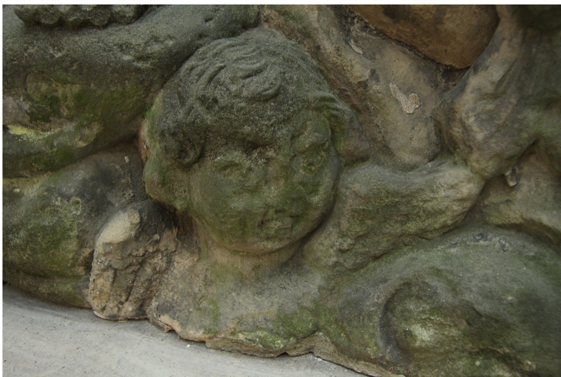
Obr. 47 Stav před restaurováním – detail levé okřídlené hlavy anděla
