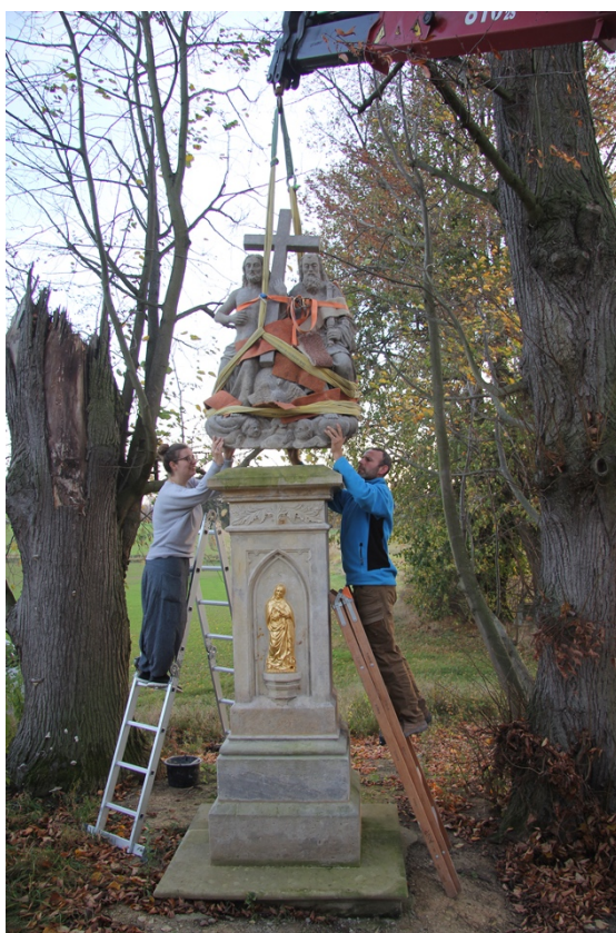
Obr. 101 Osazení sousoší na podstavec pomocí auta s hydraulickou rukou
