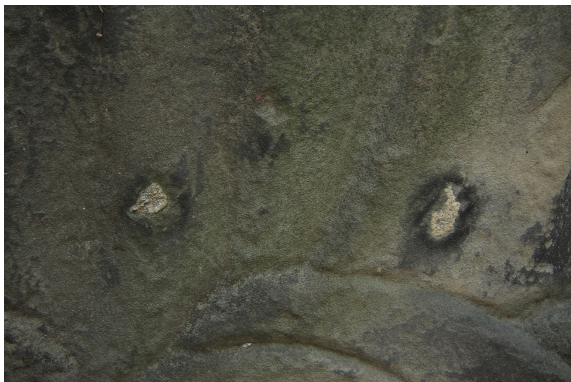
Obr. 50 Stav před restaurováním – detail se zbytky světlé povrchové úpravy a s malým fragmentem červené barvy (v horní polovině uprostřed)
