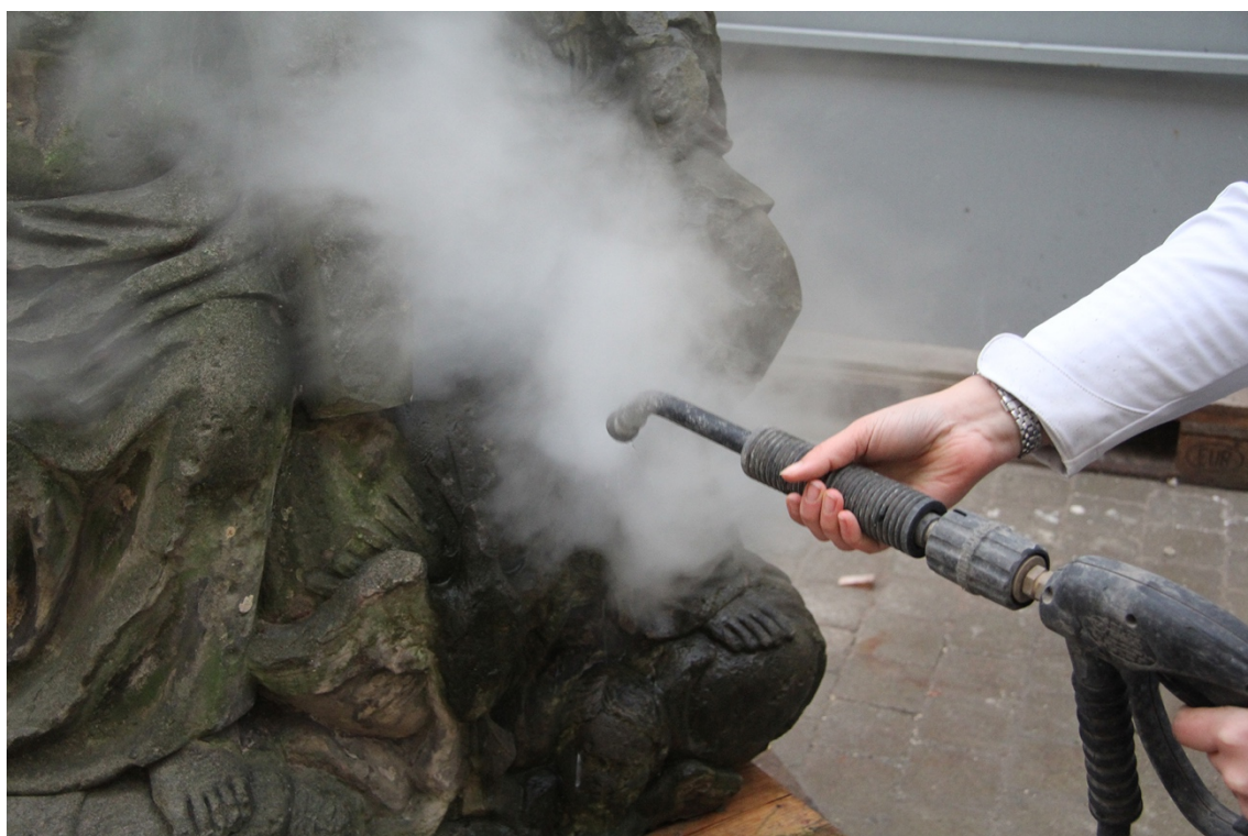
Obr. 75 Odstraňování biologického napadení pomocí páry
