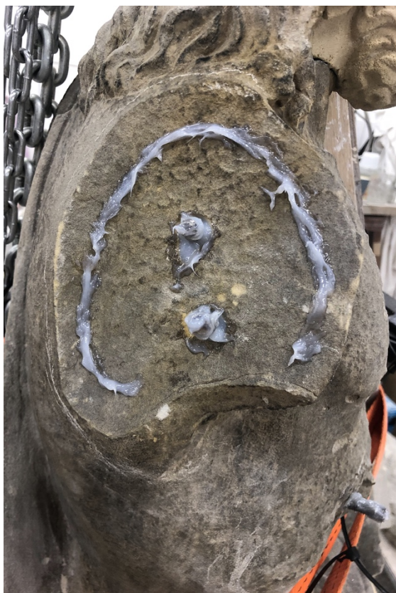
Obr. 94 Zajištění doplňku z umělého kamene pomocí epoxidového lepidla
