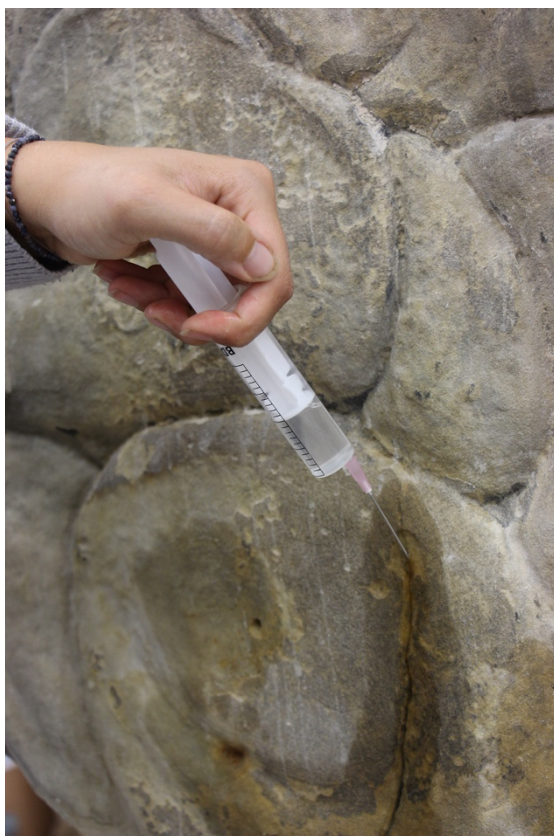
Obr. 80 Lokální konsolidace kamene
