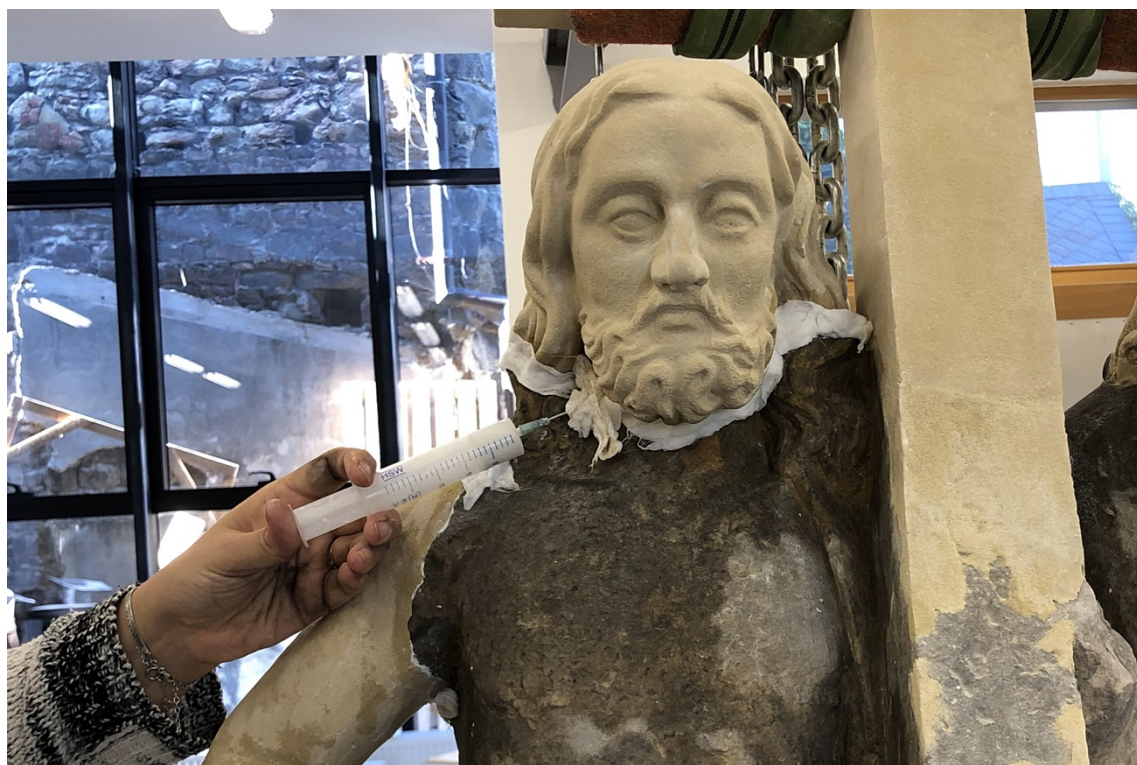
Obr. 96 Injektáž dutin přítomných mezi výdusky z umělého kamene a originálním materiálem
