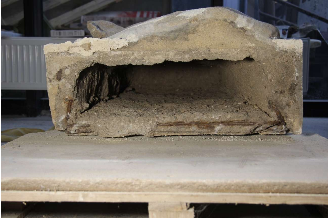
Obr. 13 stav před restaurováním, spodní pohled
