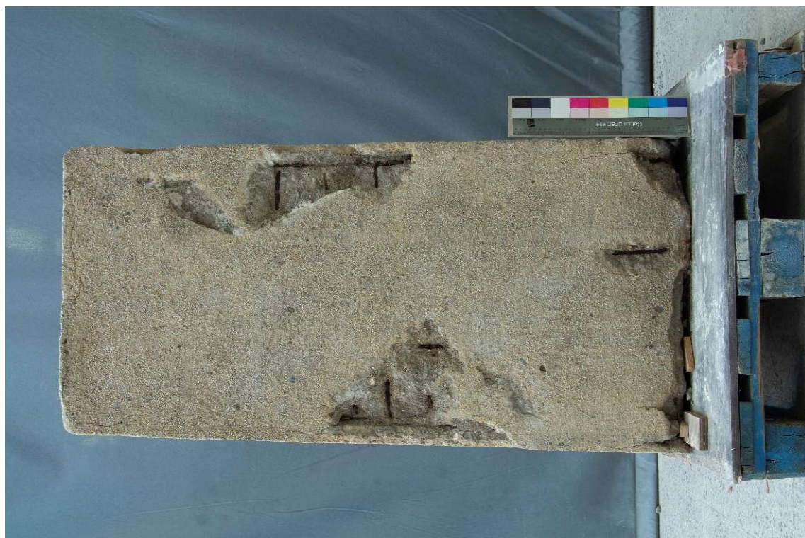
Obr. 23 Stav po očištění, zadní pohled
