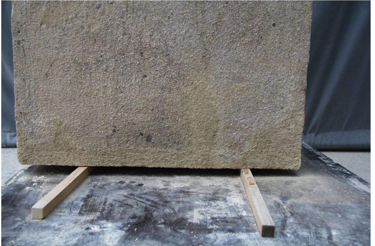
Obr. 42 Stav po restaurování, detail plastické retuše spodní část
