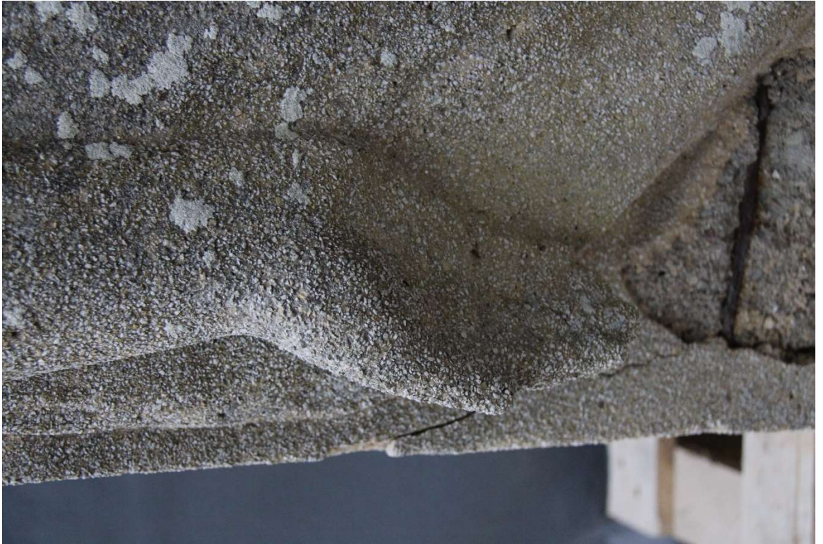
Obr. 17 Stav před restaurováním, detail levé dlaně figurálního výjevu
