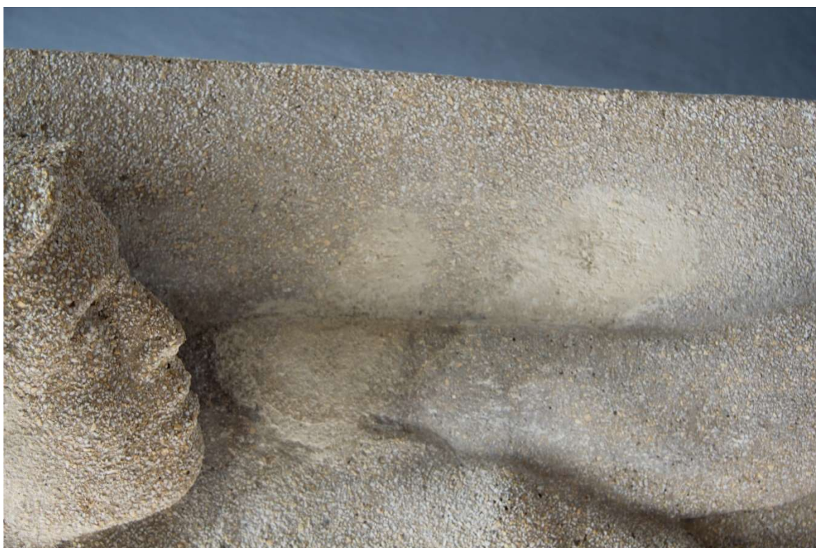
Obr. 33 Stav po plastické retuši, detail hlavy figurálního výjevu
