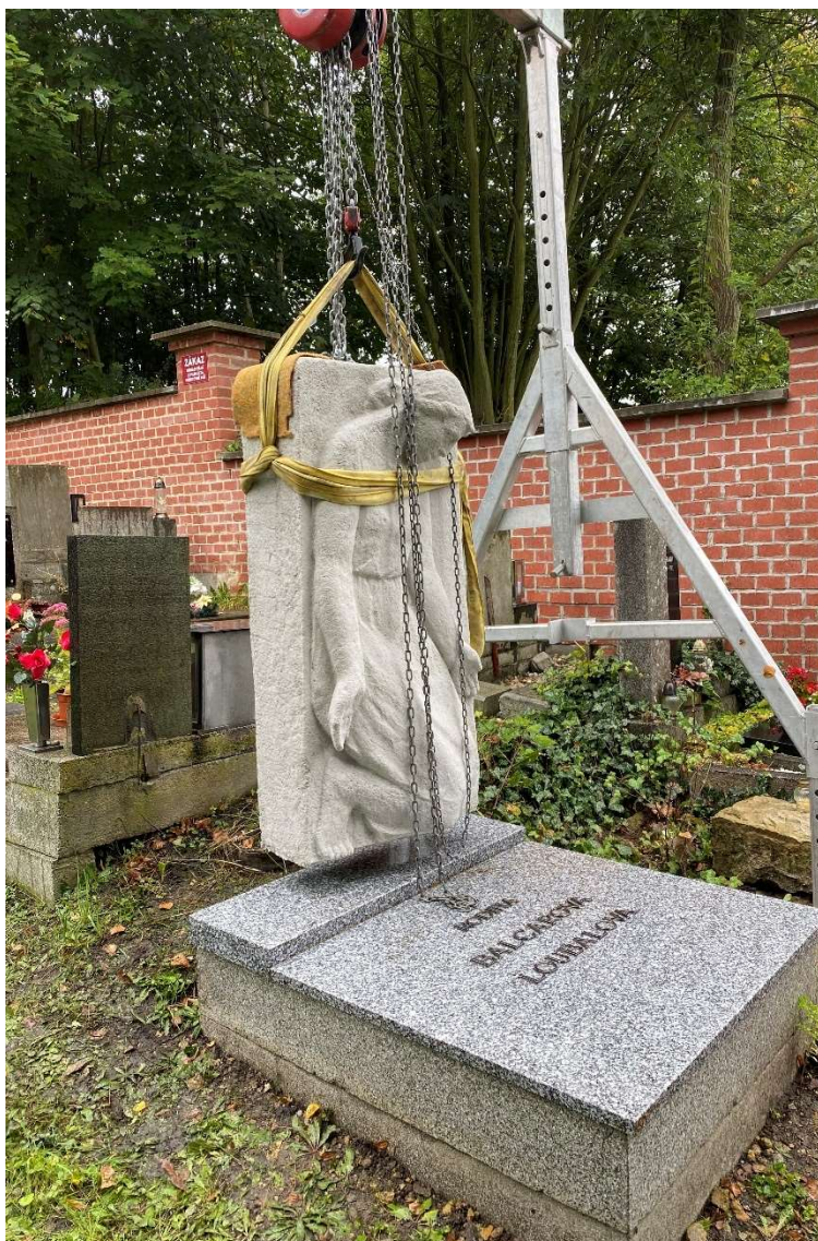
Obr. 6 Průběh osazení kopie na hrobovém místě v Parníku v České Třebové pomocí mobilního jeřábu
