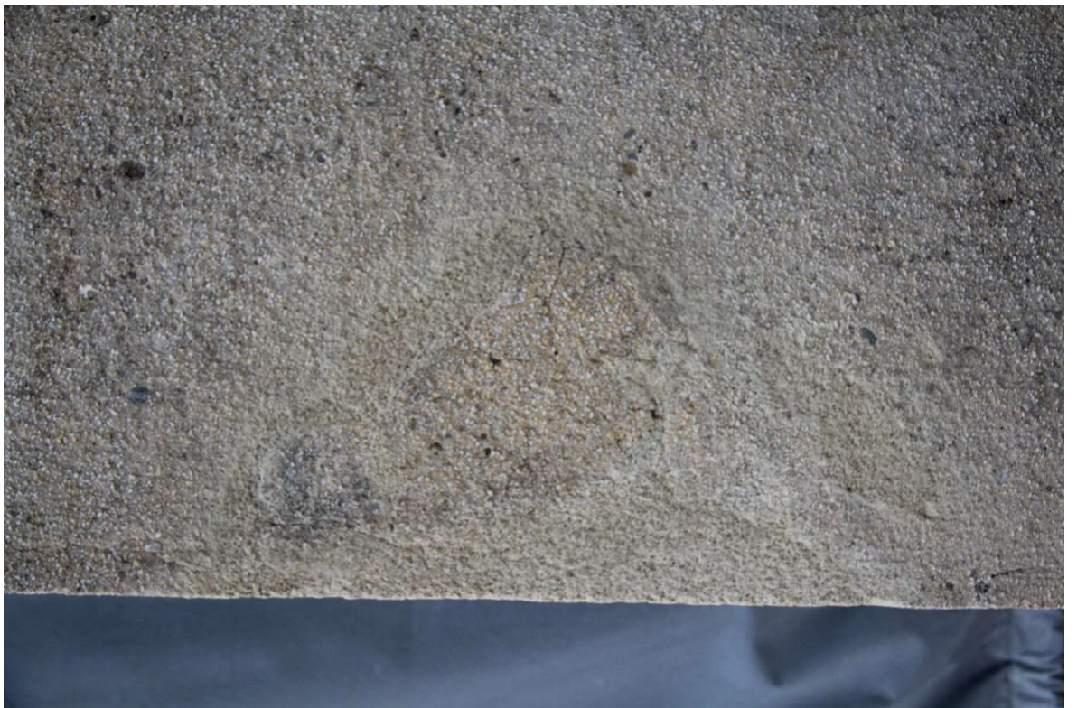
Obr. 41 Stav po restaurování, detail plastické retuše zadní část
