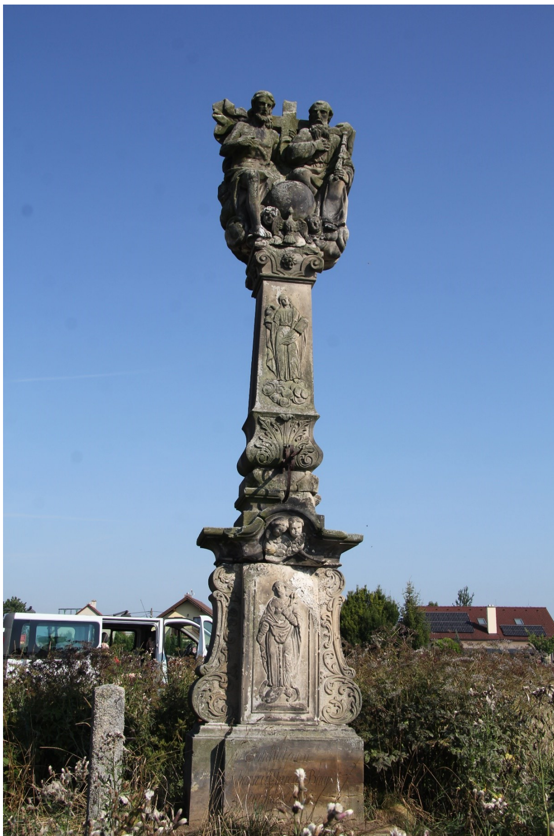
Fotodokumentace 4 Stav díla před transferem, čelní pohled
