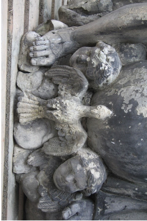
Fotodokumentace 42 Detail hlav andílků po očištění od biologického povlaku
