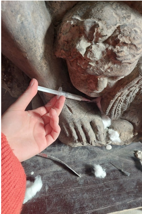
Fotodokumentace 62 Injektáž prasklin
