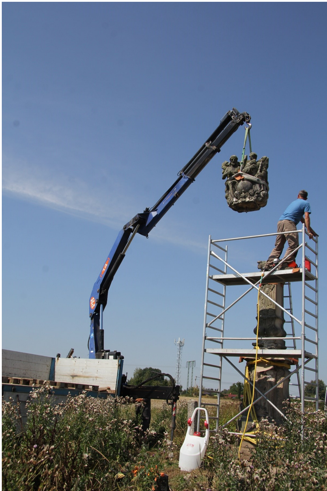
Fotodokumentace 8 Transfer díla
