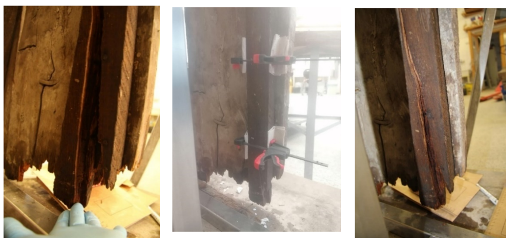
Obr. č. 60 Lepení konstrukčních latí. Fotografie pořízeny 17.1.2023
