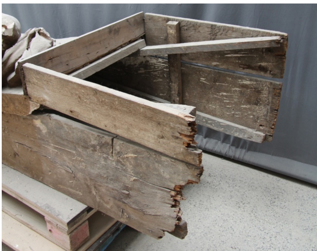
Obr. č. 37 Detail poškození díla. Nestabilní dřevěná konstrukce. Chybějící části konstrukce z důvodů uskladnění díla ve vlhkém prostředí. Stav před restaurováním. Fotografie pořízeny 27.5.2022
