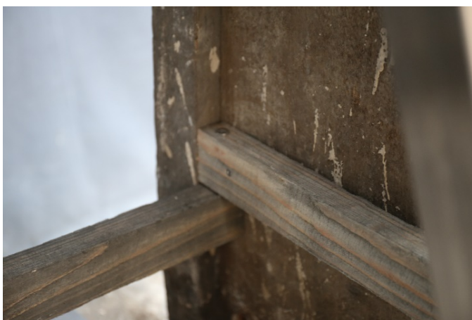
Obr. č. 55 Vyztužení spodní části dřevěné konstrukce smrkovými latěmi, spojené s dílem na nerezové vruty. Fotografie pořízeny 10.2.2023
