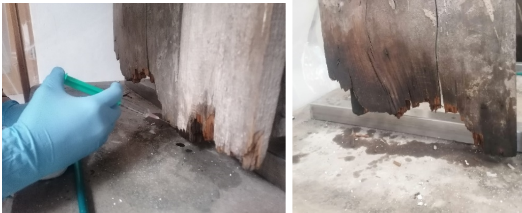
Obr. č. 59 Vlevo aplikace 5% roztoku Solakryl BMX v xylenu injekční stříkačkou na poškozené dřevo. Vpravo dřevěná konstrukce čerstvě po ošetření – směrem odspodu byla konstrukce ošetřena i několikrát a „odtupována“ štětcem plynule do ztracena. Fotografie pořízeny 10.1.2023
