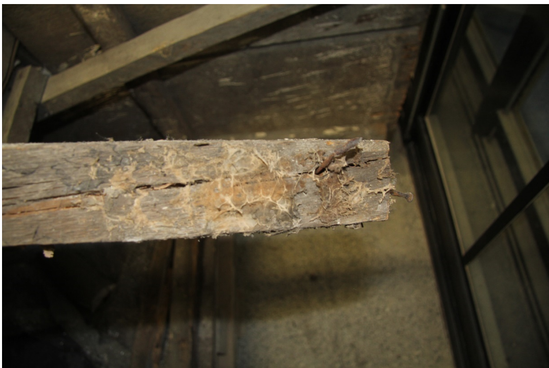
Obr. č. 39 Část dřevěné konstrukce, kterou pokrývá biologický povlak. Fotografie pořízena 16.11.2022
