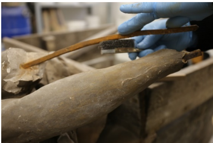
Obr. č. 43 Mechanické očištění zkorodovaných armatur. (Fotografie pořízena 10.11.2022.)
