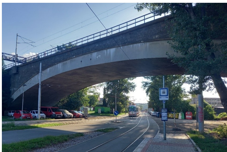
Obrázek 7: Železniční viadukt nad ulicí Obřanská
