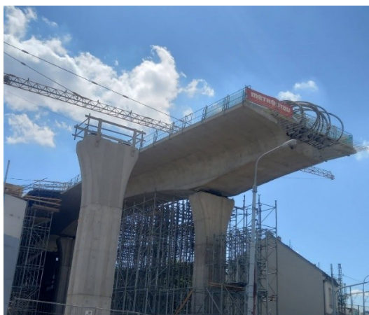
Obrázek 11: Stavba MÚK na ulici Karlova
