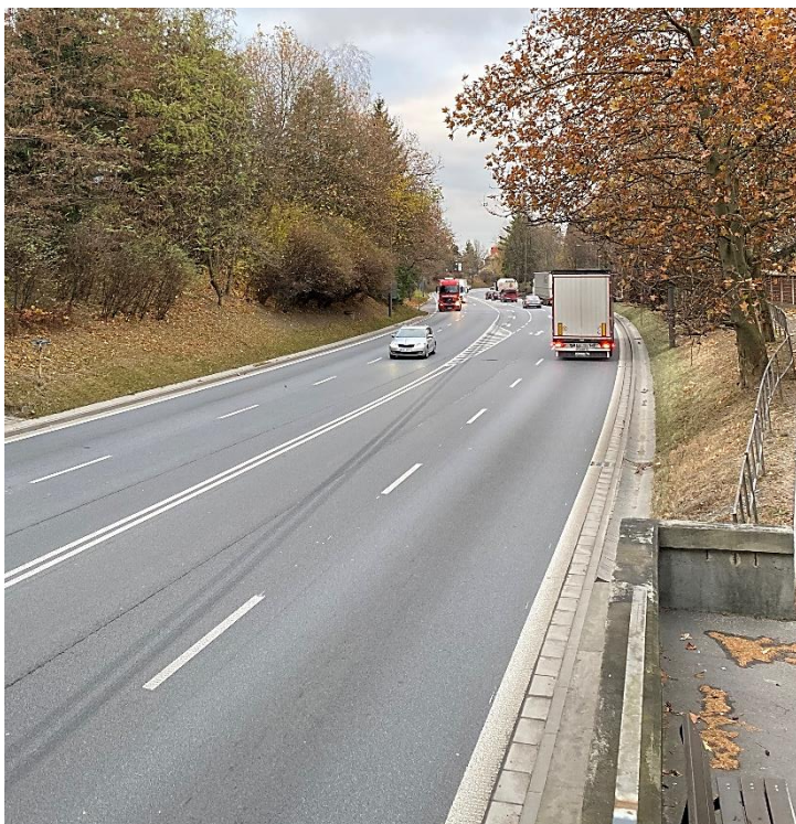
Obrázek 4: Silnice I/35 na průtahu Litomyšlí
