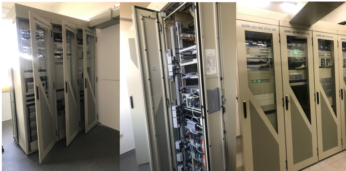
Obrázek 4 Radiobloková centrála ETCS L2 CDP Přerov
