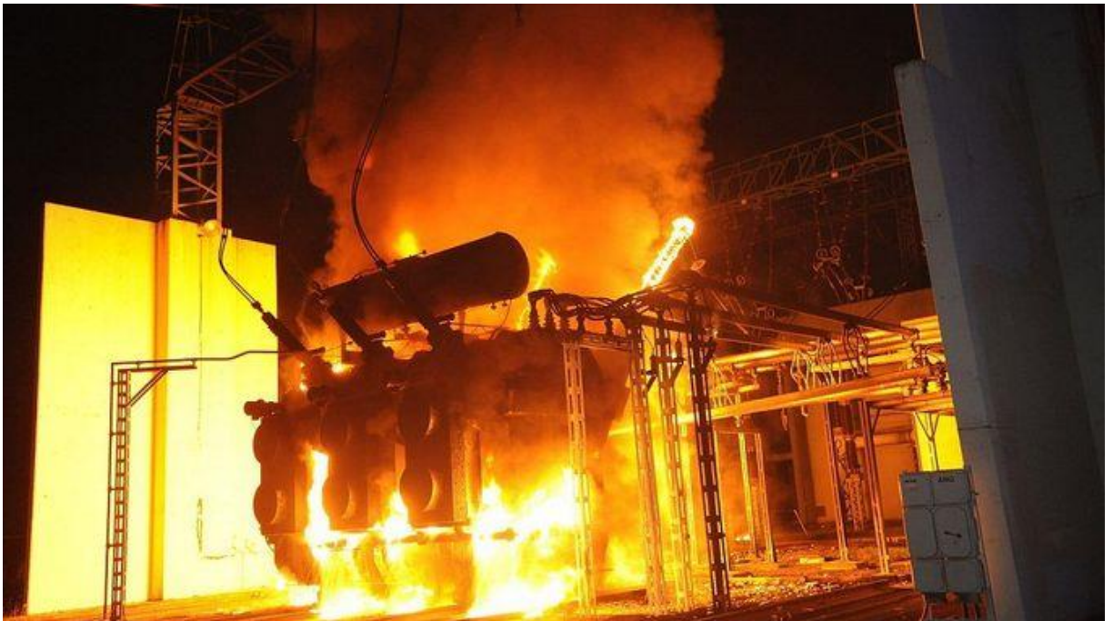
Obrázek 4 - Požár transformátoru [18]
