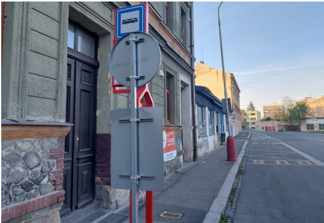
Obrázek 19 Zastávka bez ochrany proti nepříznivým vlivům (autor)
