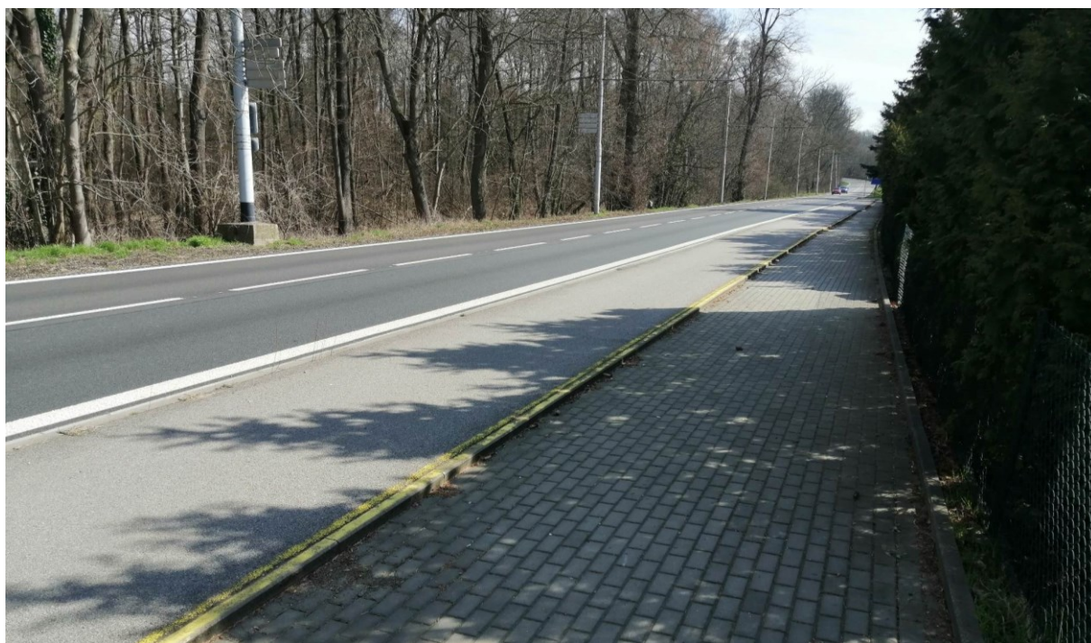
Obrázek 2 Oddělení jízdního pruhu obrubníkem od pásu pro chodce (autorka)
