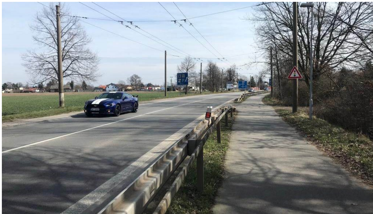
Obrázek 1 Oddělení jízdního pruhu od provozu svodidlem (autorka)
