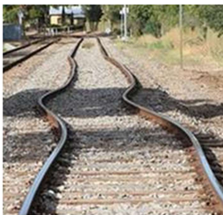
Obrázek 4 - Vybočení kolejnice [16]
