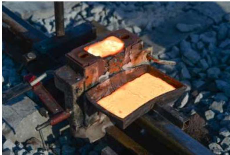
Obrázek 12 – Aluminotermické svařování [19]
