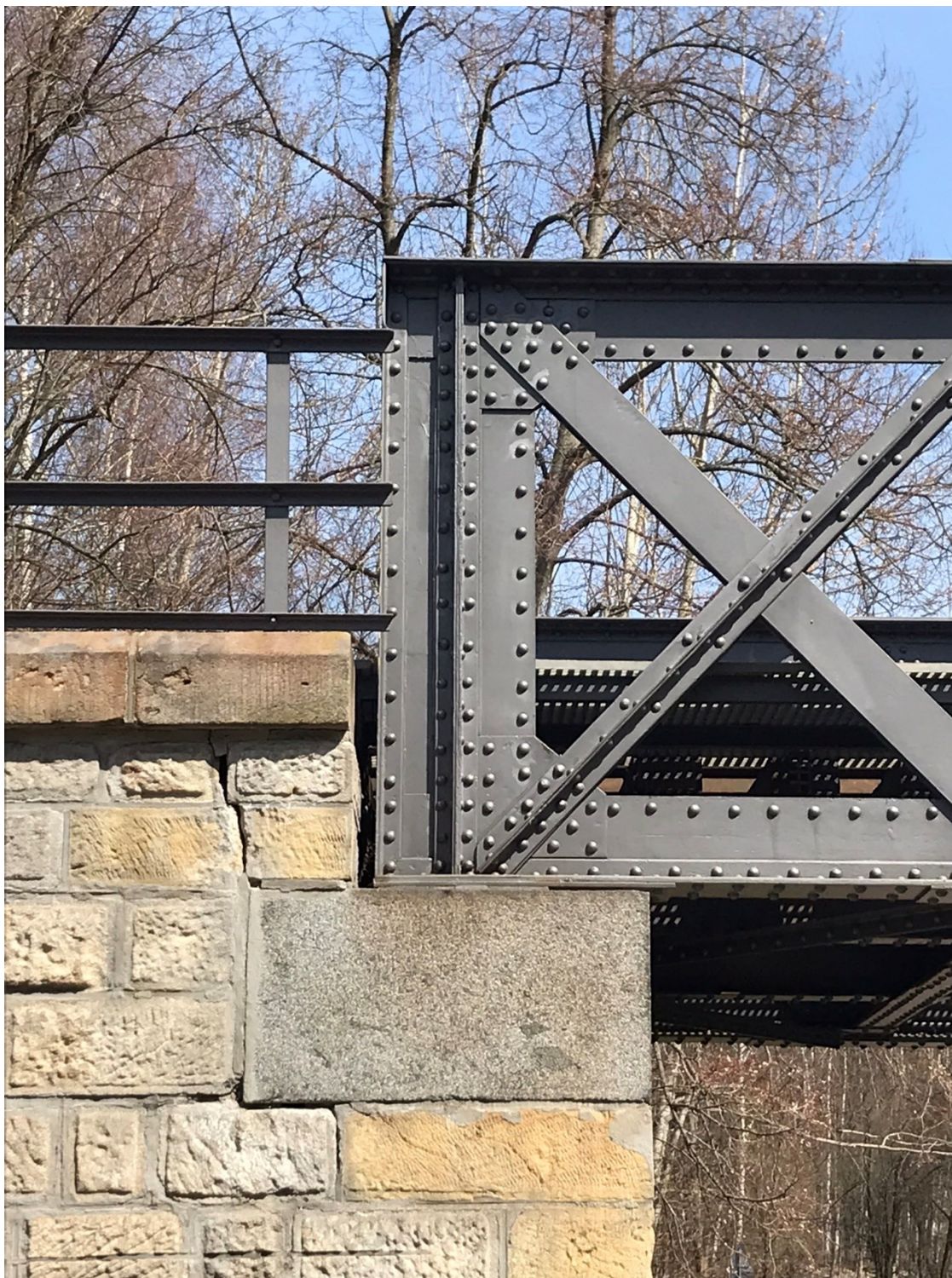
Obrázek 4 - Uložení konstrukce na opěře (O 01)
