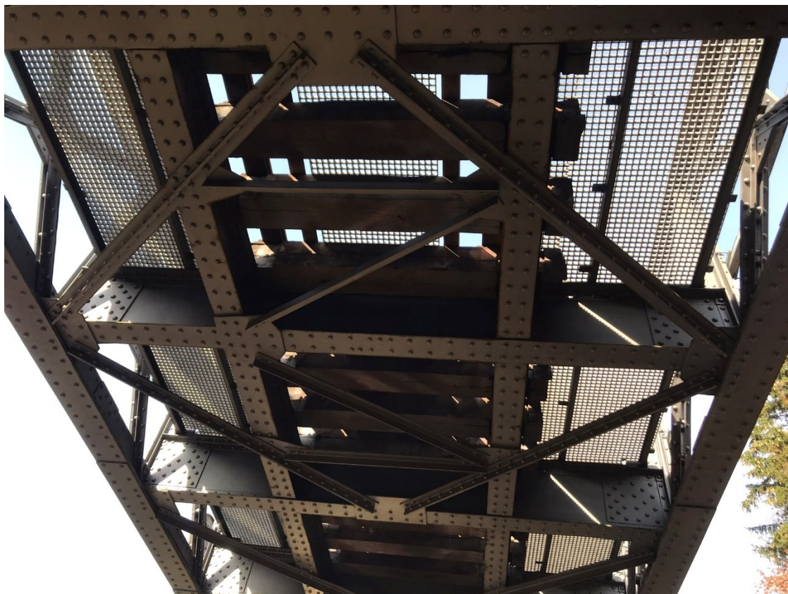
Obrázek 10 - Pohled na podélné a brzděné ztužení (PZ1; BZ)
