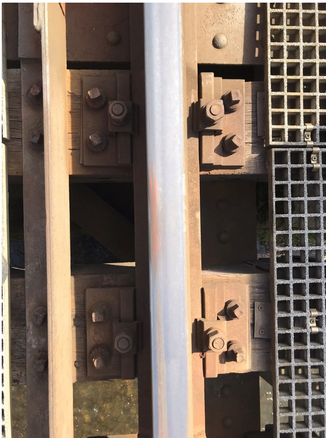
Obrázek 8 - Detail upevnění kolejnice na mostnice
