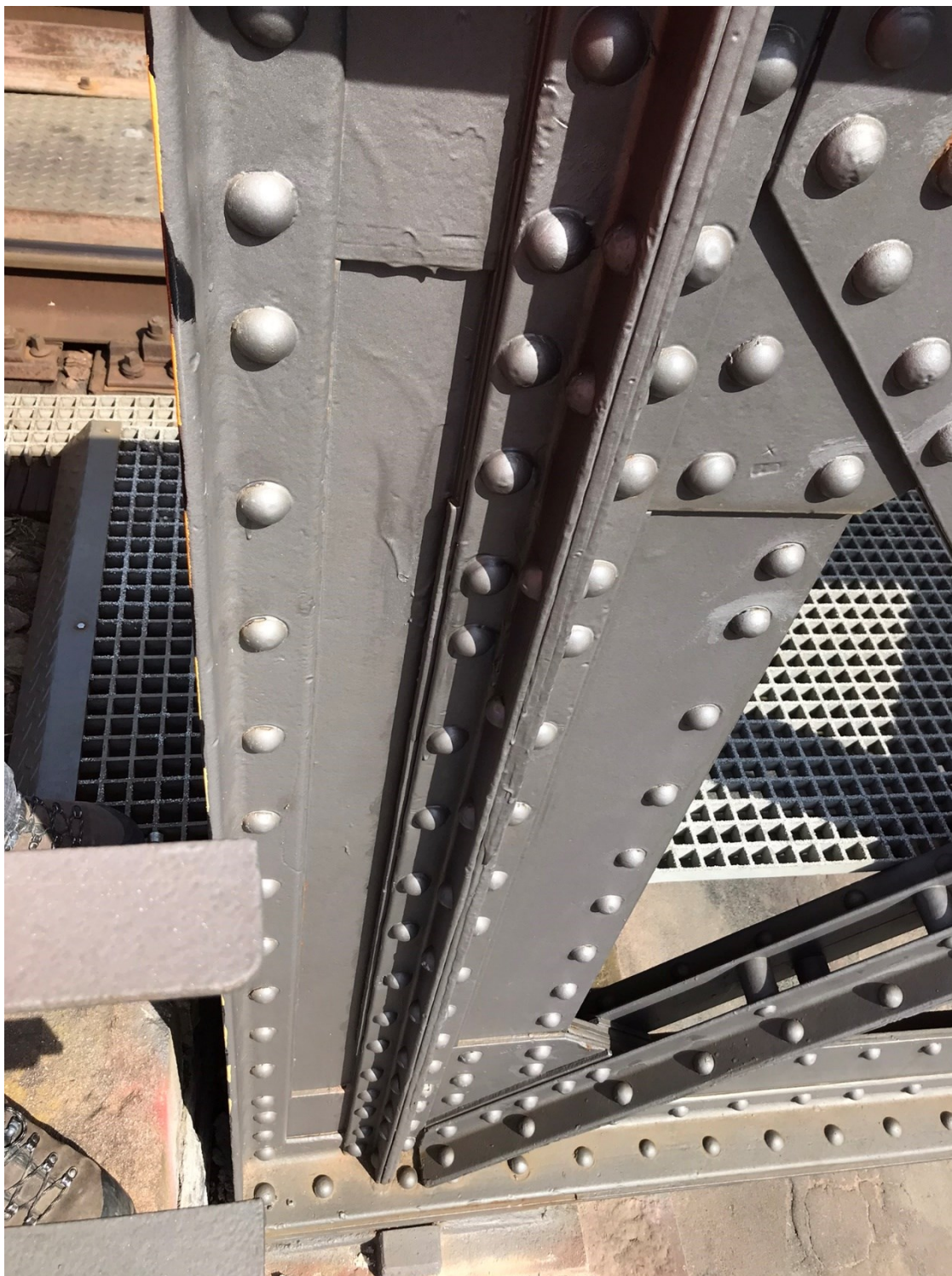
Obrázek 5 - Detail krajní svislice s tangenciálním ložiskem
