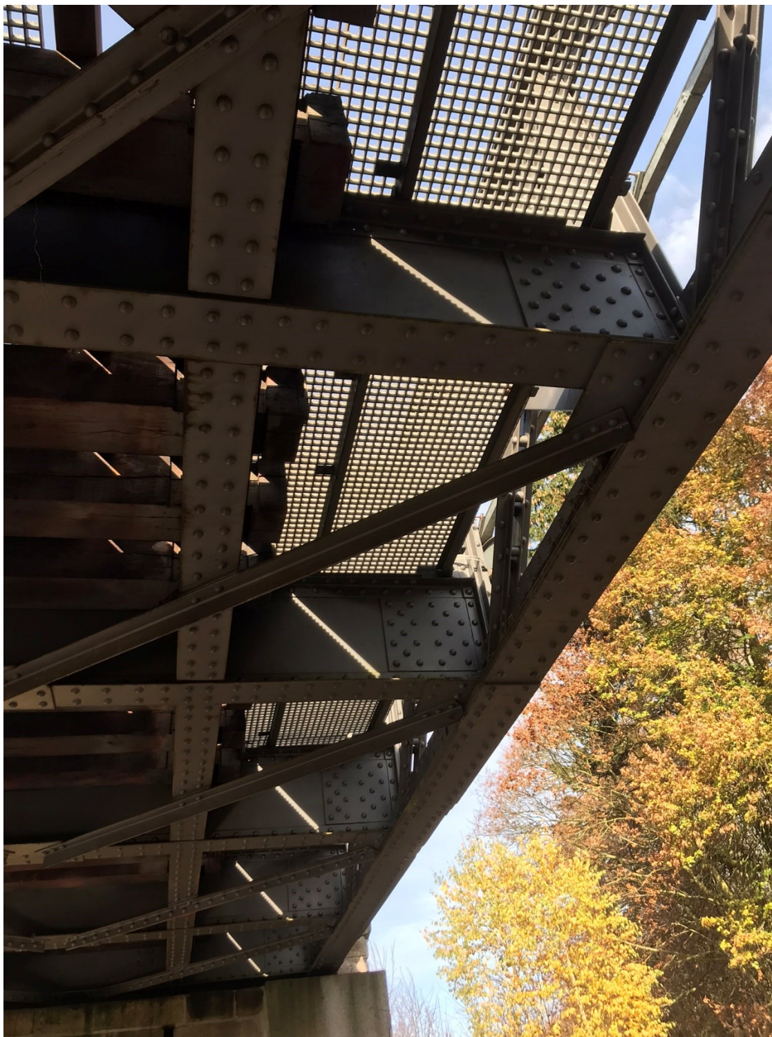
Obrázek 9 - Pohled na připojení příčníků k hlavnímu nosníku
