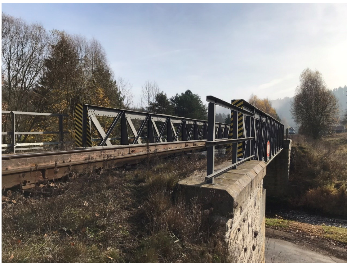
Obrázek 3 - Římsa se zábradlím (O 01)
