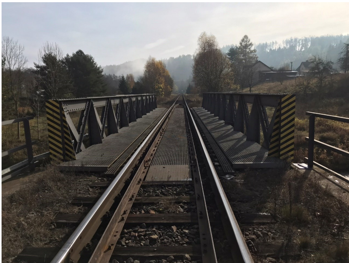
Obrázek 2 - Pohled na most (směr Broumov)
