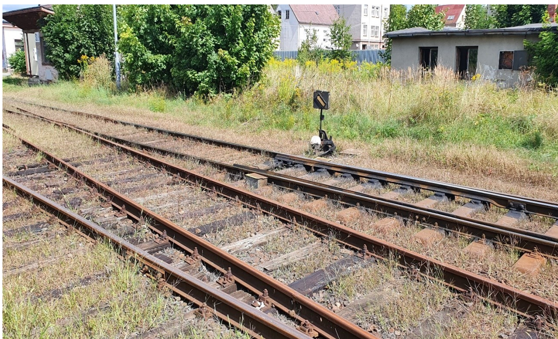
Obrázek 18 Stávající stupňové výhybky
