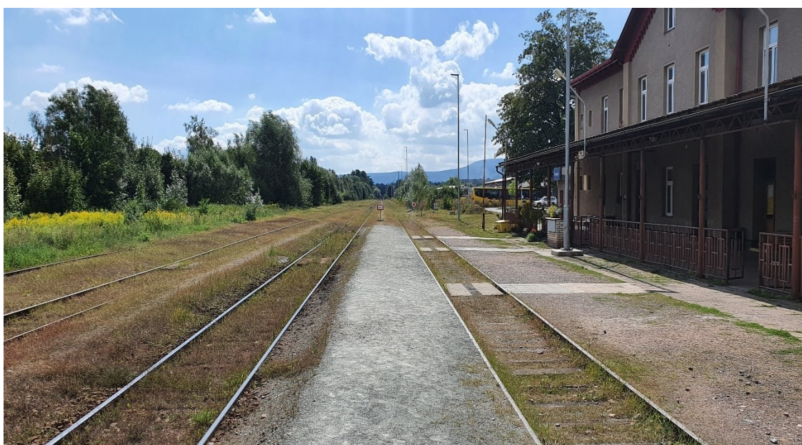
Obrázek 16 Stávající stav Výpravní budova
