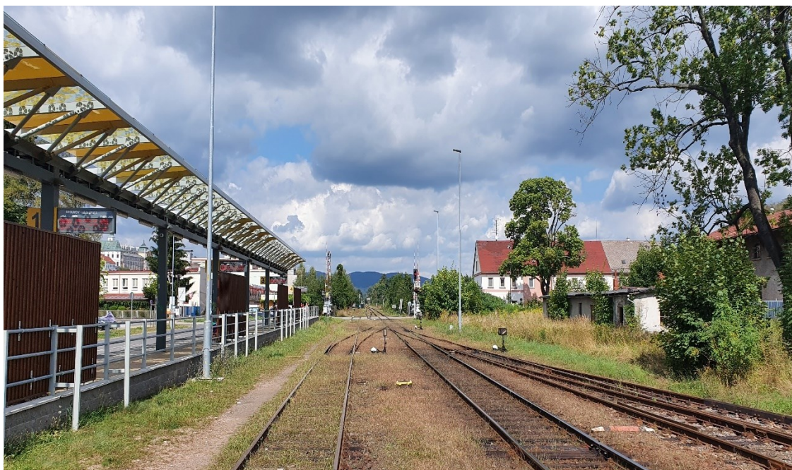
Obrázek 17 Stávající zhlaví směr Meziměstí
