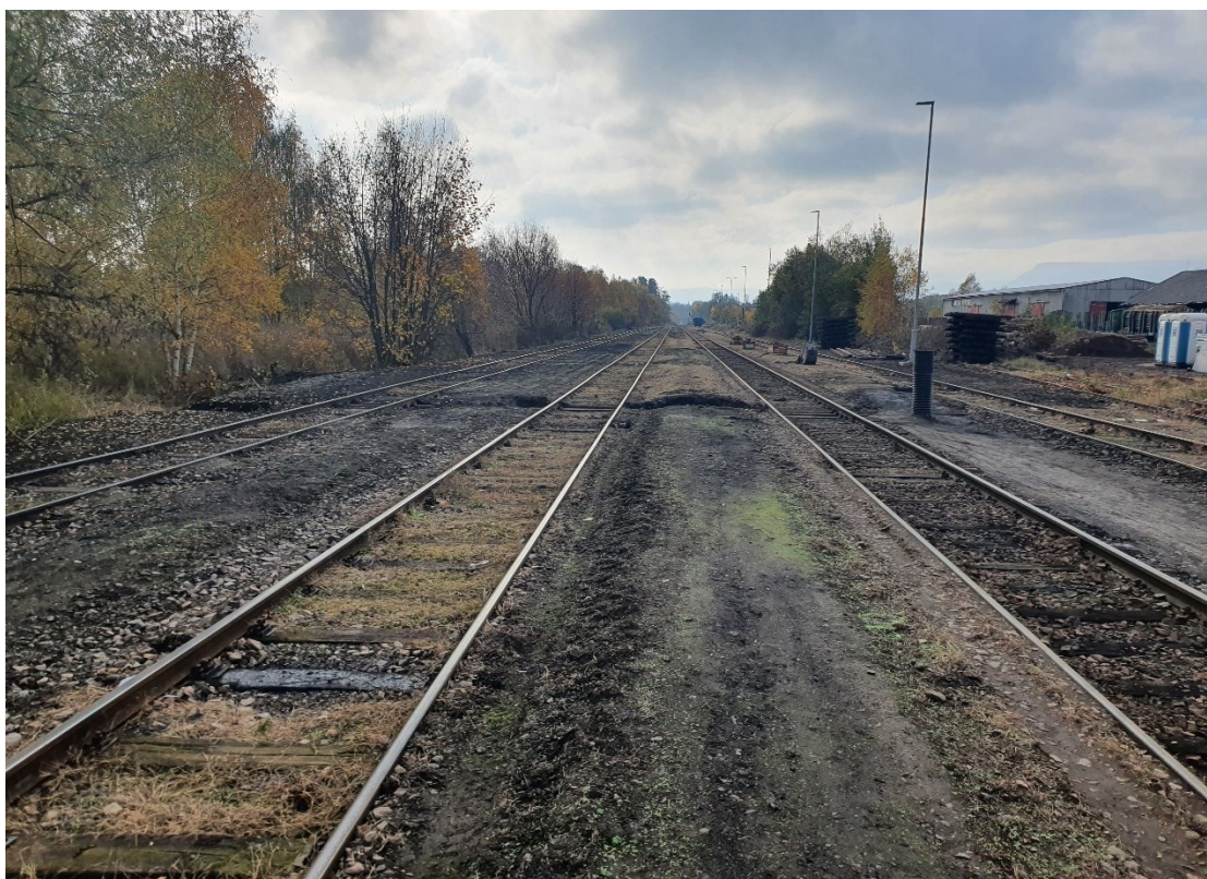
Obrázek 20 Železniční svršek směr Otovice zastávka
