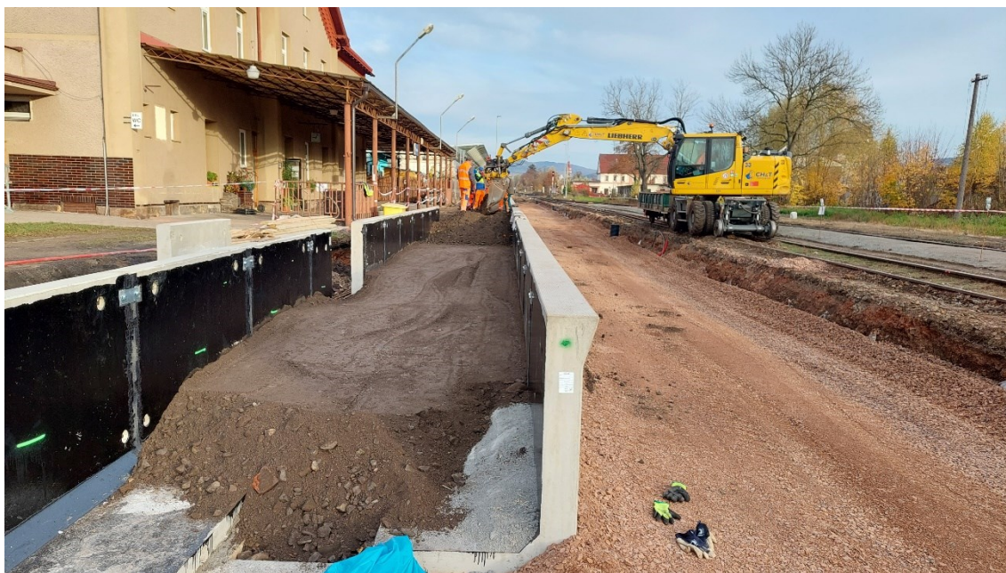
Obrázek 23 Zásyp nástupiště a konstrukčních vrstev
