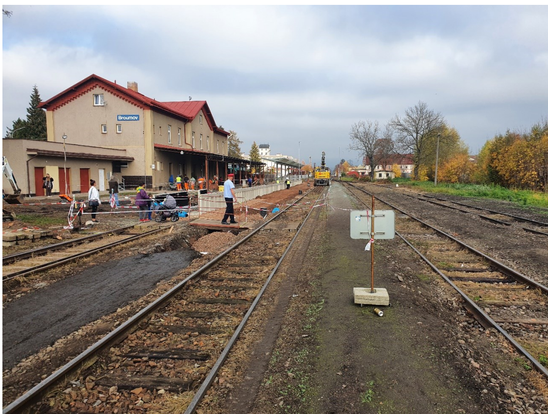
Obrázek 22 Pohled na probíhající rekonstrukci vnějšího nástupiště
