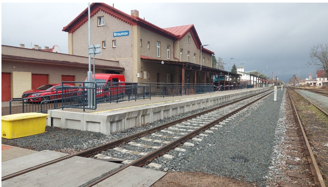
Obrázek 24 Finální stav nově zřízeného vnějšího nástupiště u koleje č. 2
