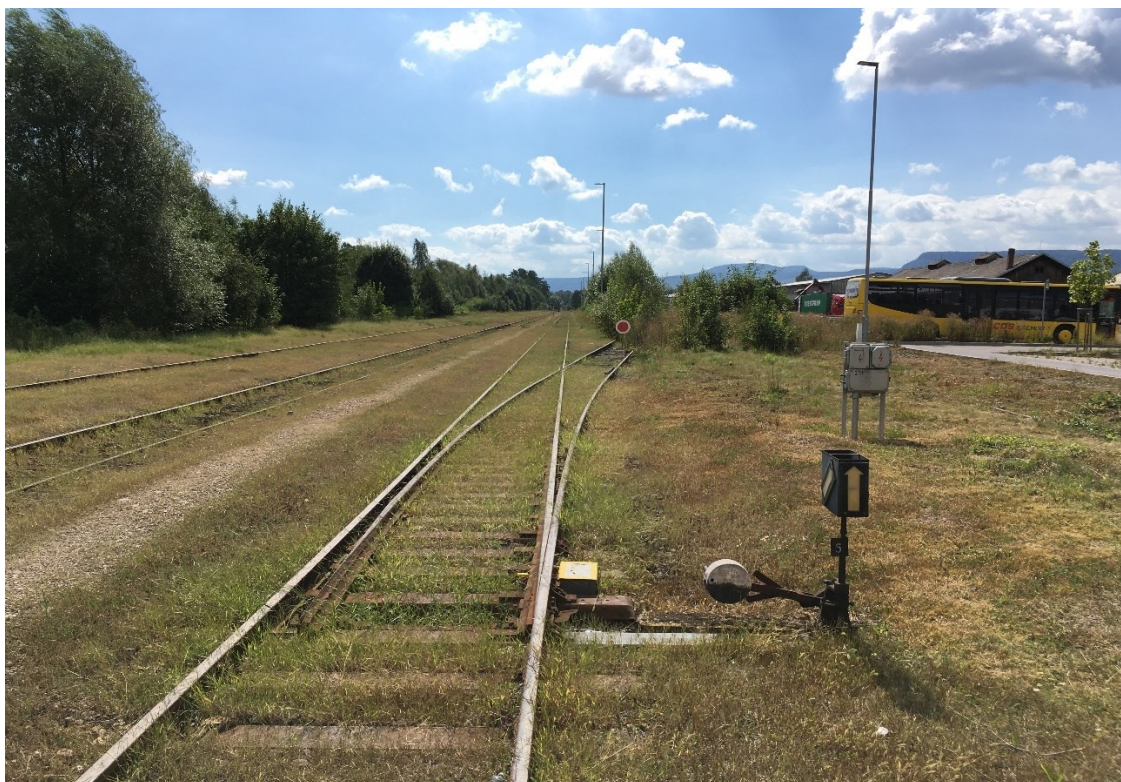
Obrázek 19 Rušená stávající stupňová výhybka č.5
