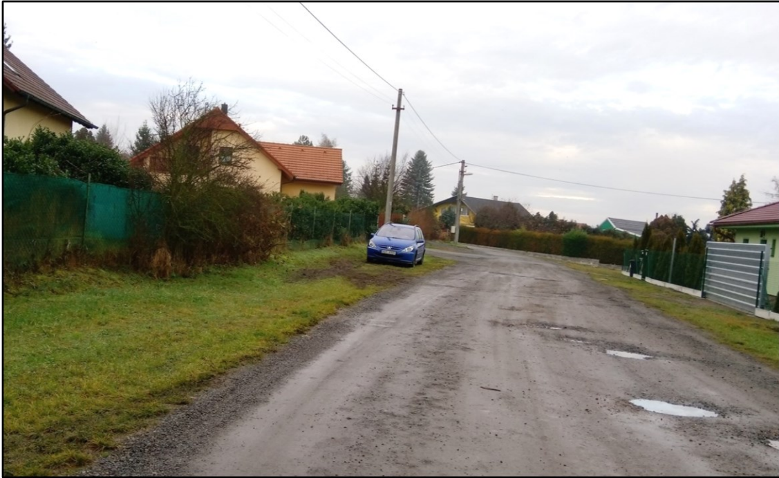
Pohled 3 – ulice Na Výhledech ve staničení cca 0,200 00 Km
