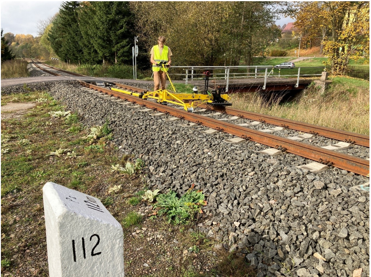
Obrázek 20 Počáteční místo měřeného úseku koleje - 112,000 km trati č.040
