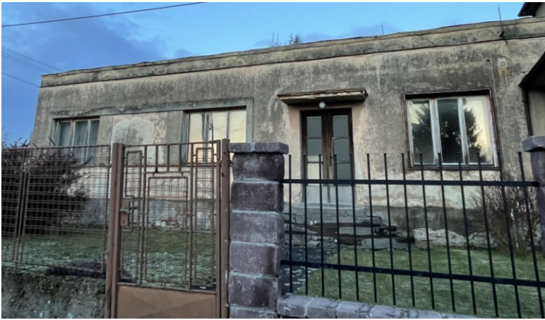
Obrázek 50: Přední vchod domu
