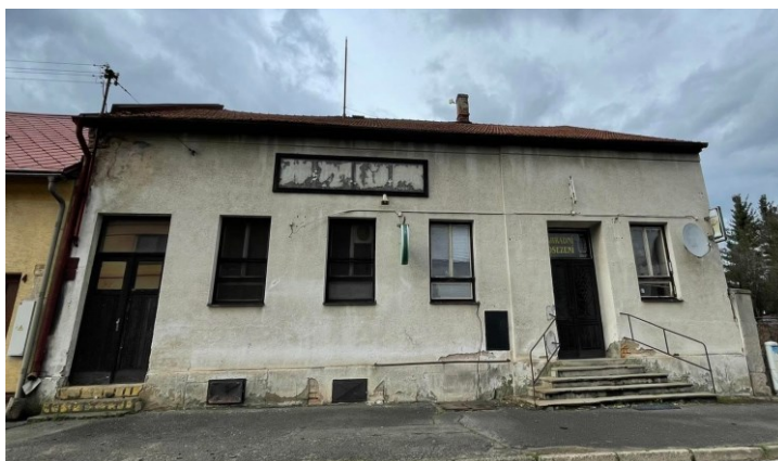
Obrázek 22: Objekt bývalé hospody
