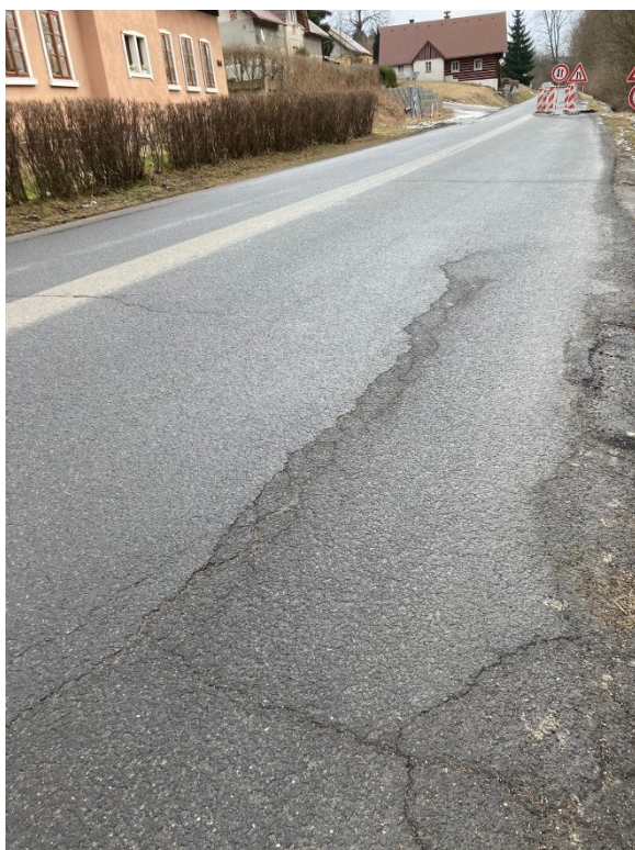
Trhlina rozvětvená podélná s úzkými příčnými trhlinami Olamování okrajů vozovky
