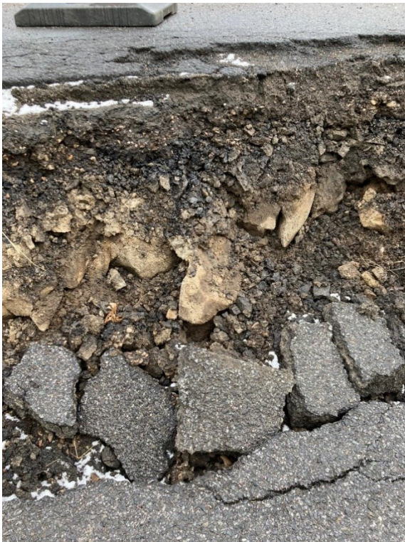
Pohled na konstrukční vrstvy vozovky
