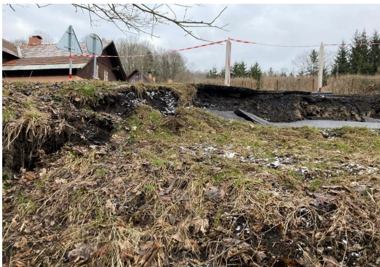
Pohled ze svahu
