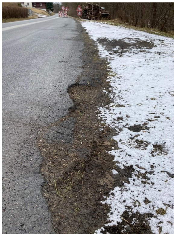
Trhlina rozvětvená podélná s úzkými příčnými trhlinami Olamování okrajů vozovky
