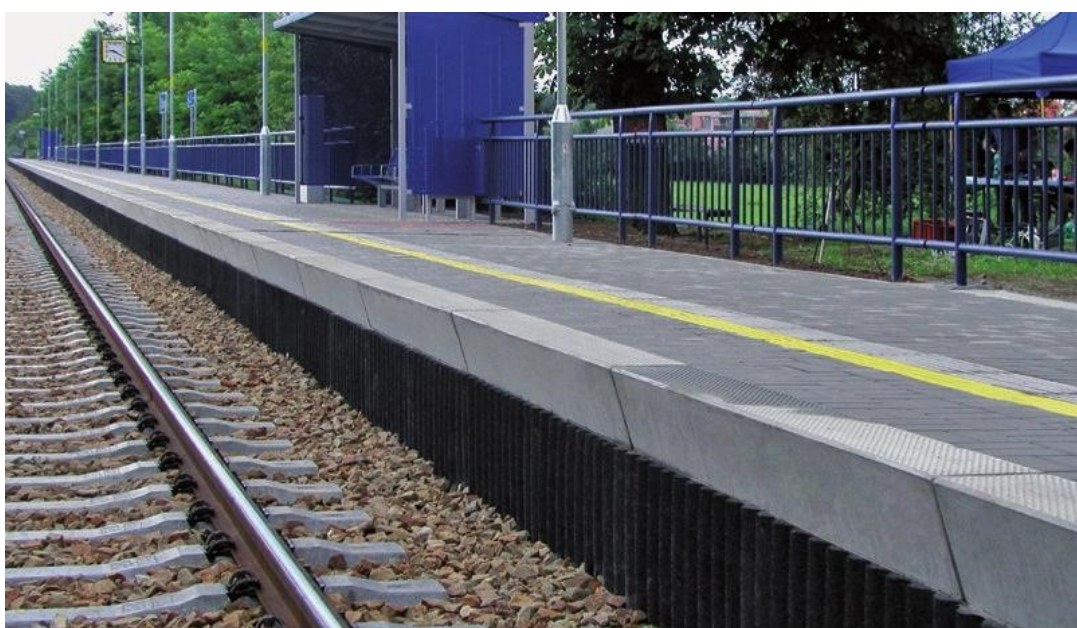
Obrázek 18 – Použití protihlukových desek z pryžových materiálů u nástupiště typu H [10]
