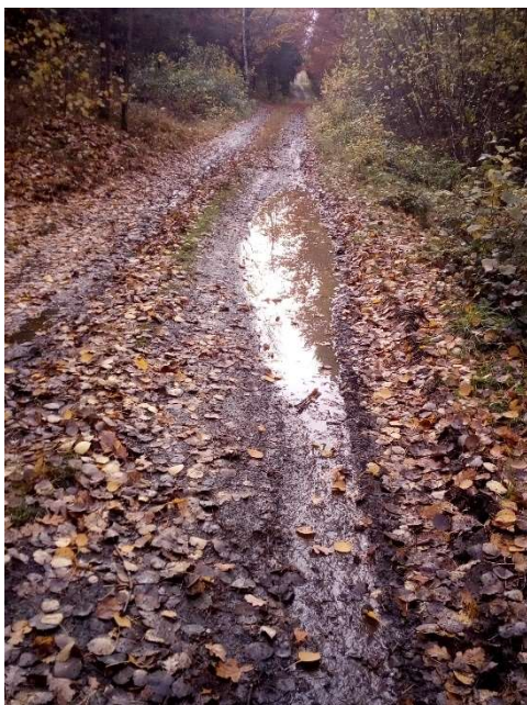
Obrázek 4 Ukázka důsledků zatěžování – vyjetá kolej (zdroj: vlastní fotografie)
