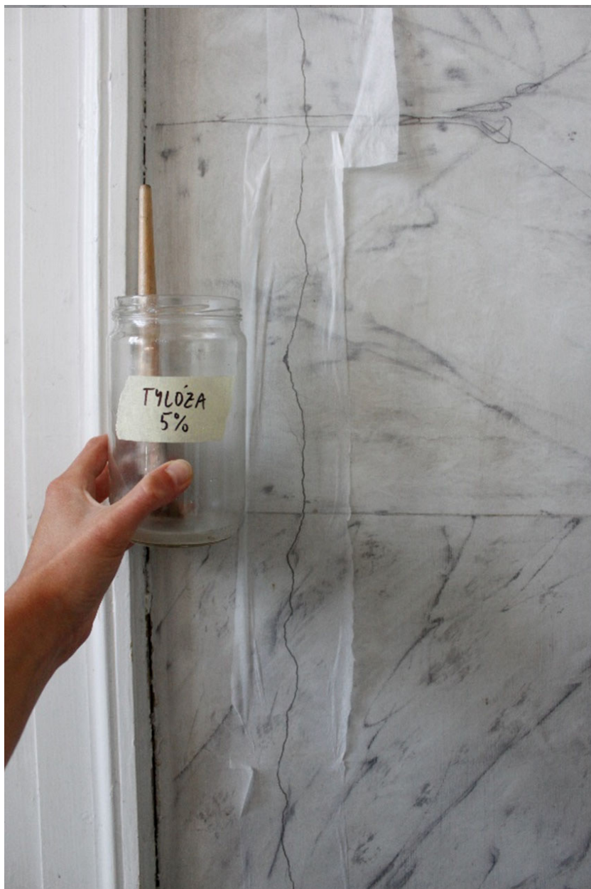
Obr. 30: Provádění zajišťovacího přelepu z japonského papíru a derivátu celulózy Tylose MH300. Západní část jižní stěny.
