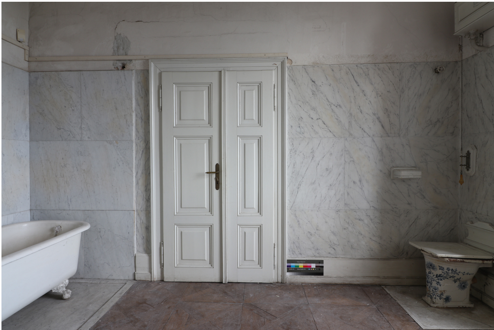
Obr. 48: Pohled na severní stěnu. Stav po restaurování.
