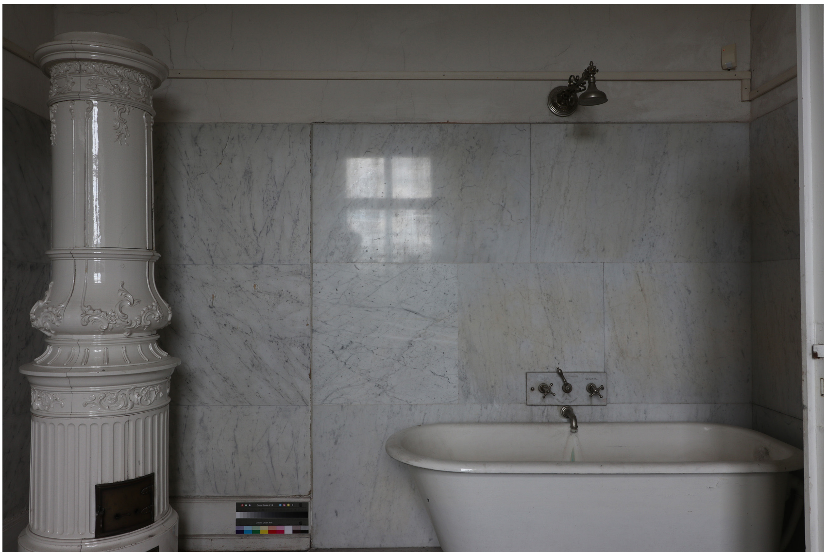
Obr. 03: Pohled na západní stěnu místnosti č. 106. Stav před restaurováním.
