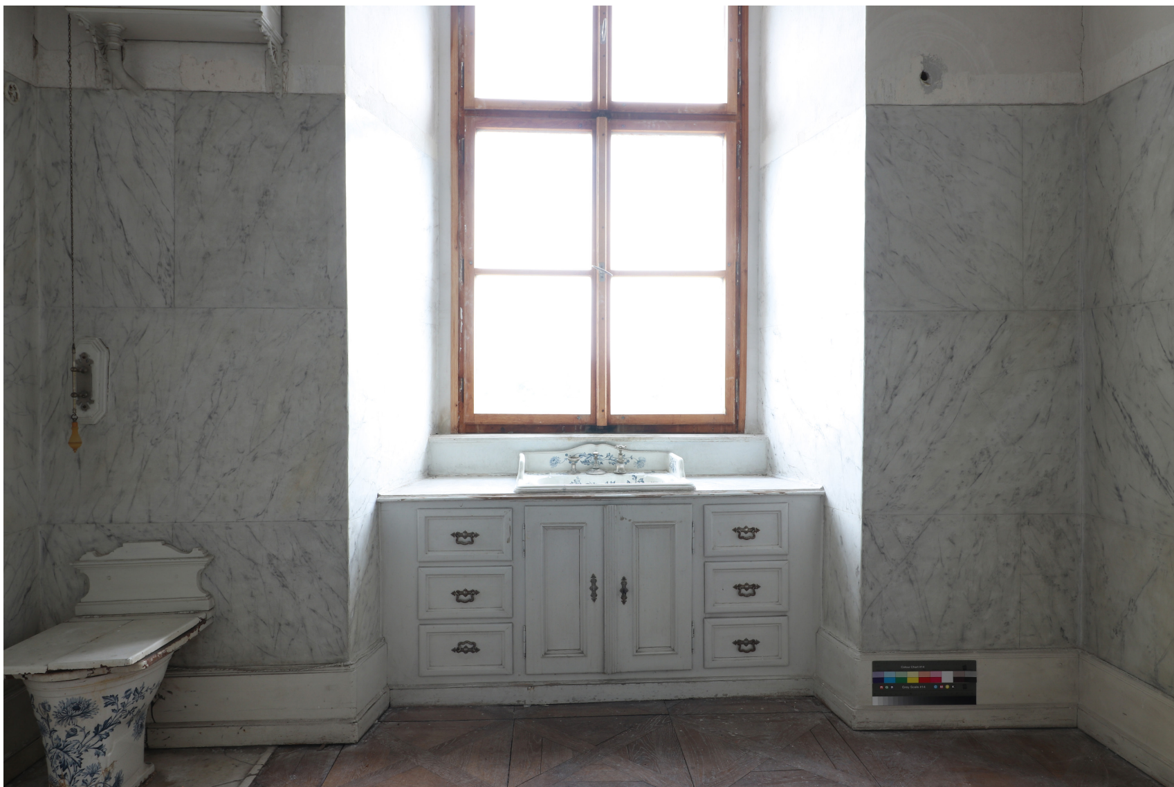
Obr. 46: Pohled na východní stěnu. Stav po restaurování.
