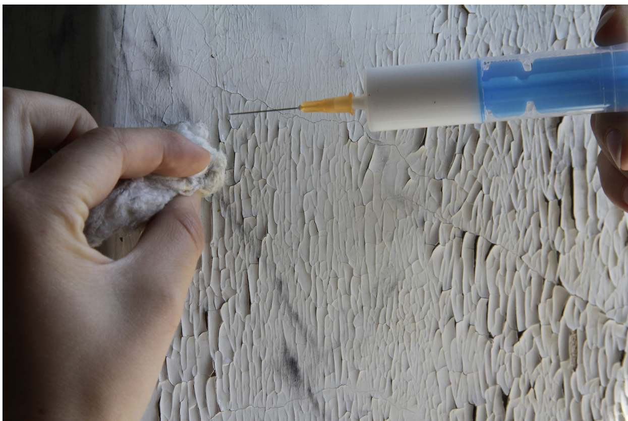
Obr. 26: Severní okenní špaleta východní stěny. Ukázka postupu konsolidace šupin barevné vrstvy – zvyšování nasákavosti šupin pomocí vody s lihem (1 : 1). Severní okenní špaleta východní stěny.
