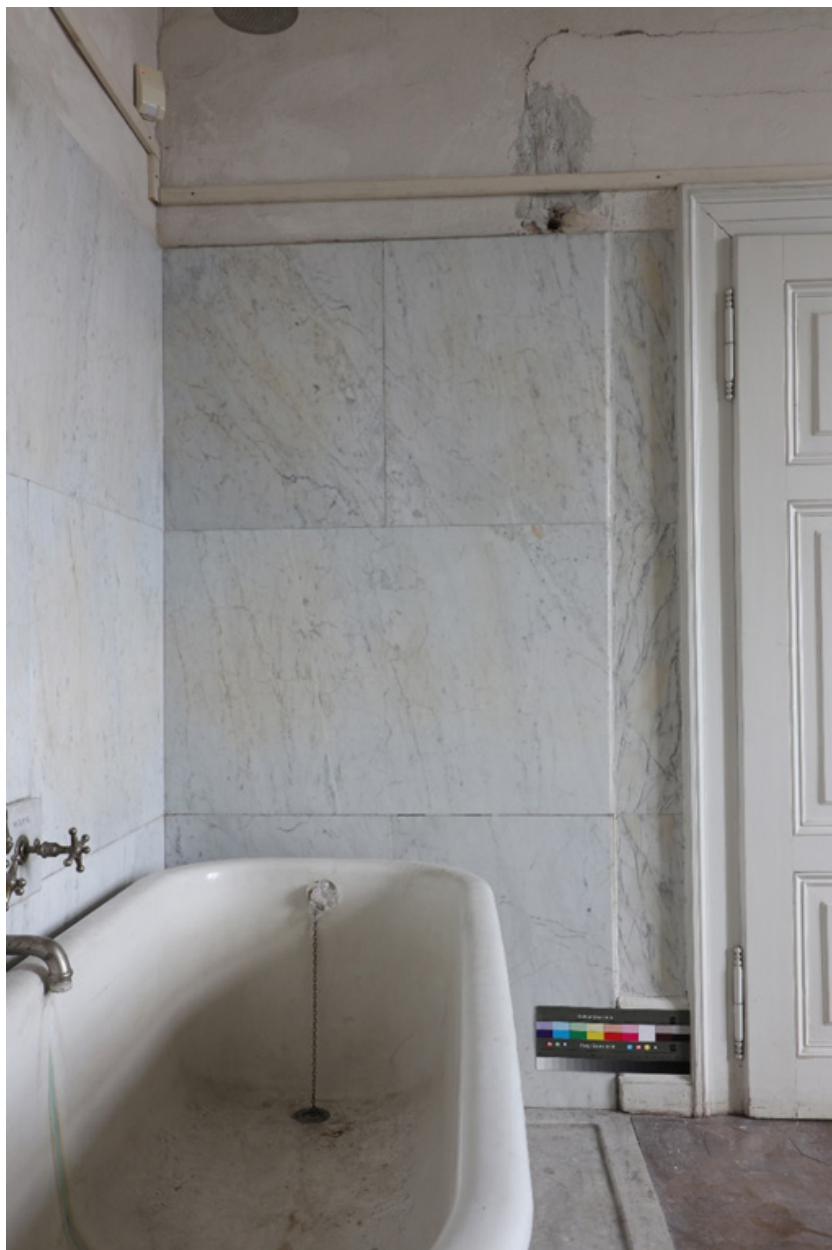
Obr. 44: Pohled na západní část severní stěny. Stav po restaurování.
