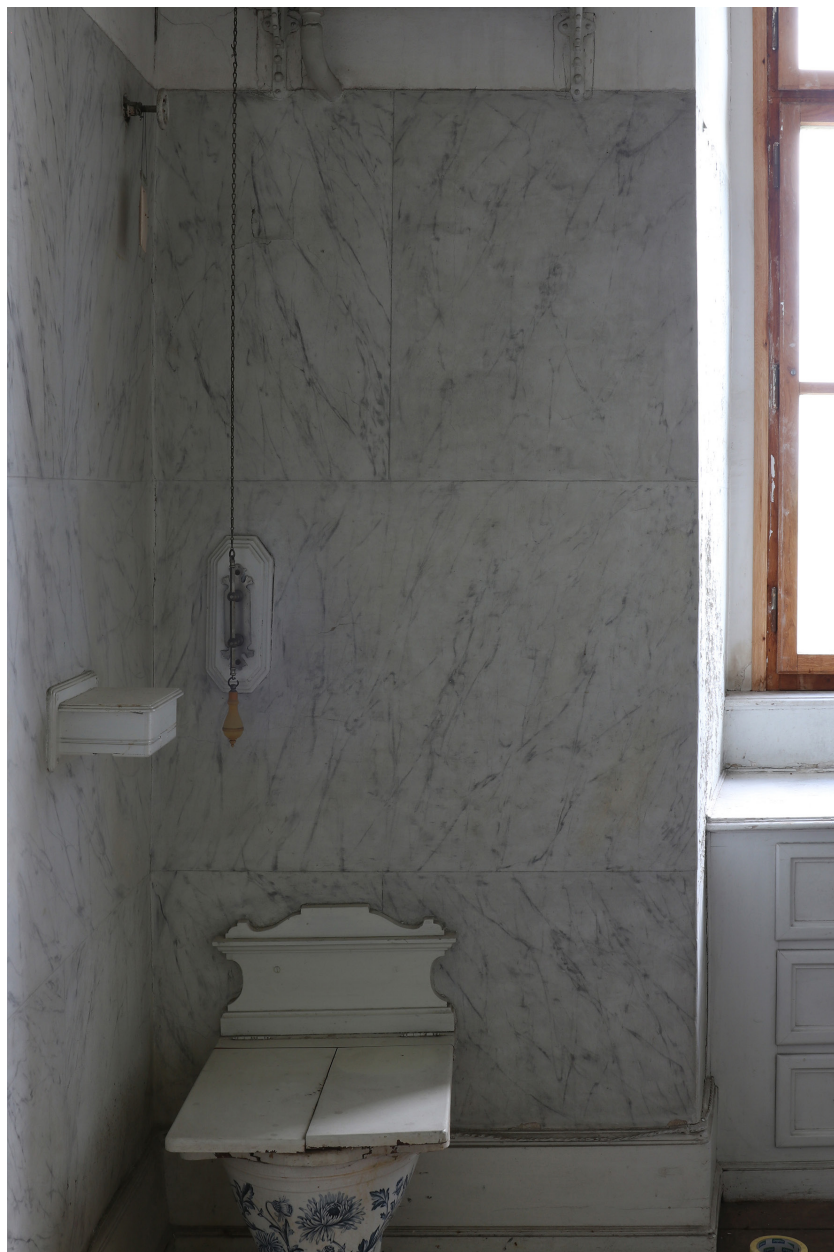
Obr. 05: Pohled na severní část východní stěny. Stav před restaurováním.
