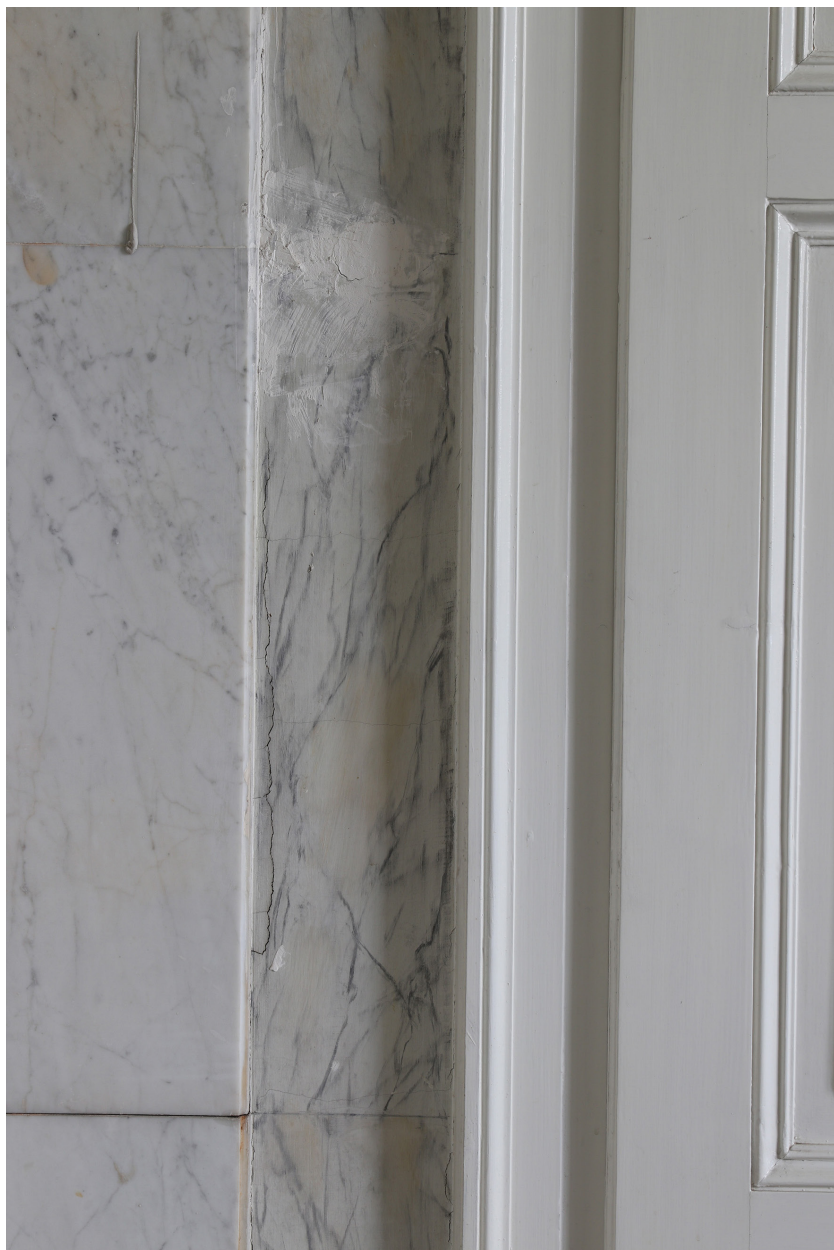
Obr. 11: Pohled na západní část severní stěny. Stav před restaurováním.
