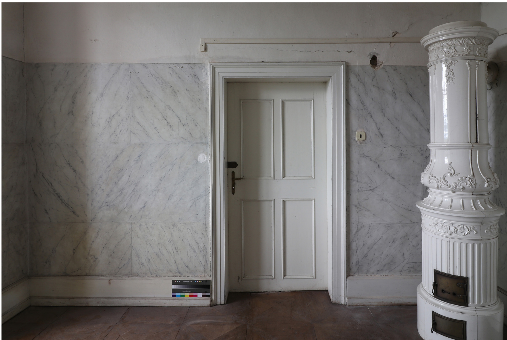
Obr. 02: Pohled na jižní stěnu místnosti č. 106. Stav před restaurováním.
