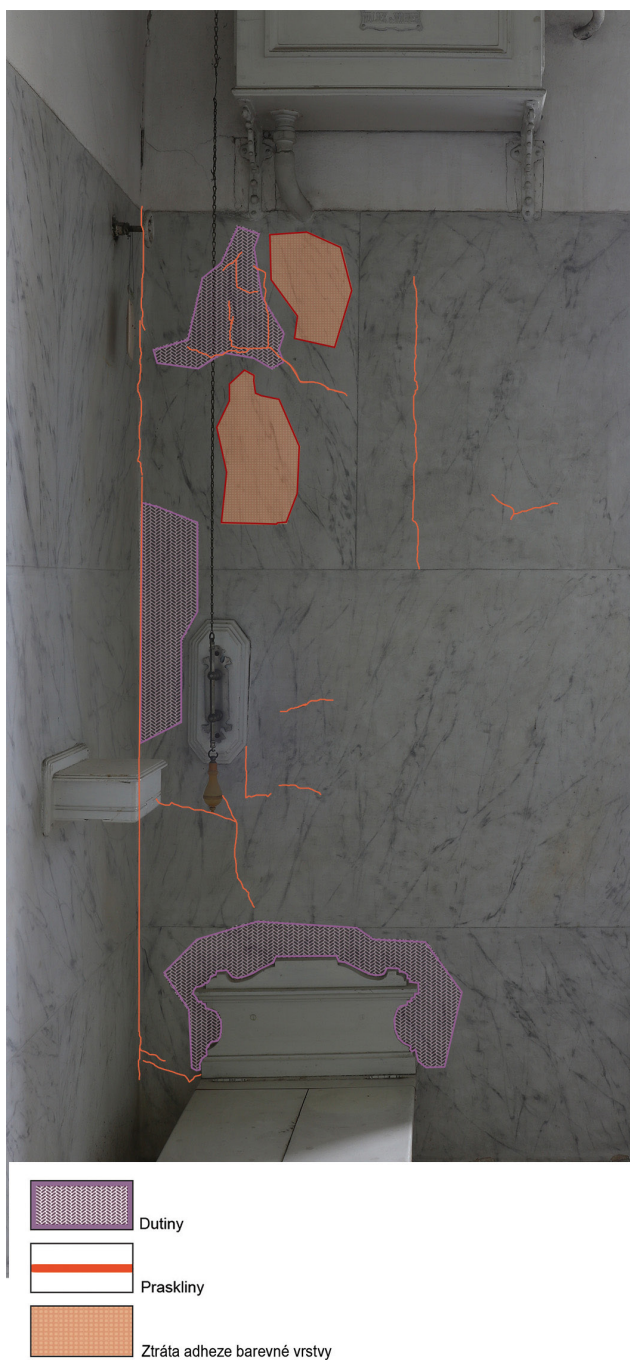
Obr. 01: Grafický zakres poškození. Severní část východní stěny.
