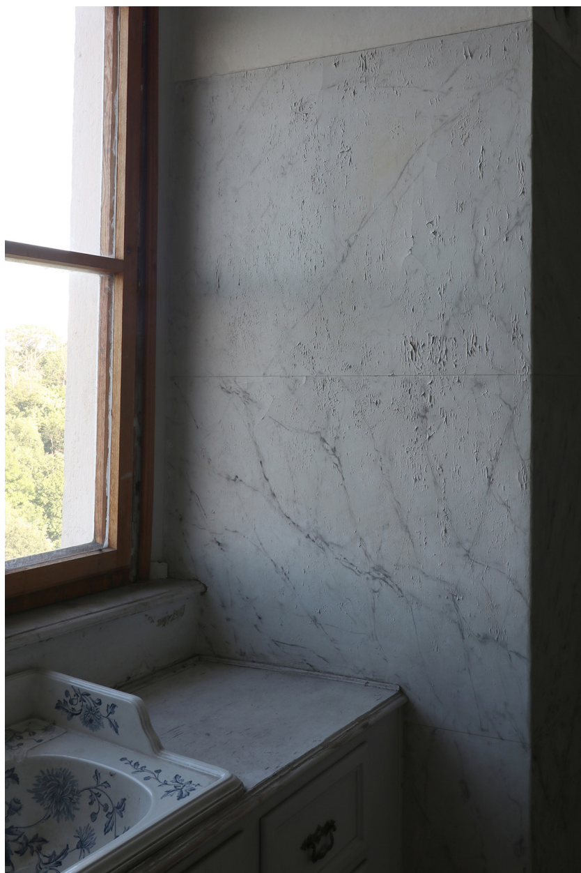
Obr. 13: Pohled na jižní špaletu okna ve východní stěně. Stav před restaurováním.
