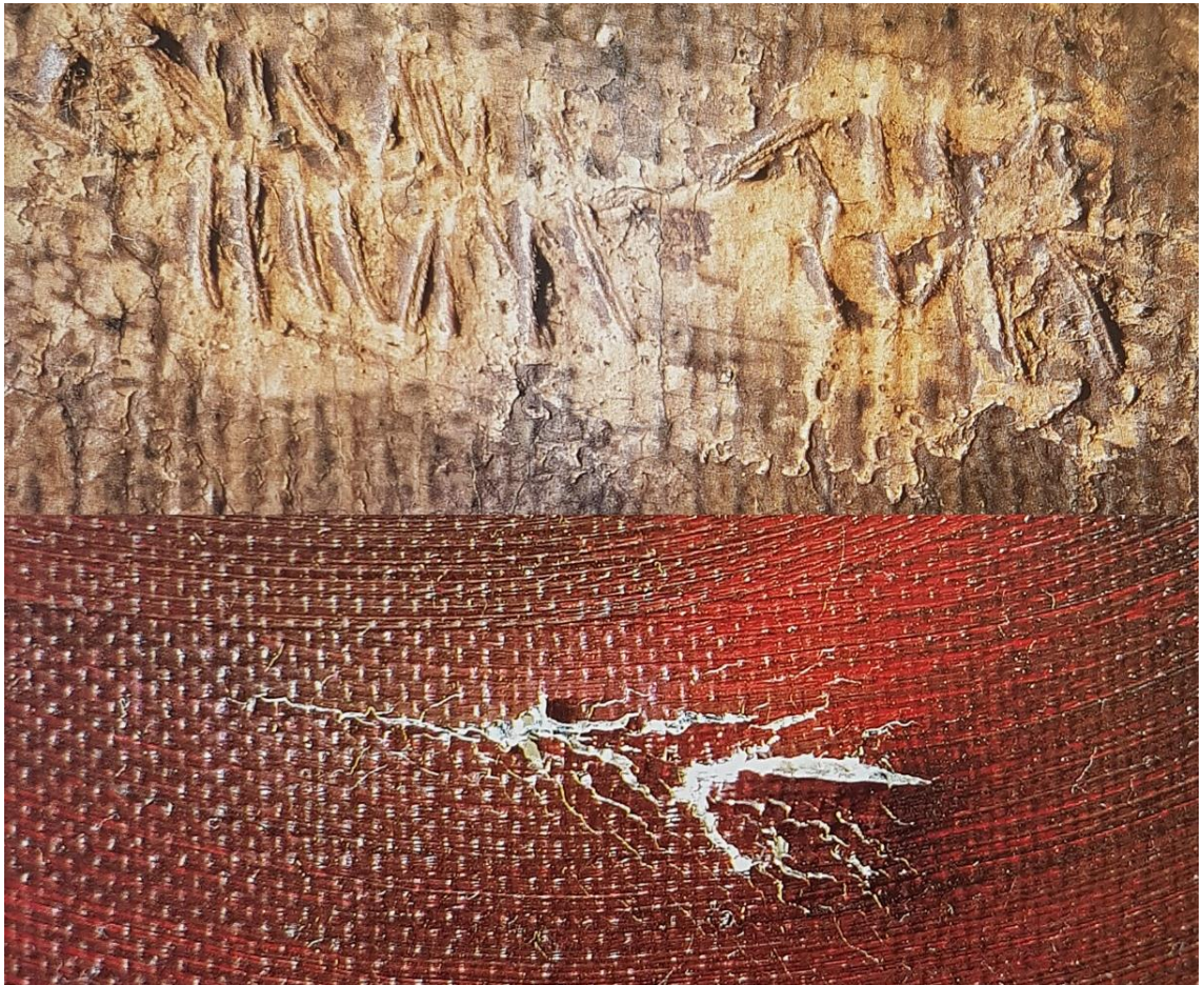
Obr. 118 Sešitá a zatmelená trhlina v plátně a vliv opatření z přední strany. In: NICOLAUS, Knut 1999, s. 113.
