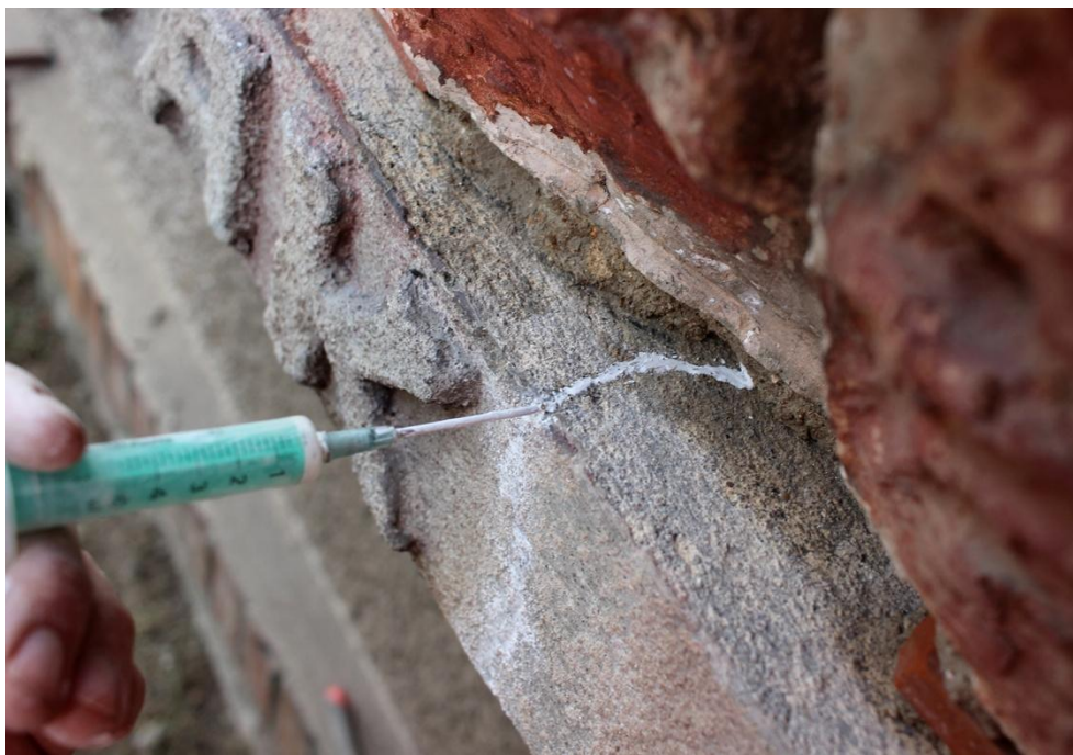
Obrázek 11: Injektáž Ledanu TBI injekční stříkačkou s jehlou.
