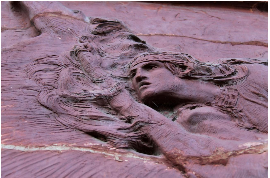
Obrázek 23: Detail zachované povrchové úpravy s odbarvenou spárkou, stav před restaurováním.
