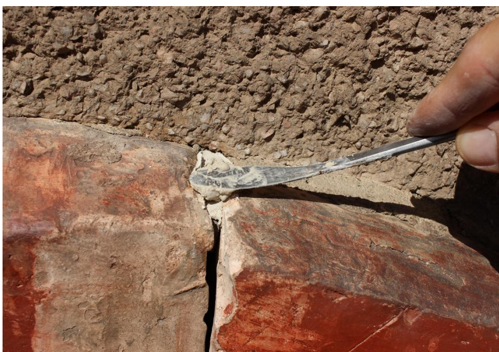
Obrázek 12: Spárování pomocí kovových špachtlí připraveným minerálním tmelem.
