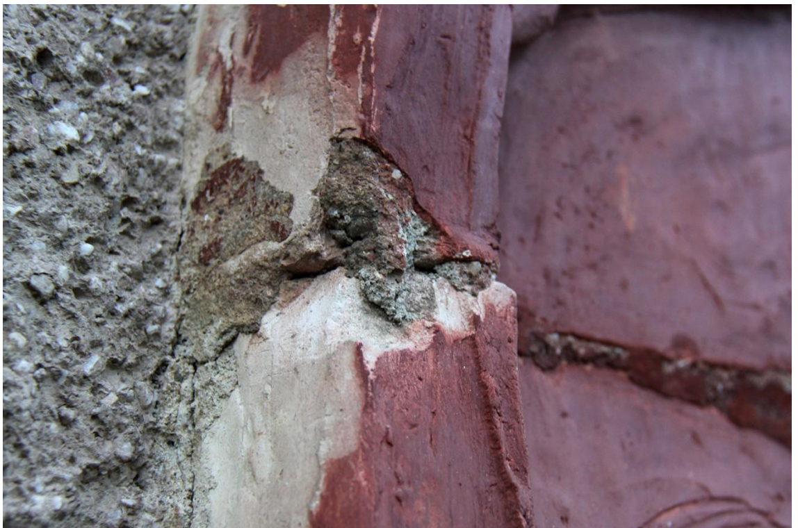
Obrázek 25: Detail dožilé spáry, stav před restaurováním.
