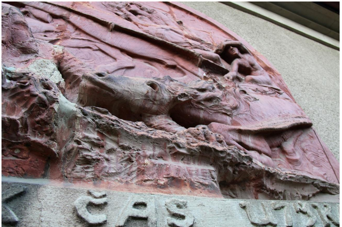
Obrázek 24: Vymytá barevnost po stékání vody, stav před restaurováním.
