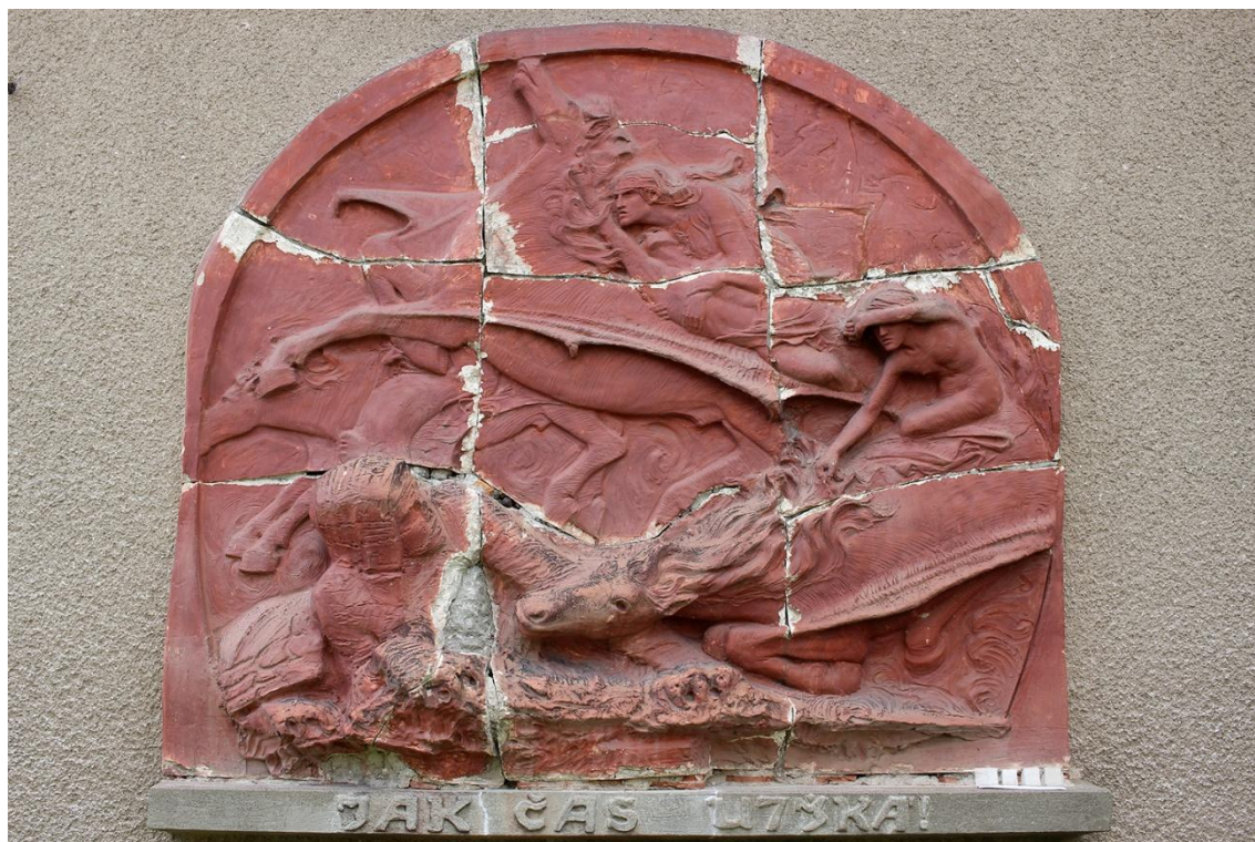
Obrázek 26: Hlavní pohled, stav po očištění a odstranění dožilých spár a tmelů.
