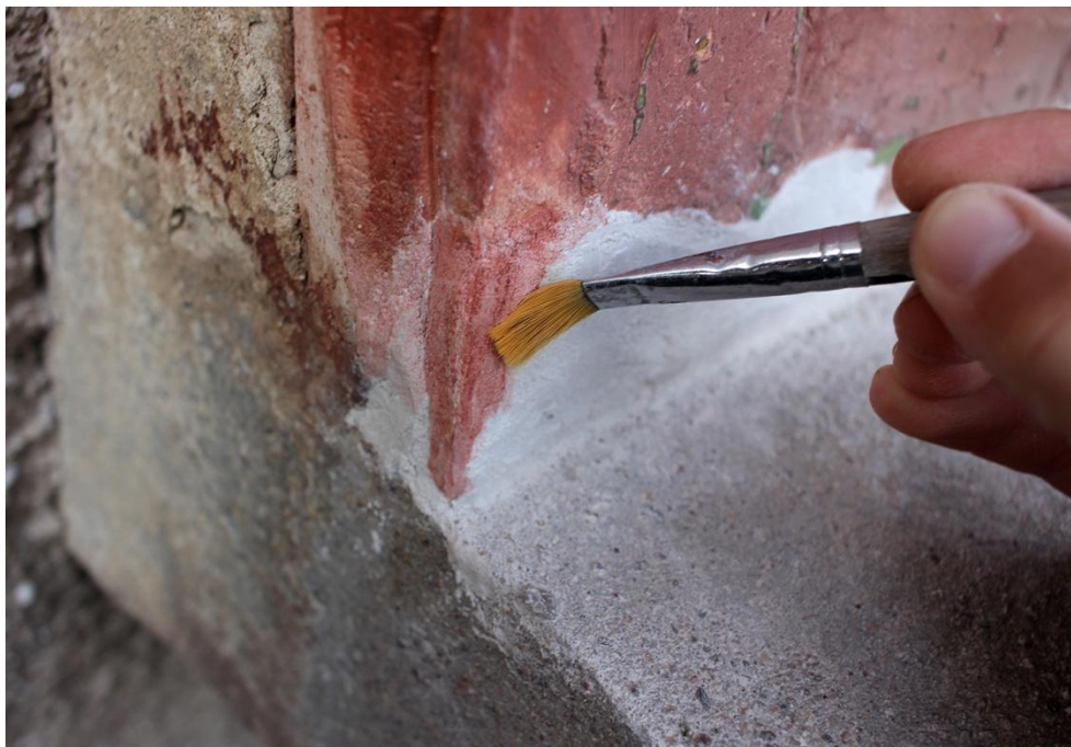
Obrázek 13: Retušování plastických doplňků barevnými pigmenty, které jsou pojeny v 5 % akrylátové disperzi K9 a jsou nanášeny štětcí.
