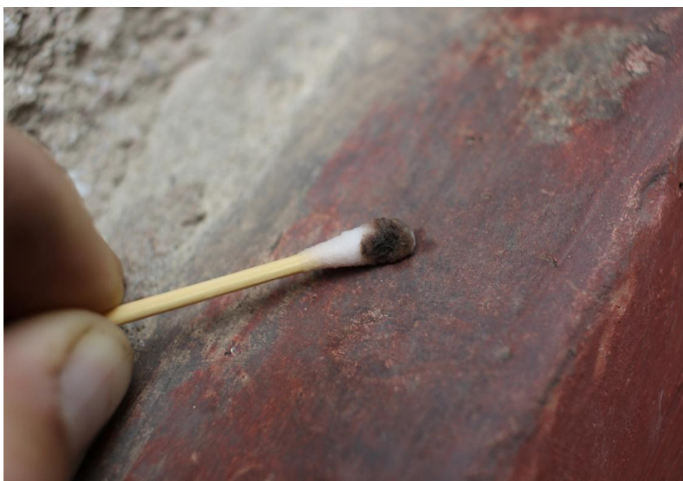
Obrázek 7: Čištění tmavých depozitů za pomoci vatových tyčinek a demineralizované vody.
