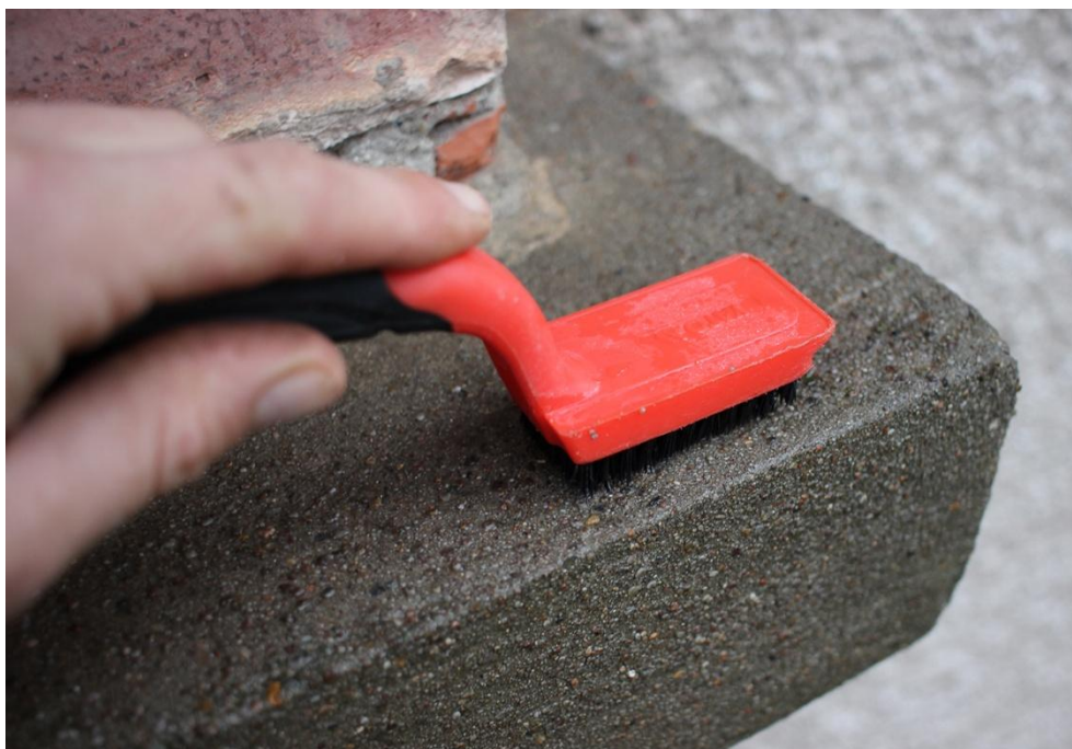
Obrázek 8: Čištění podstavce od prachových depozitů a biologického znečištění demineralizovanou vodou a kartáčem.
