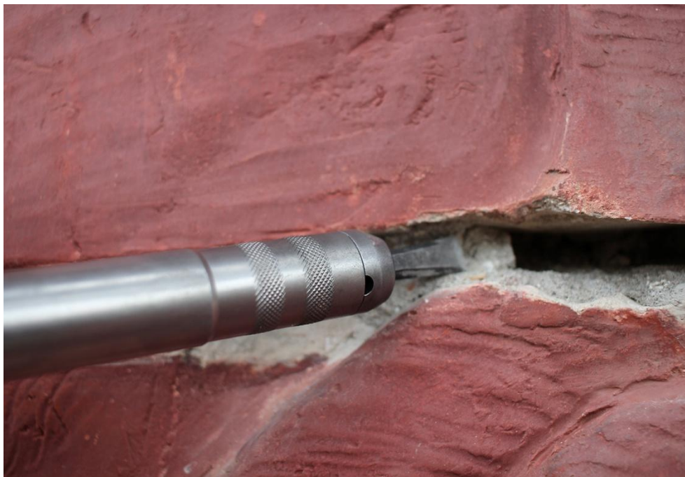
Obrázek 10: Odstraňování dožilých spár pomocí pneumatického mikrodláta.
