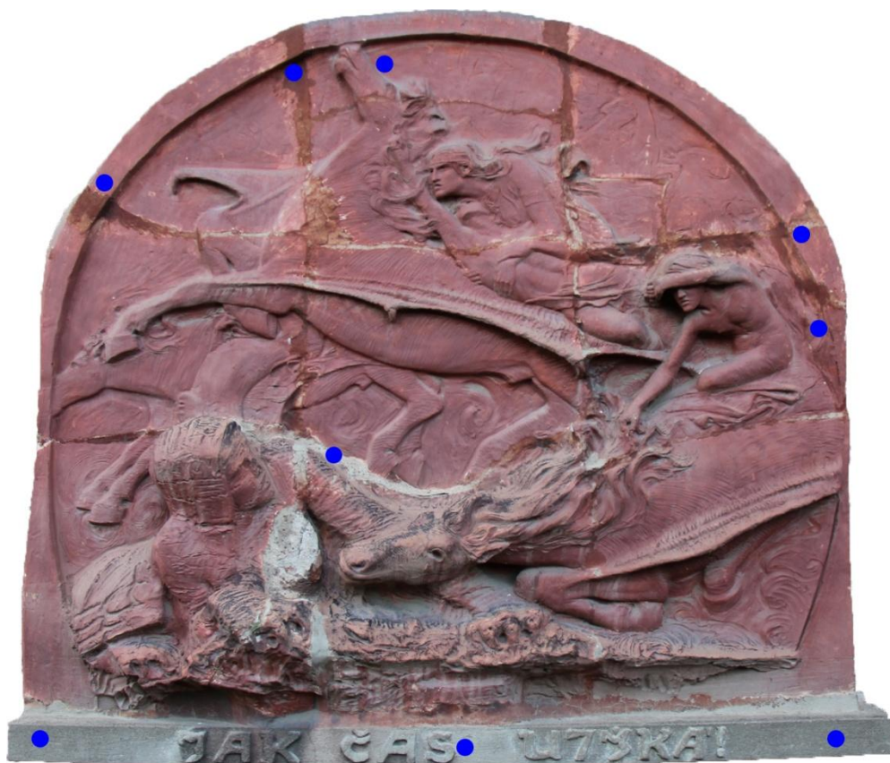
Obrázek 3: Orientační zakres kovových výztuh reliéfu a podstavce.
