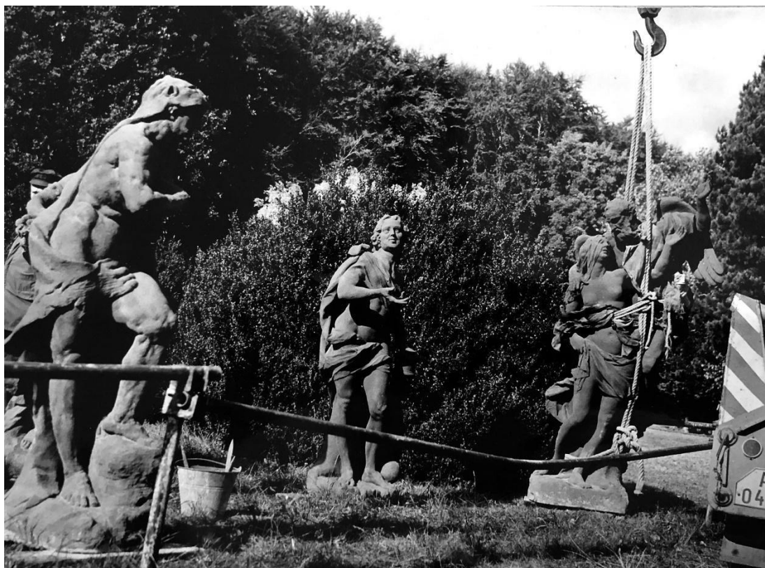
obr. 12 Osazení faksimilií z umělého kamene pojeného epoxidovou pryskyřicí v zahradách zámku Valeč, Autor reprodukce Renata Tišlová 102
