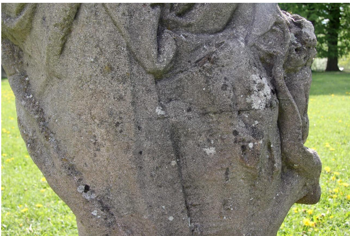
obr. 22 Horizontální praskliny také u faksimilií z umělého kamene pojeného cementem
