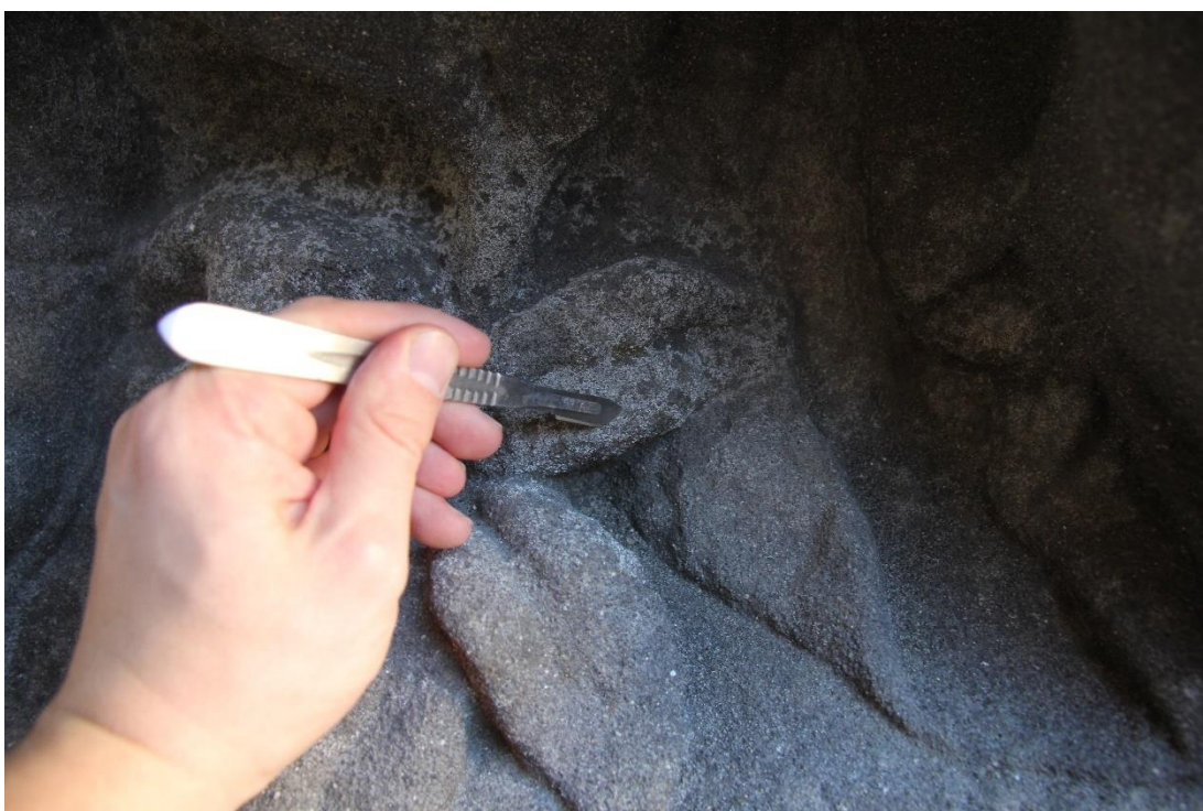
obr. 68 Předčištění biologického napadení pomocí skalpelu
