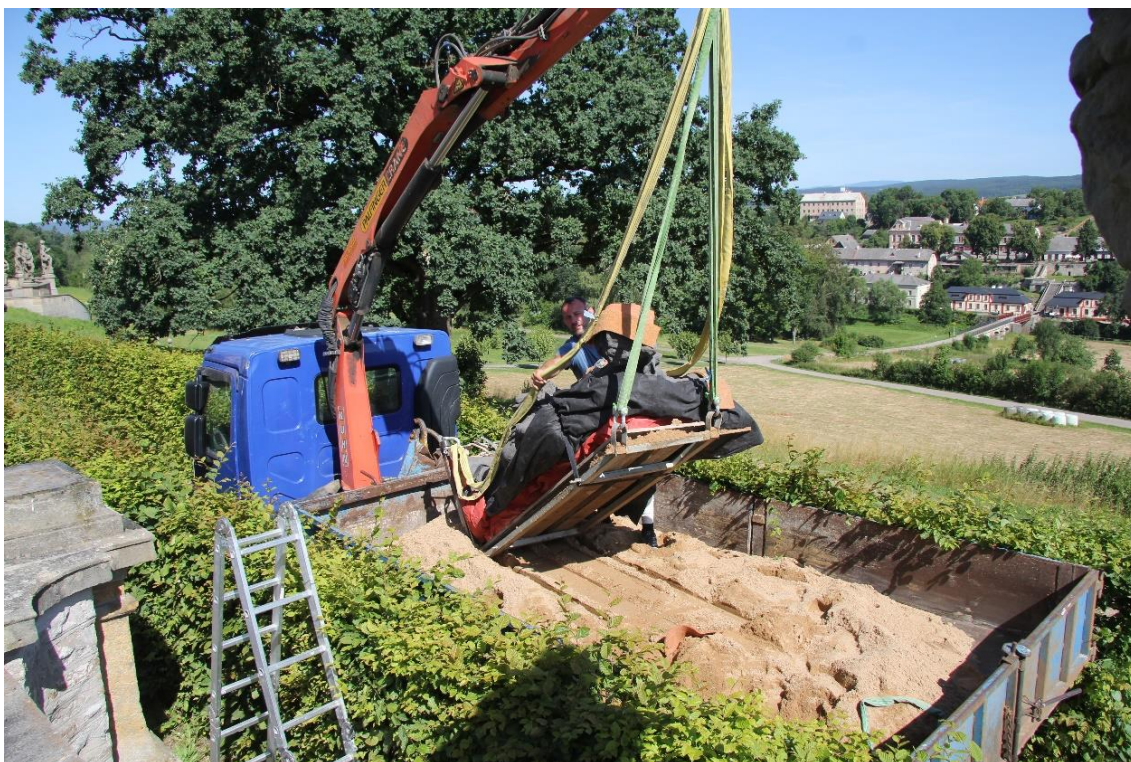
obr. 79 Osazení pomocí auto jeřábu
