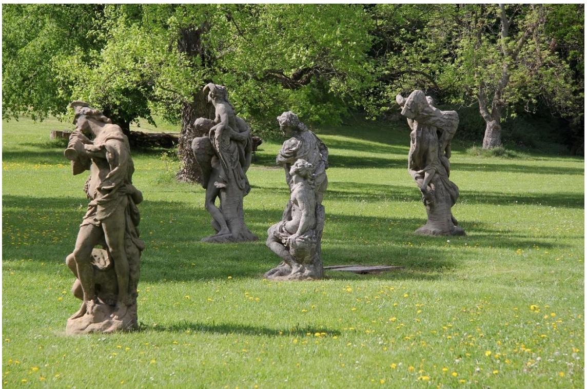
obr. 24 Pohled na soubor faksimilií, které se v závislosti na typu pojiva vyznačují odlišnou barevností – nažloutlý je epoxidový výdusek, betonové výdusky jsou šedé s výraznější kolonizací mechy a lišejníků.
