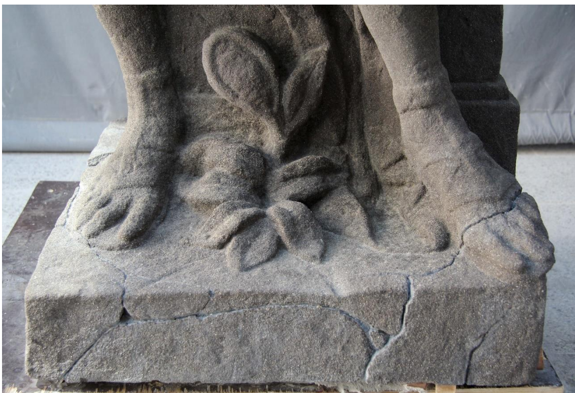
obr. 102 Detail vyinjektovaných prasklin ve spodní části faksimile
