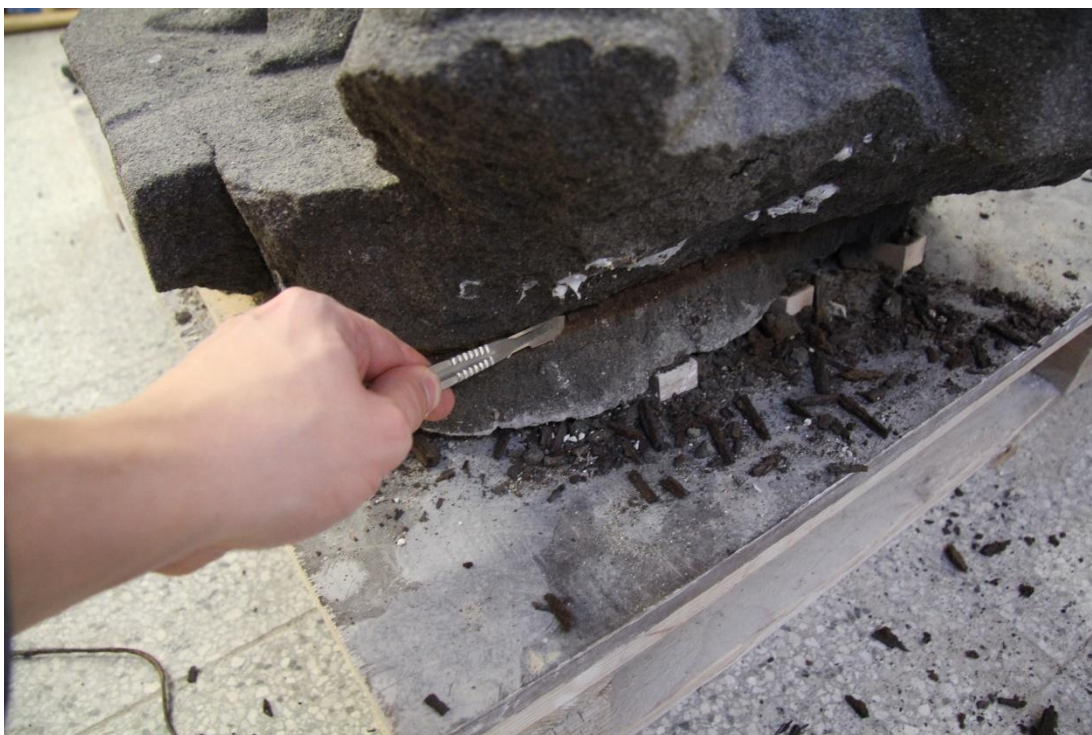
obr. 69 Šetrné odstraní korodované armatury a reziduí mechanicky pomocí skalpelu
