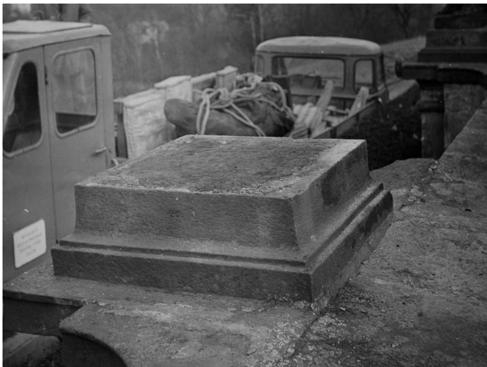
obr. 7 Podstavec na zdi hospitálu Kuks bez čepu 86
