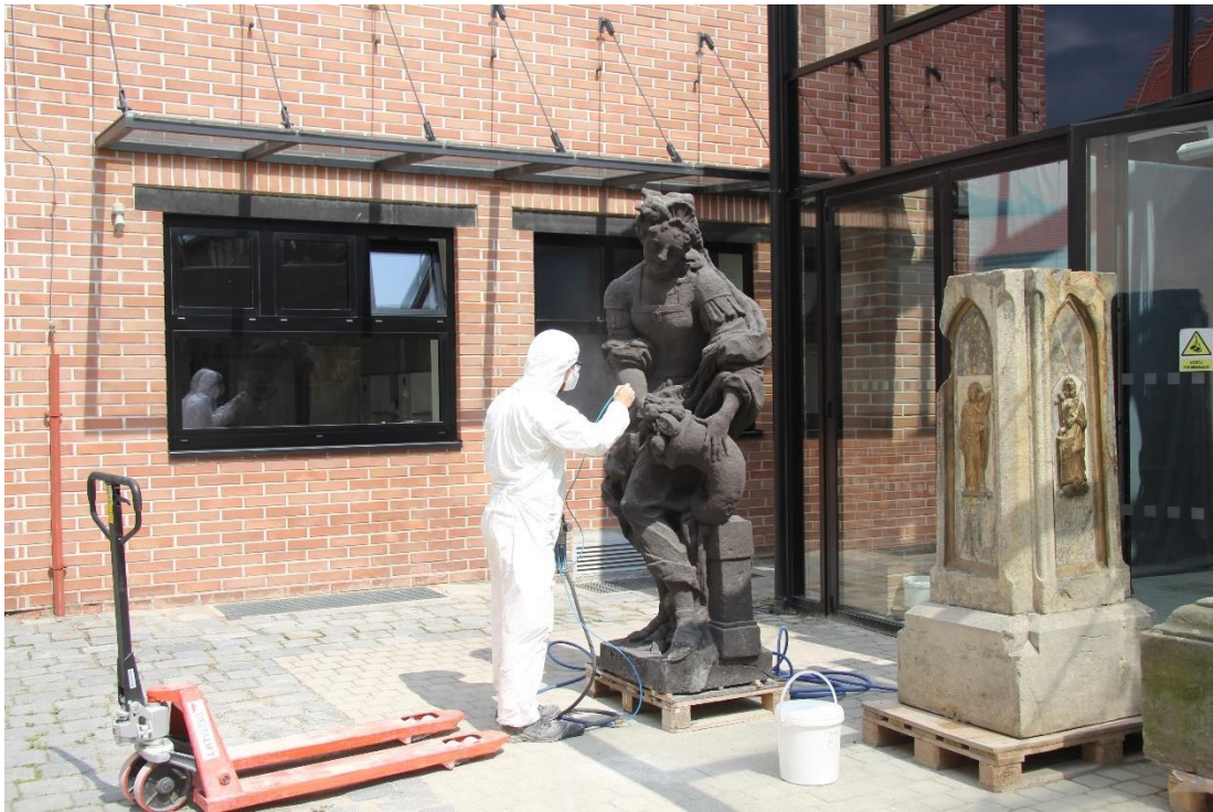
obr. 74 Čistění a potlačení prohloubené barevnosti abrazivní metodou
