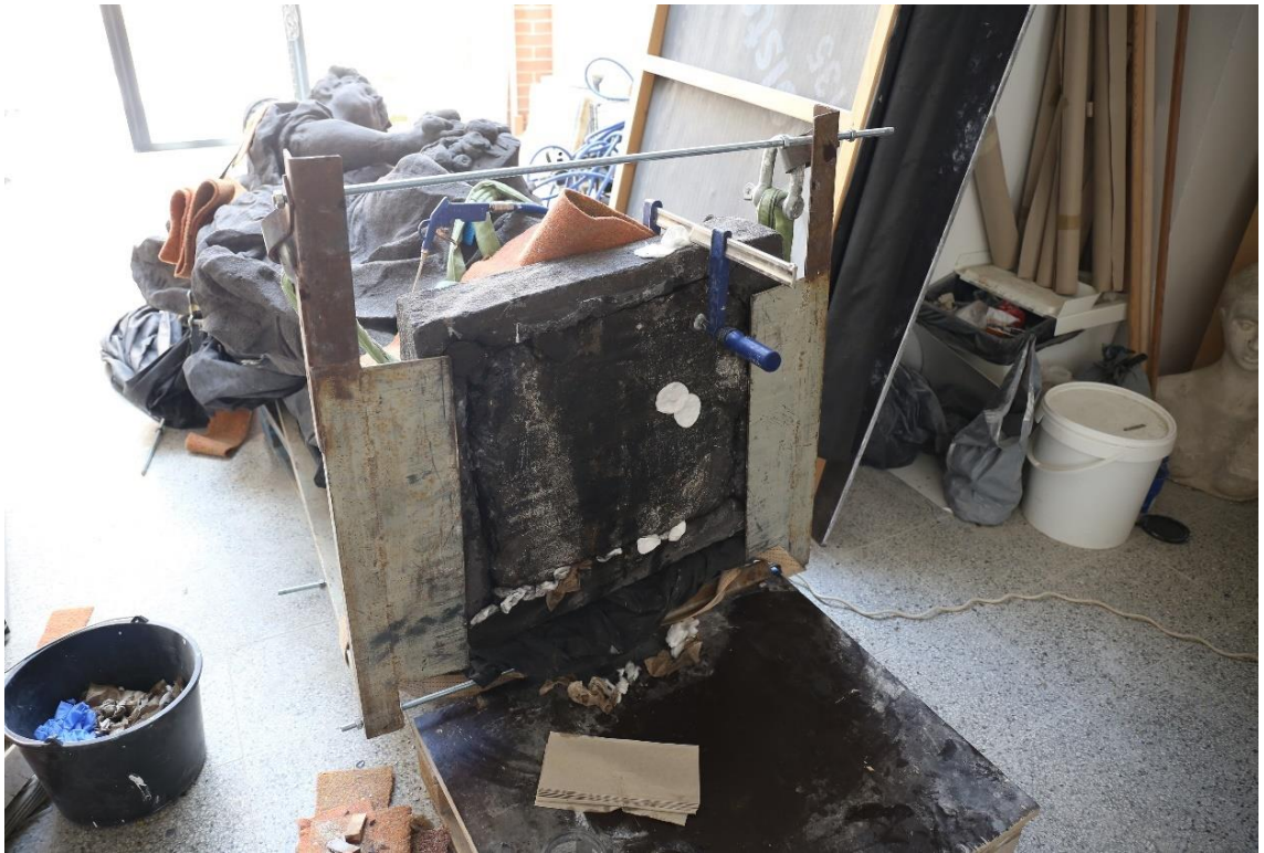
obr. 105 Injektáž prasklin ve spodní části faksimile
