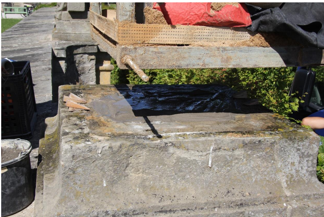
obr. 127 Osazení faksimile na maltu
