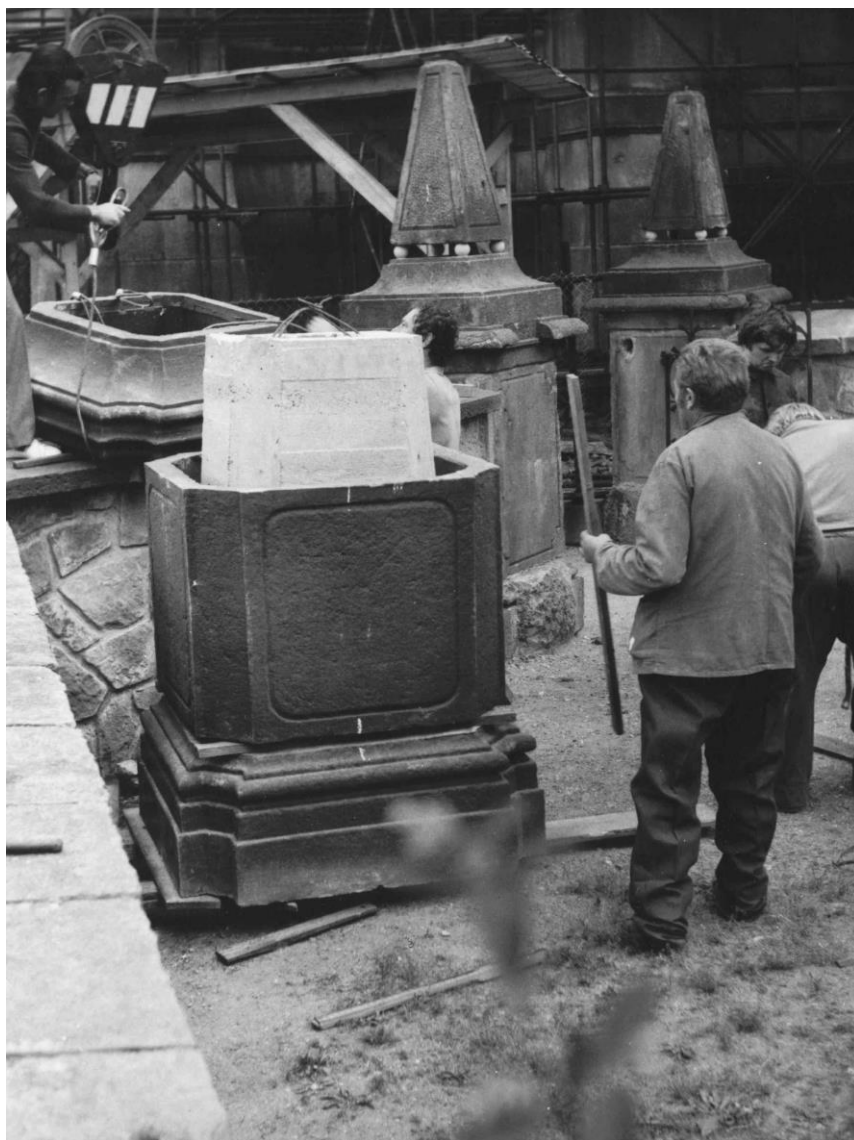
obr. 147 Skládání podstavce pod faksimilií sochy Náboženství se samotným železobetonovým jádrem 170
