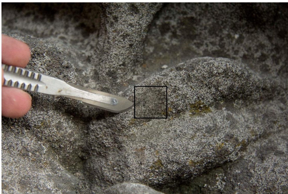
obr. 56 Zkouška čištění biologického napadení pomocí skalpelu a tvrdých štětců
