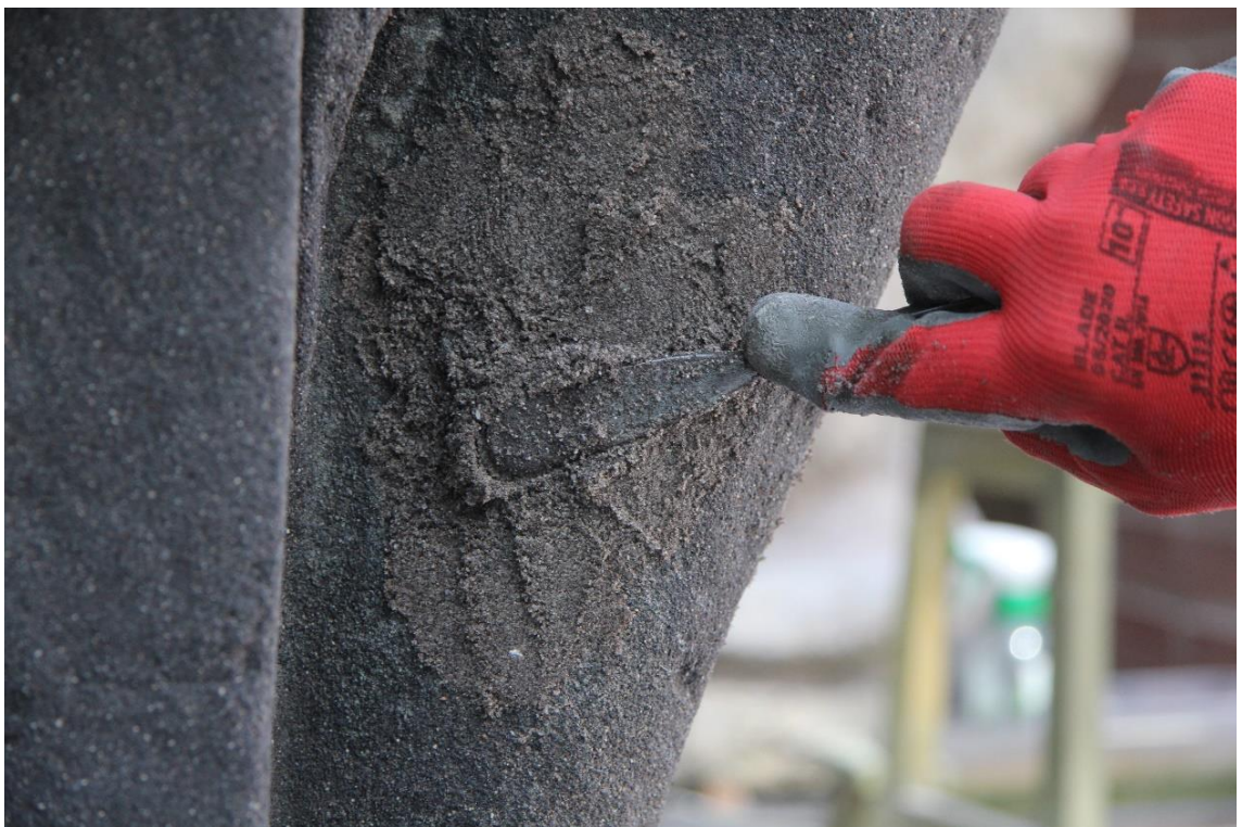
obr. 77 Detail průběhu plastické retuše
