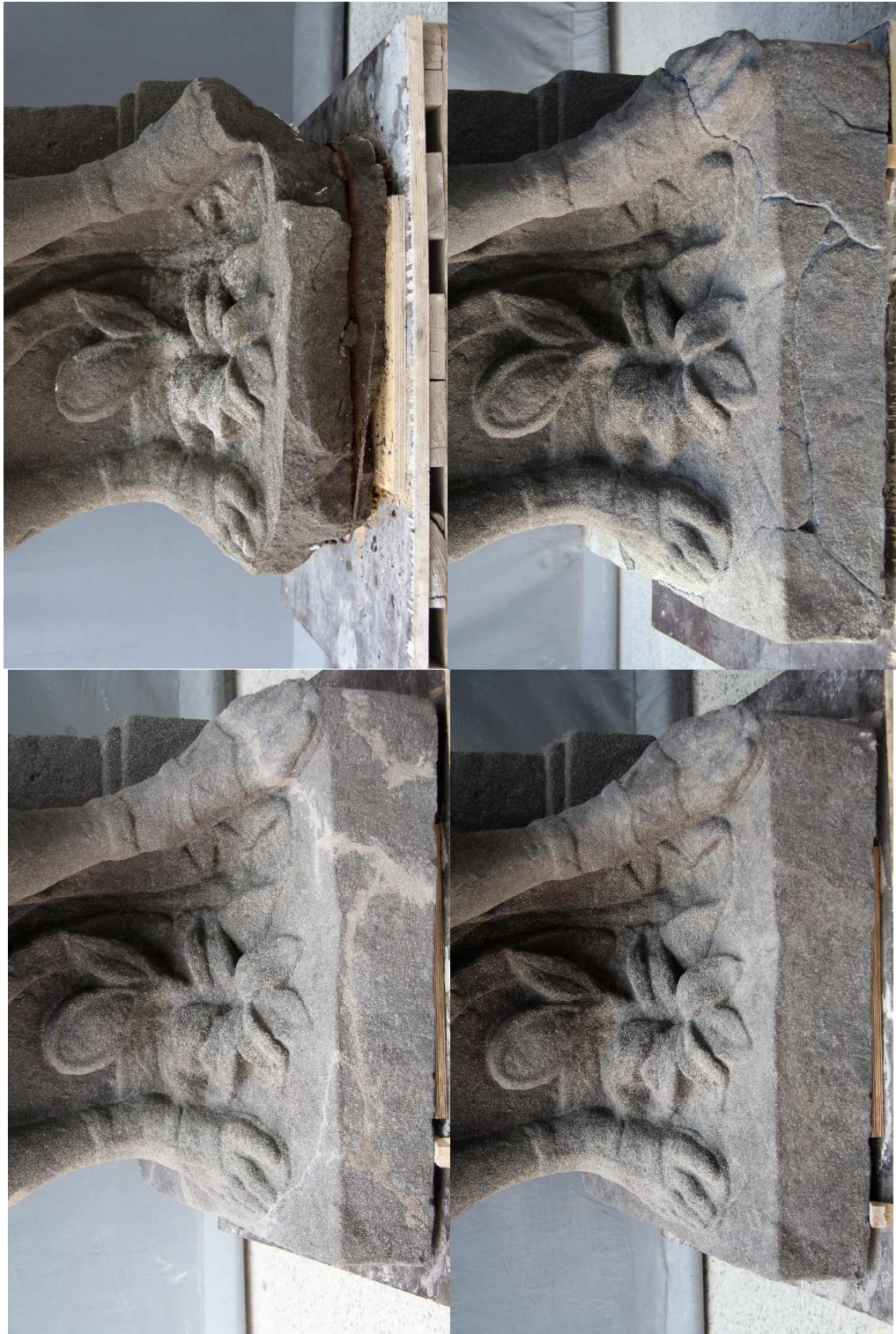
obr. 133 Detail spodní části faksimile, stav před restaurování, stav po slepení, očištění a potlačení barevnosti, stav po plastické retuši, stav po barevné retuši
