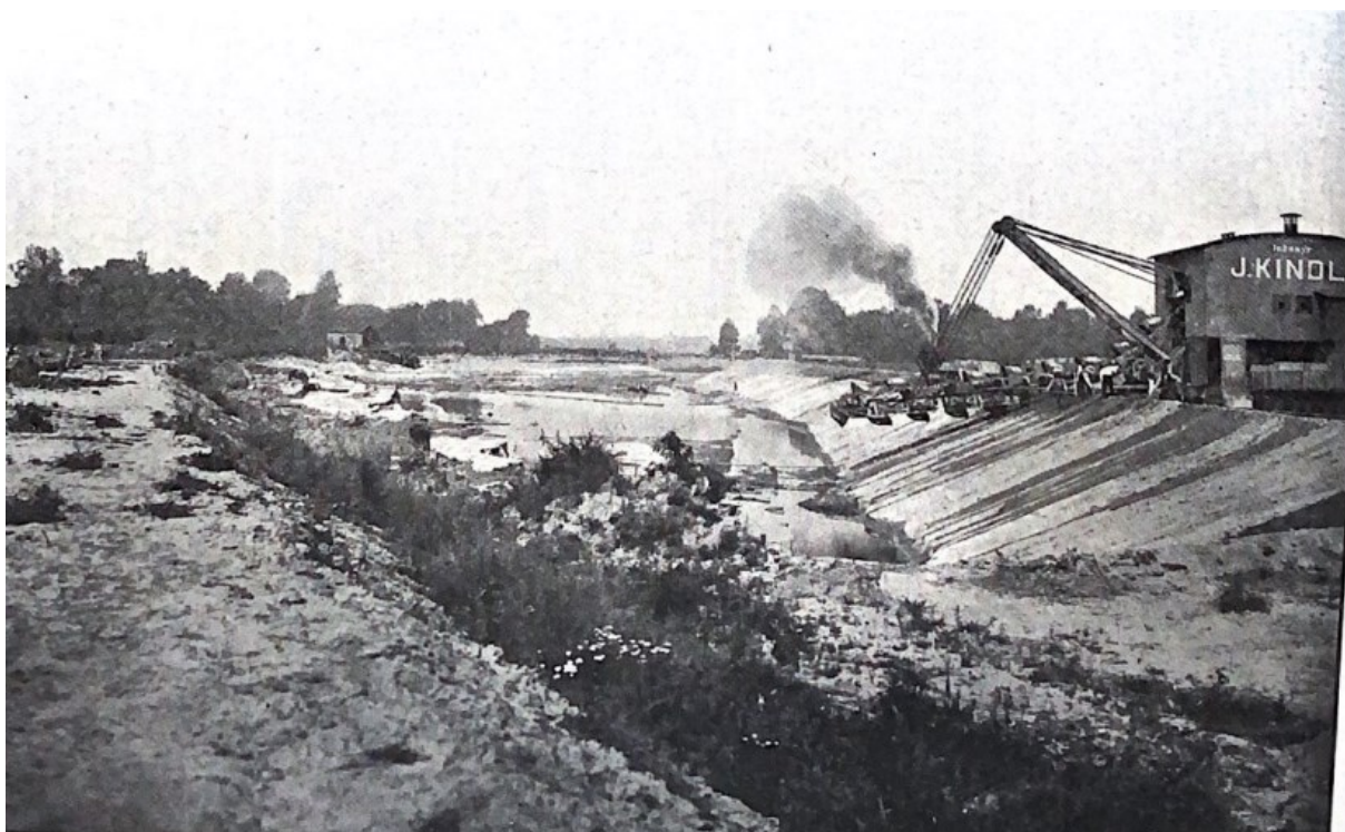
Obrázek č. 21: Pohled po vodě na práce v průkopu na Kaštance v Obříství, 21 srpen 1909, Střední Labe upravené a uplavněné : roč 8, č. 2, s. 30.
