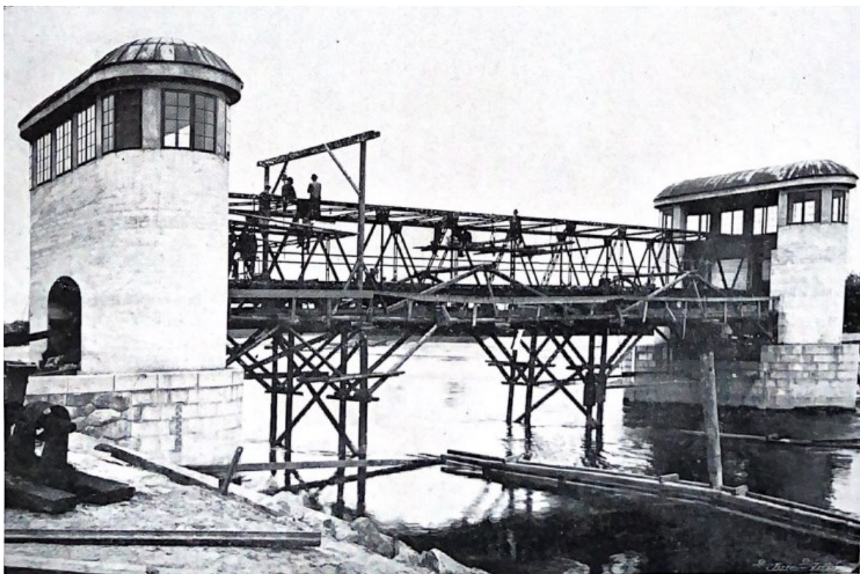
Obrázek č. 47: Pohled na opravené montovací lešení a stav prací montážních, počátek května 1912, Střední Labe upravené a uplavněné : r. 10, č. 8, s. 135.
