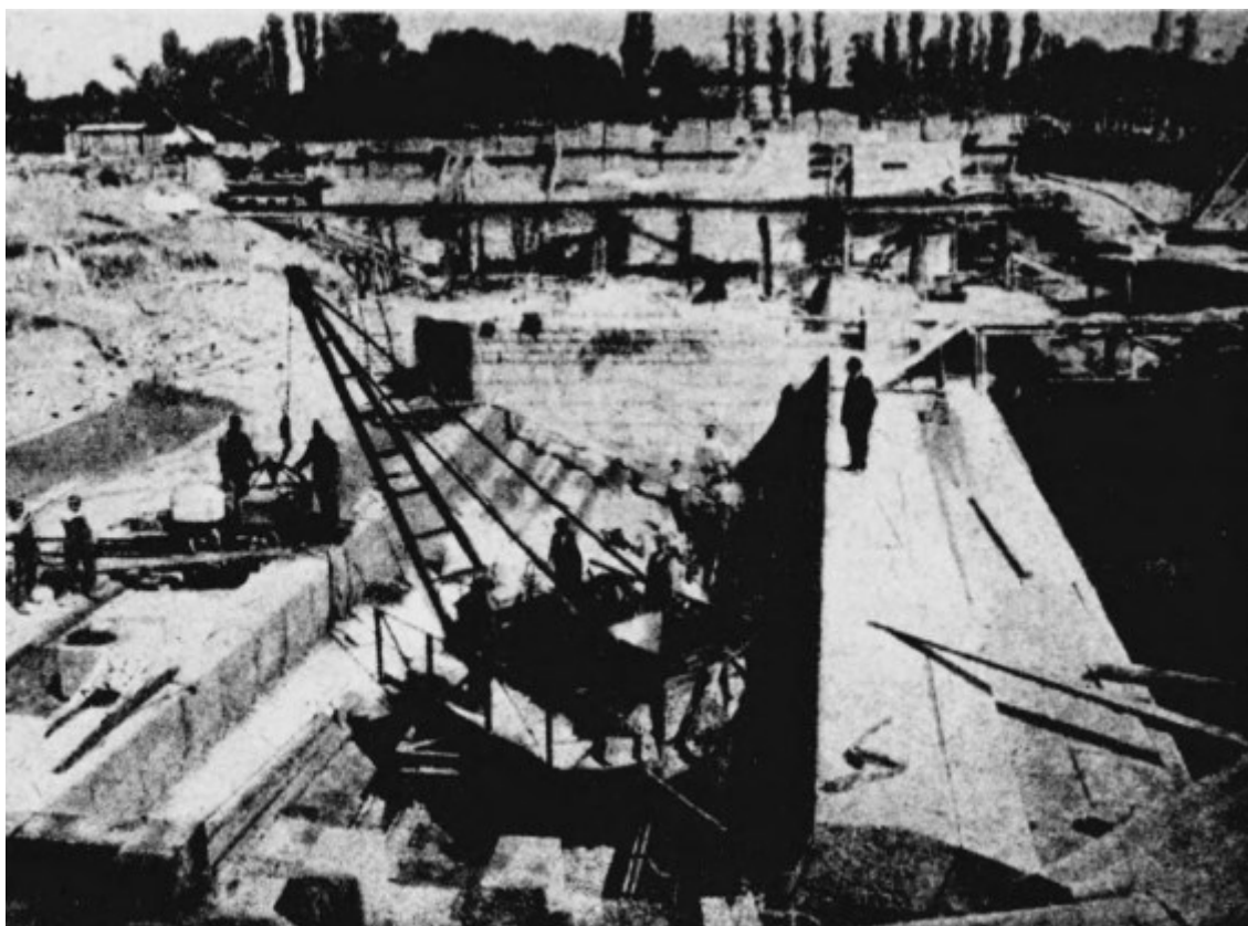
Obrázek č. 90: Pohled na opevňovací práce na pravém břehu, Výroční zpráva vodocestných prací na středním Labi a Vltavě v roce 1916, Technický obzor 1918 Tab. 12.
