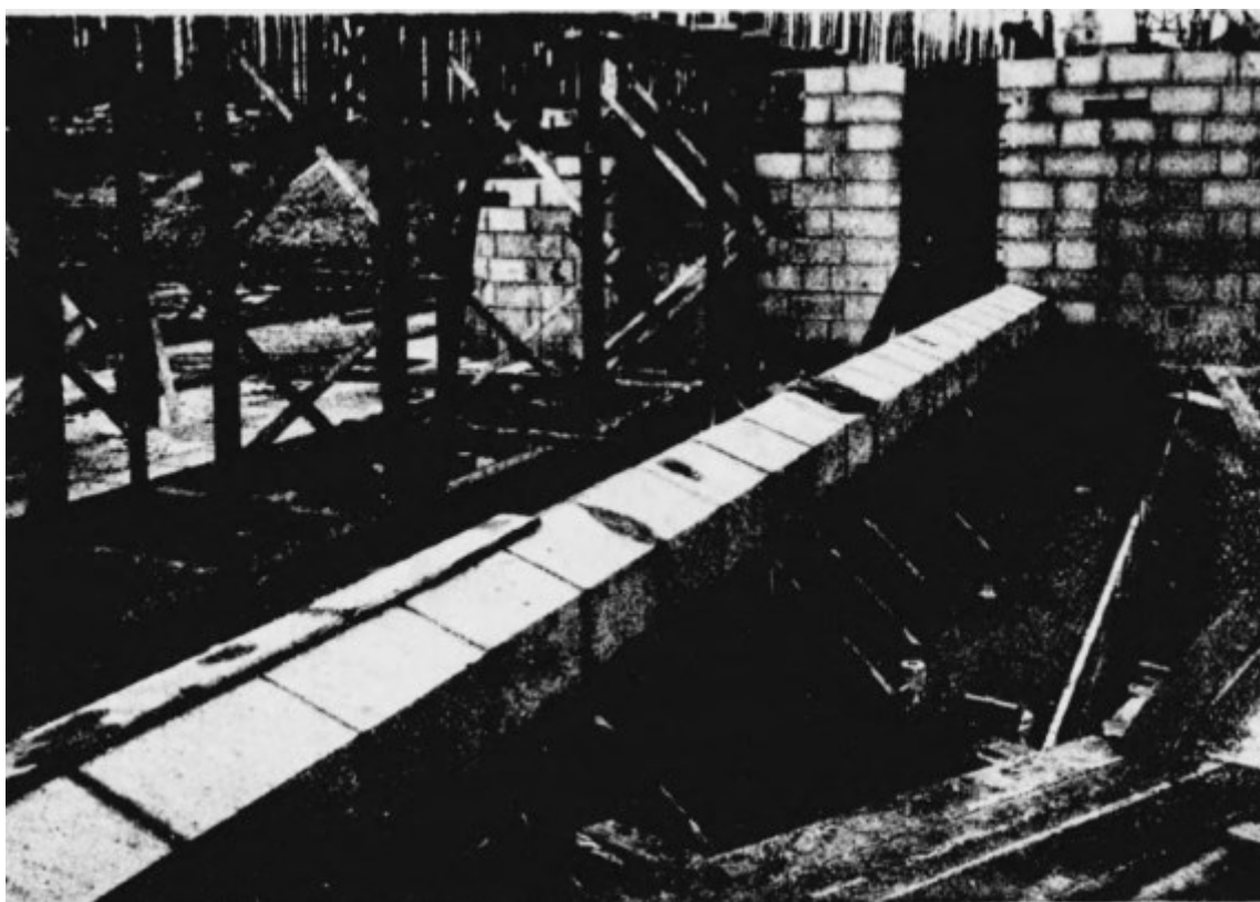
Obrázek č. 80: Poděbrady stavba jezu střední otvor, Technický obzor 1916 Tab. 34.
