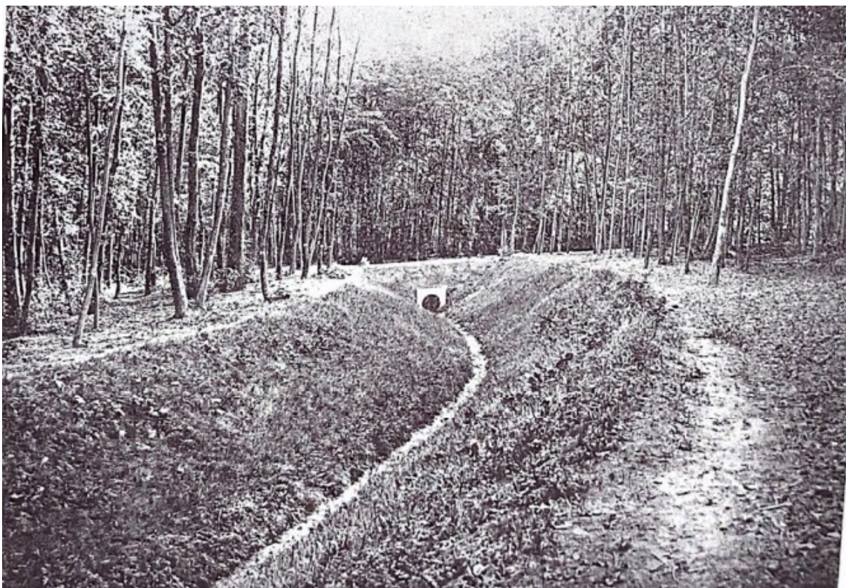
Obrázek č. 38: Rourový propustek při styku odvodňovacích příkopů v Zámeckém lese u Obříství, Střední Labe upravené a uplavněné : roč. 9, č. 10, s. 177.
