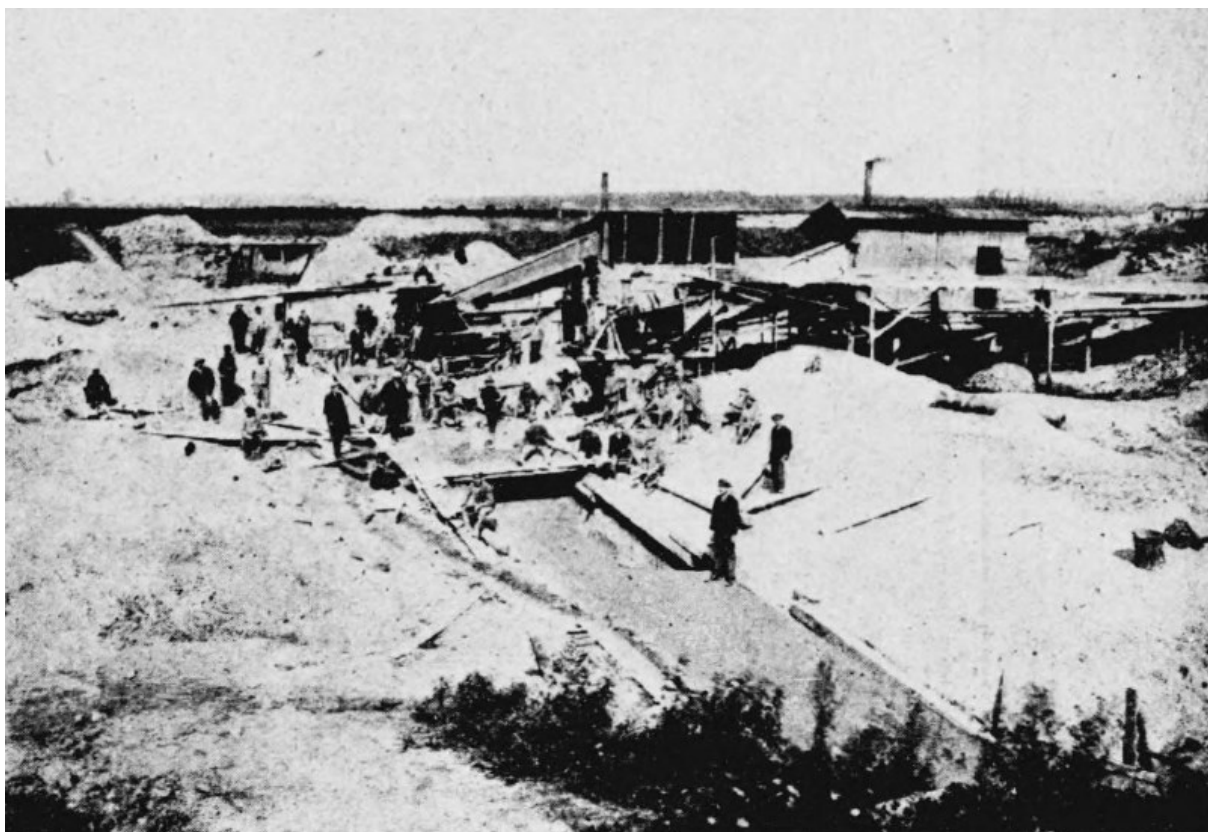
Obrázek č. 63: Betonování shybky u Chvaletic-Kladrub, Technický obzor 1916, Tab. 22–24.
