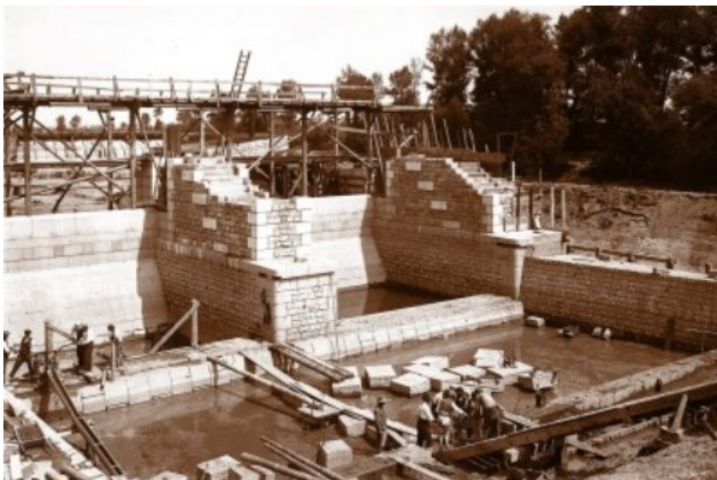
Obrázek č. 69: Staveniště spodní části jezu, 1914, zdroj: Povodí Labe státní podnik.
