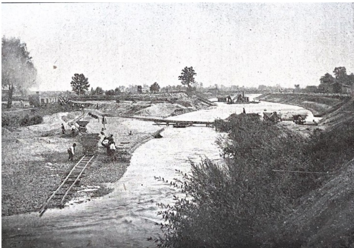
Obrázek č. 26: Pohled po vodě na regulační práce u Kydlínova, Střední Labe upravené a uplavněné : roč. 8, č. 11, s. 174.
