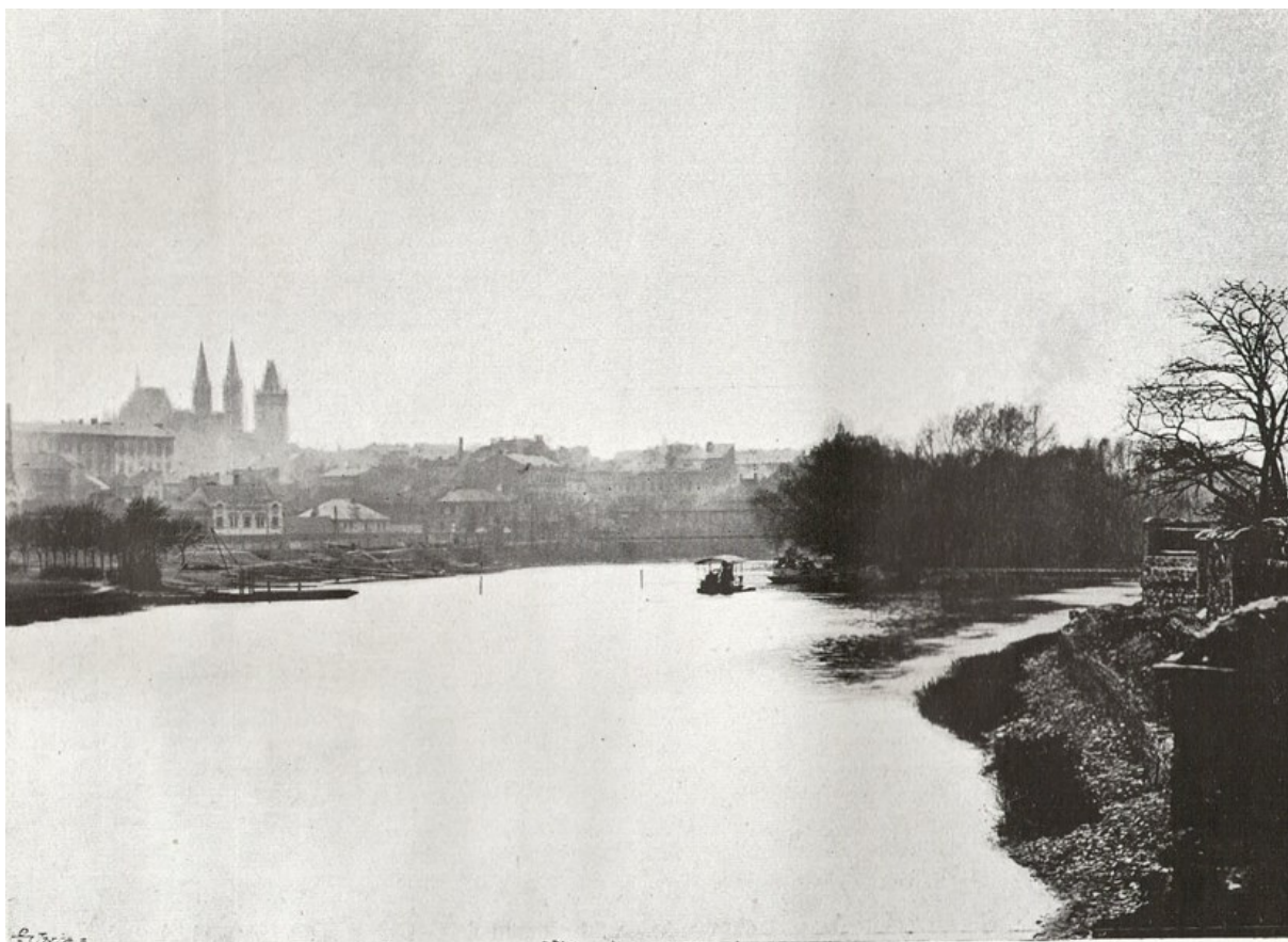
Obrázek č. 55: Pohled z pravostranného pilíře železničního mostu na Labe v Kolíně před regulací, Střední Labe upravené a uplavněné : roč. 11, č. 1, s. 20.
