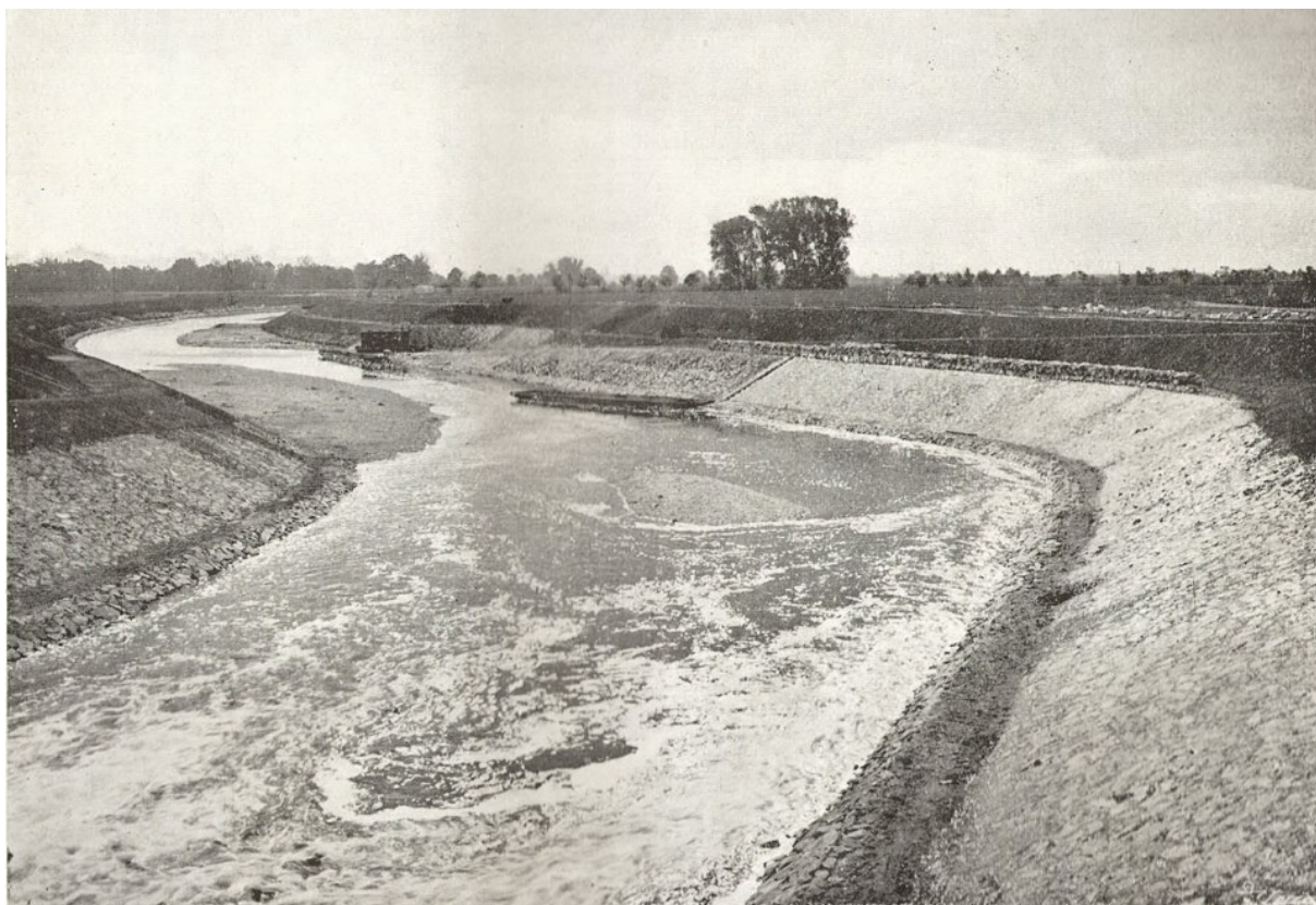
Obrázek č. 52: Pohled po proudu z mostu na regulované koryto u Předměřic, Střední Labe upravené a uplavněné : roč. 11, č. 1, s. 15.
