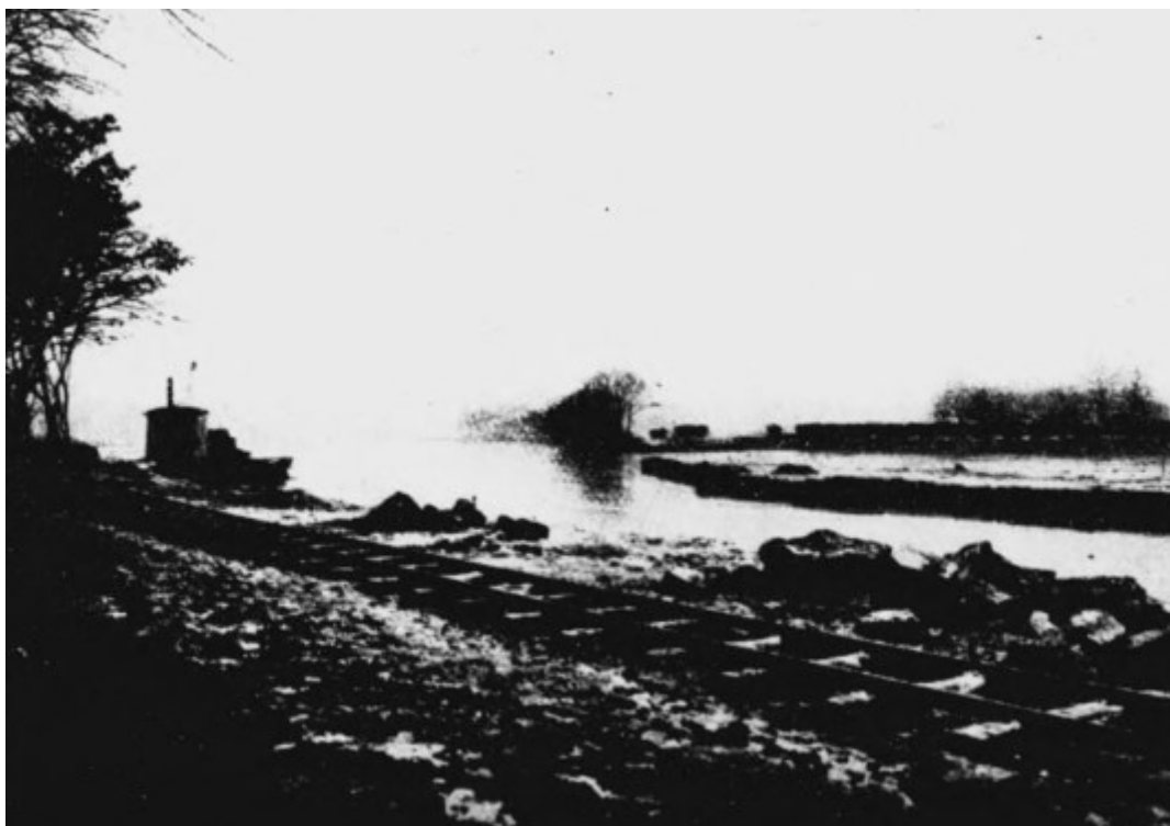
Obrázek č. 61: Litol pohled z levého břehu průkopu směrem po proudu během velké vody, Technický obzor 1916 , tab. 22–24.
