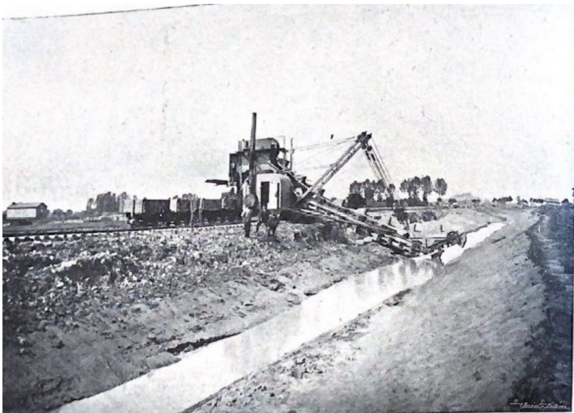
Obrázek. 12 Úprava toku u Pardubic za využití pozemního rypadla, Střední Labe upravené a uplavněné : roč. 7, č. 1, s. 12.
