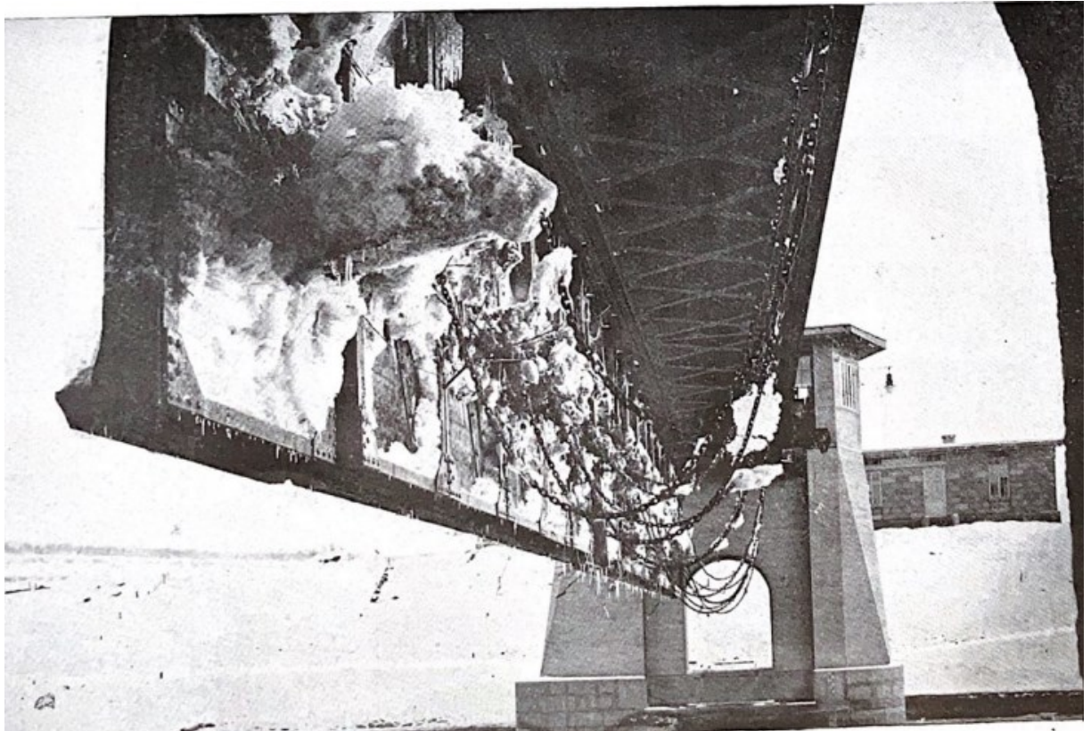
Obrázek č. 50: Pohled ze středního pilíře na led na rámech mostového jezu v Mělníce, Střední Labe upravené a uplavněné : roč. 10, č 8, s. 141.
