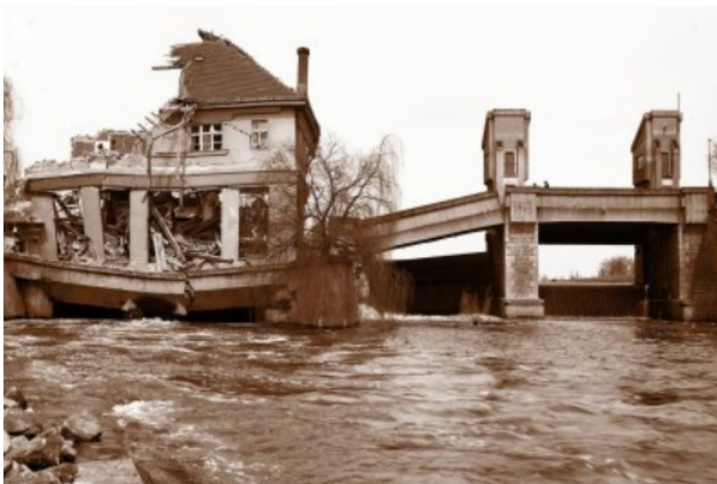
Obrázek č. 73: Zřícená vodní elektrárna s částí jezu, 11. dubna 1932, zdroj: státní podnik Povodí Labe.
