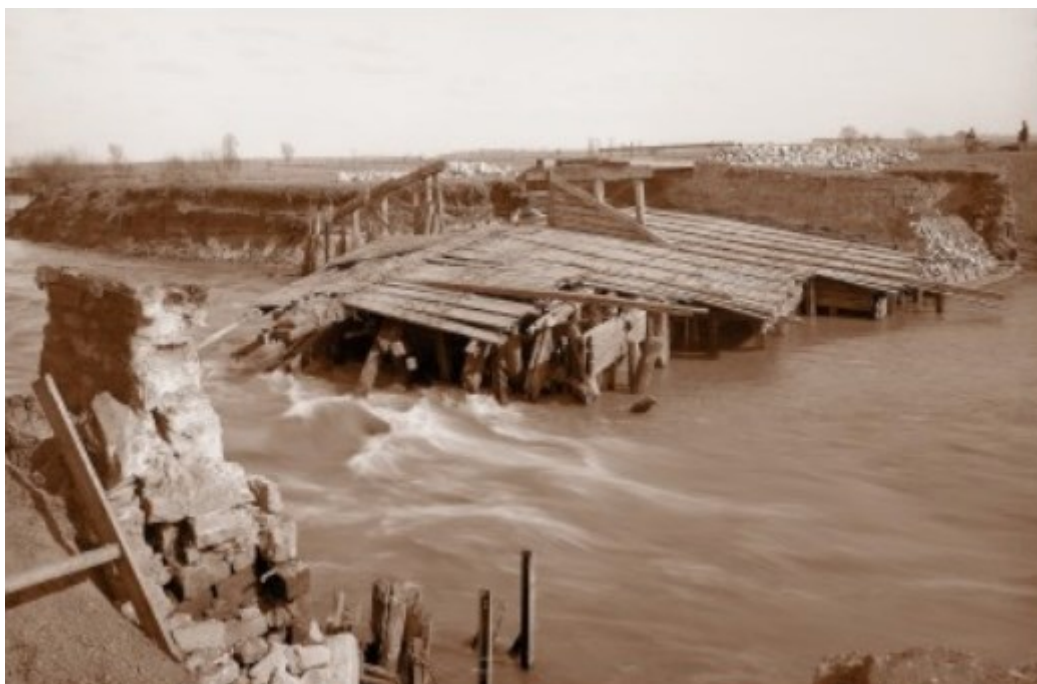
Obrázek č. 67: Pohled na zřícený jez z pravého břehu, 3. března 1918, zdroj Povodí Labe státní podnik.
