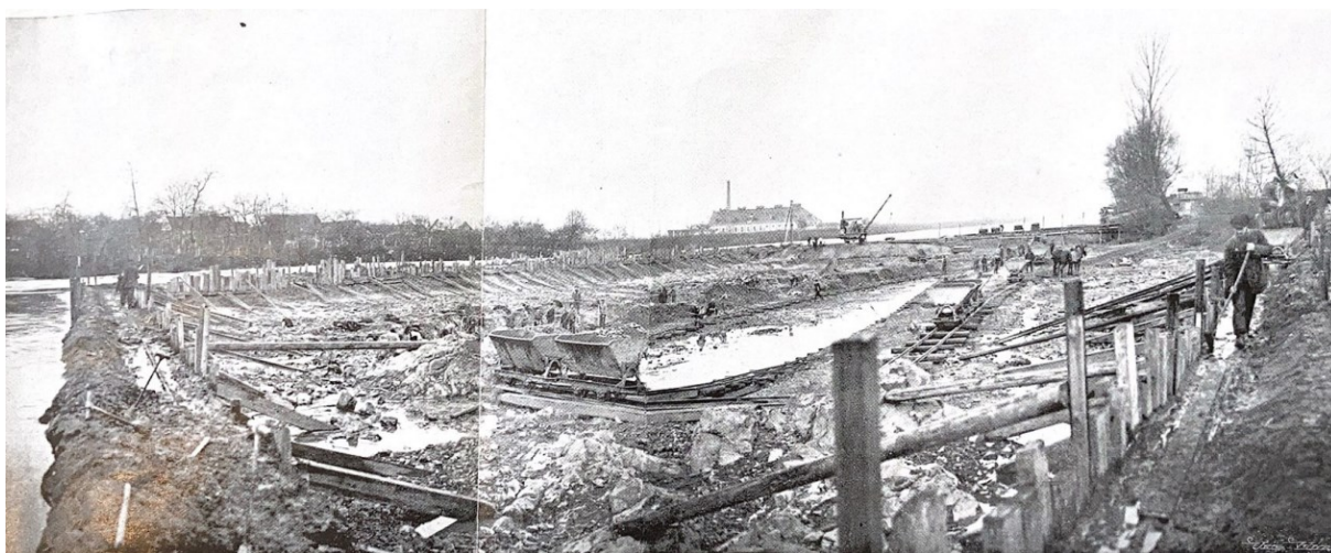
Obrázek č. 51: Pohled na odvodňování skalisek v korytě labském, poblíž železničního mostu severní dráhy u Neratovic 20. listopad 1912, Střední Labe upravené a uplavněné : r. 10, č. 8, s. 132.
