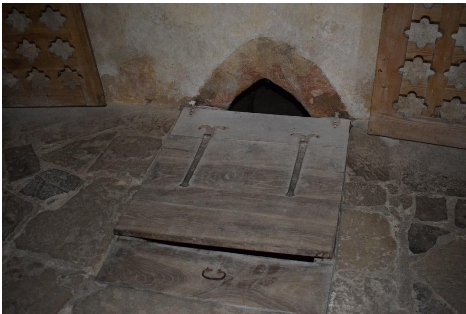
Obrázek 13 – Poklop kryjící vstup do podzemní chodby pod kryptou svatě Kateřiny
