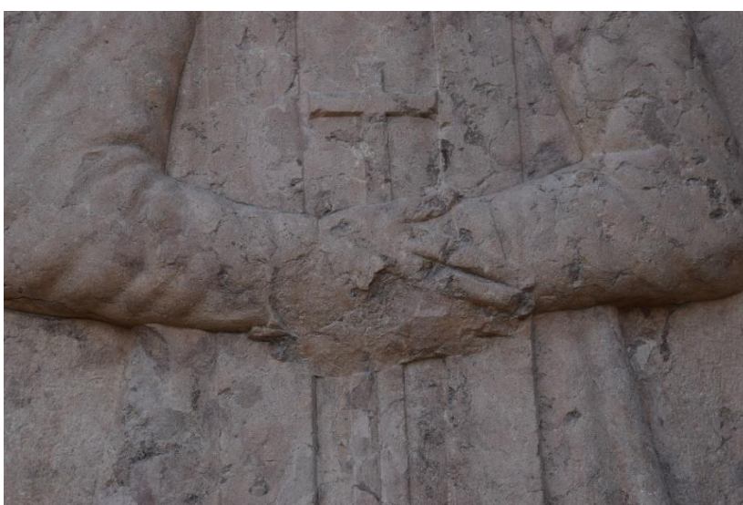
Obrázek 119 – Detail rukou na náhrobníku. Ruce jsou silně poškozené, pod nimi je vložen křížek
