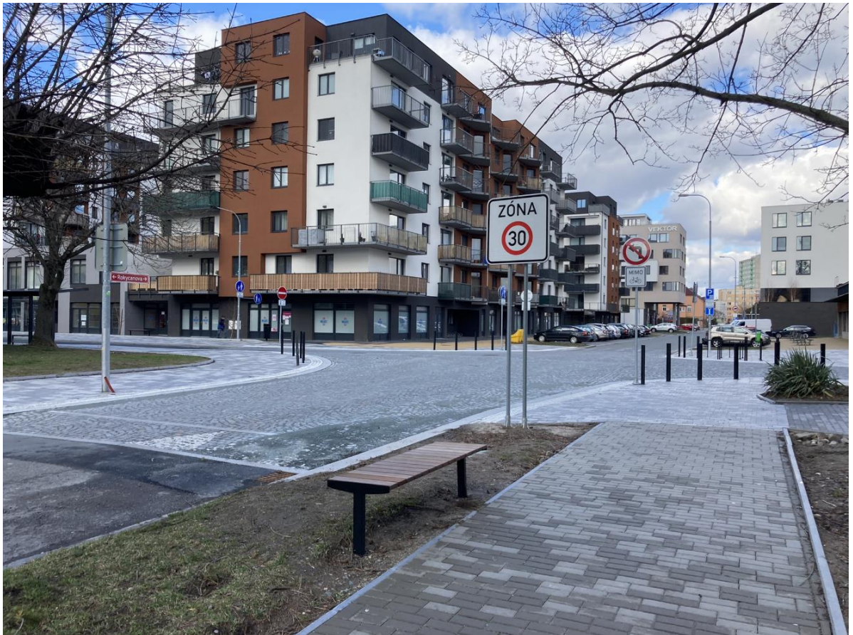
Obrázek 5 Zvýšená křižovatka – Na Spravedlnosti
