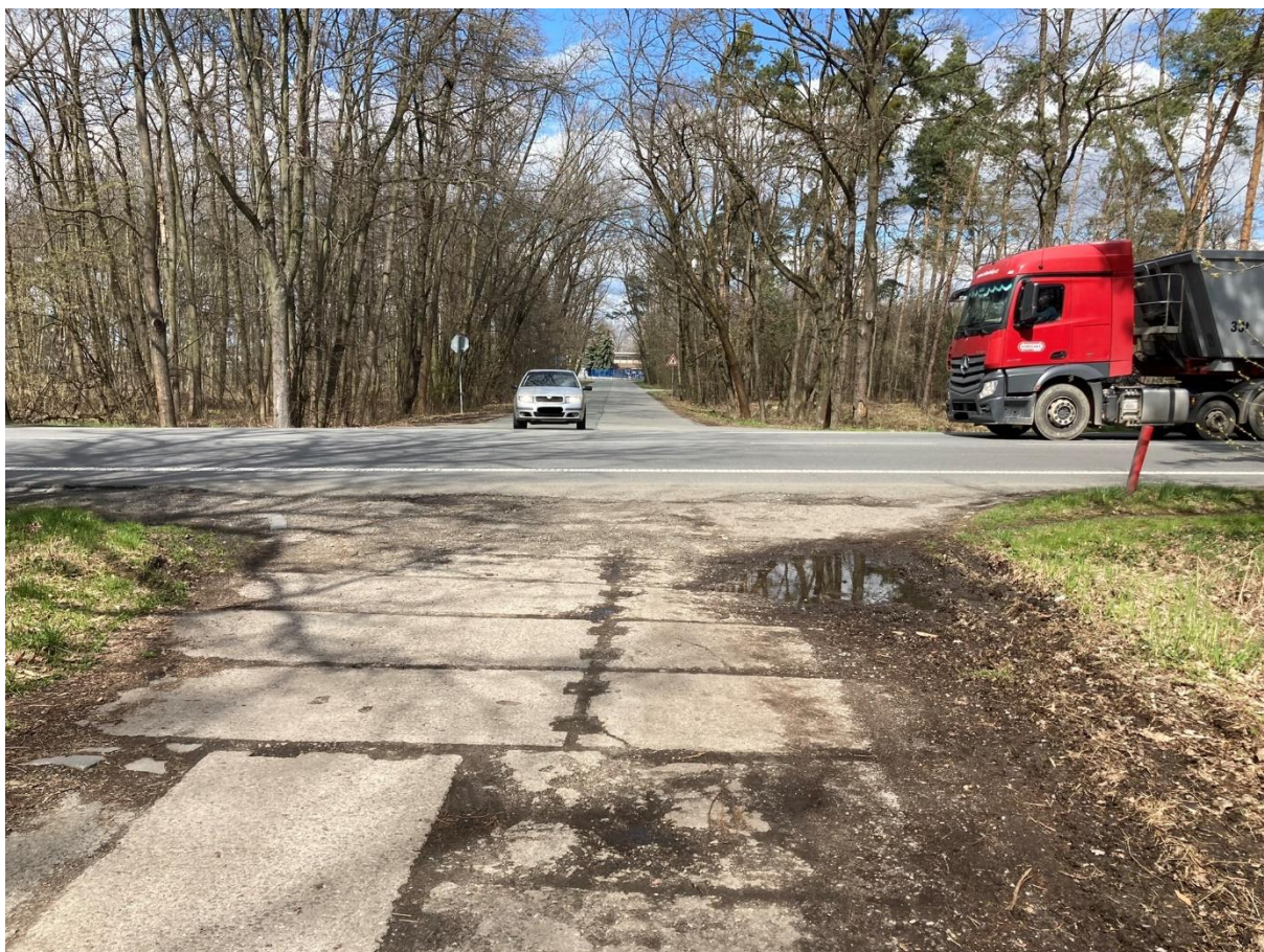
Obrázek 16 Křížení silnice I/2
