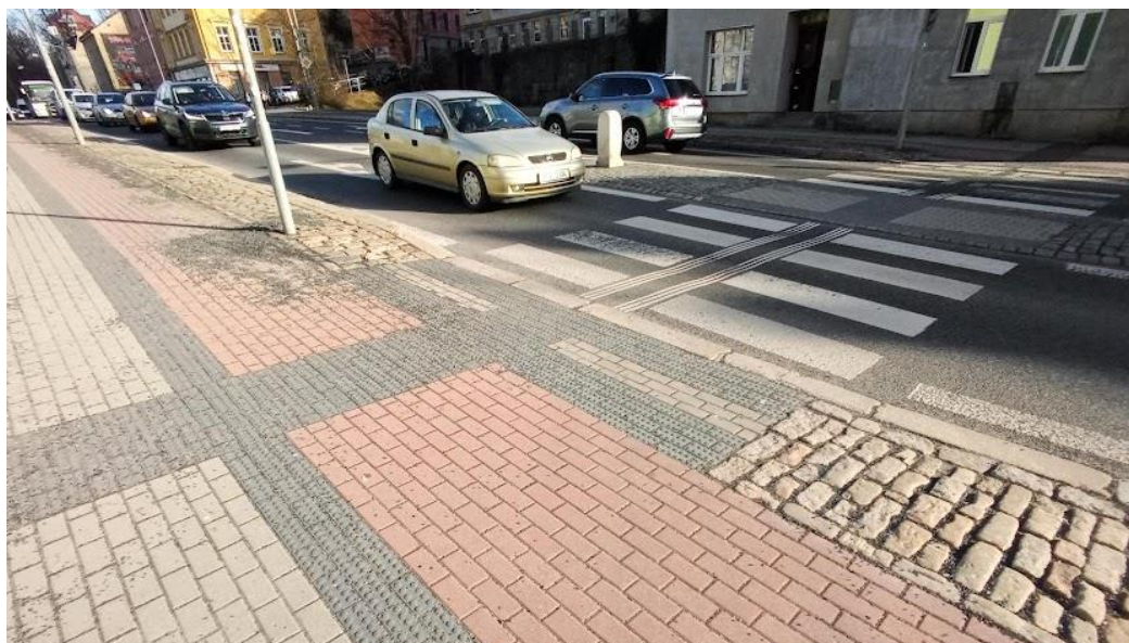
Obrázek 14 Přejchod pro chodce v ulici 5. května s chybnou hmatovou dlažbou 2/2
