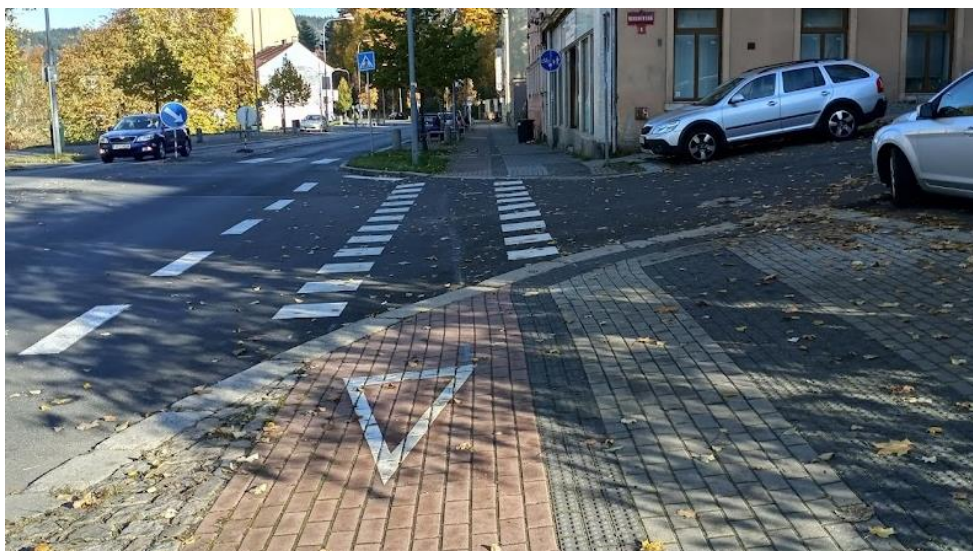
Obrázek 11 Samostatný přejezd pro cyklisty jednosměrný v ulici 5. května
