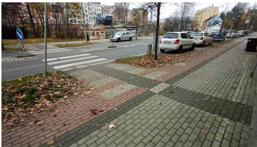
Obrázek 13 Přejchod pro chodce v ulici 5. května s chybnou hmatovou dlažbou 1/2
