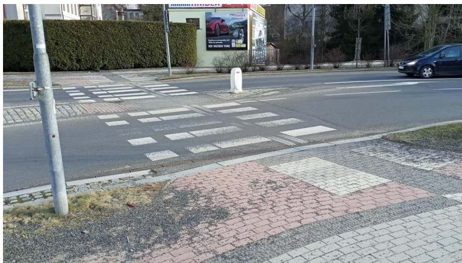
Obrázek 12 Přimknutý přejezd pro cyklisty značený jako samostatný přejezd pro cyklisty v ulici 5. května
