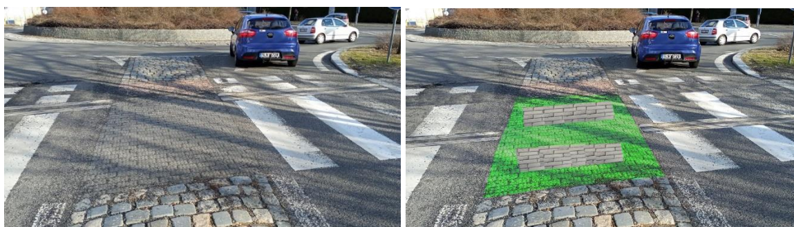
Obrázek 42 Návrh opravy středních dělicích ostrůvků v ulici 5. května
