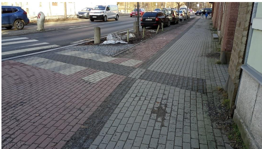
Obrázek 17 Ukázka odsazení mezi přirozenou vodící linií a signálním pásem v ulici 5. května
