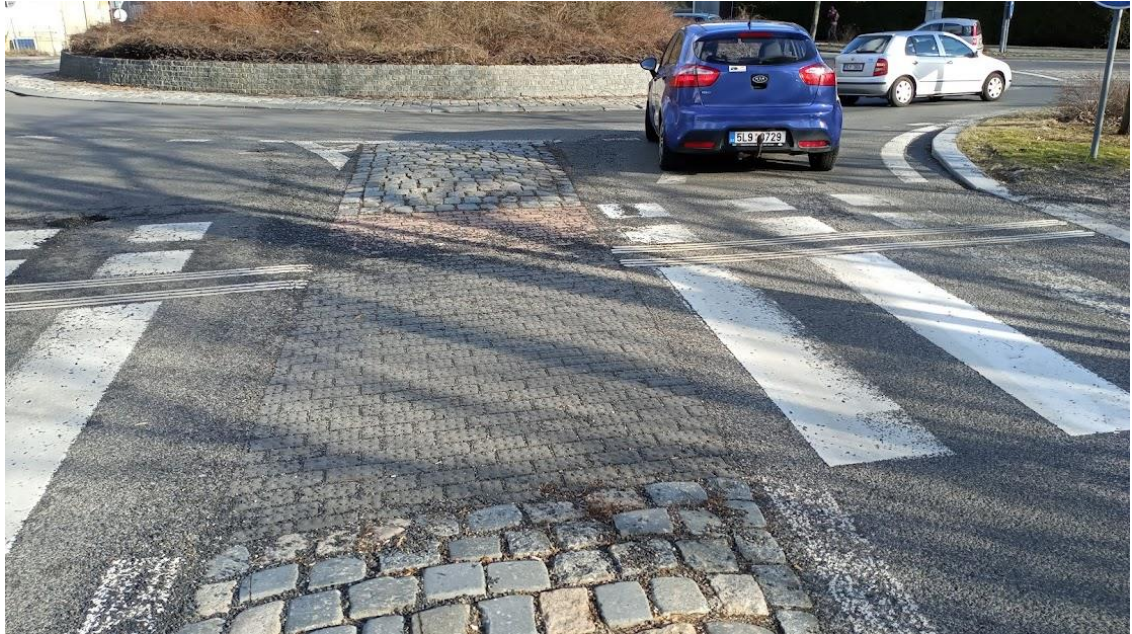
Obrázek 15 Špatně provedená hmatová dlažba na středním dělicím ostrůvku přechodu v ulici Tržní
