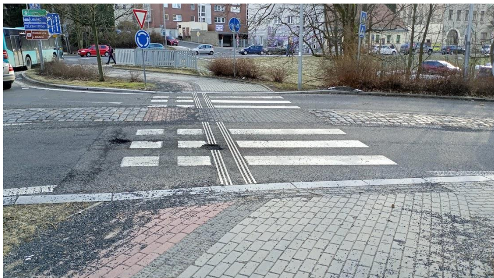
Obrázek 16 Přechod pro chodce a cyklisty v ulici Tržní s chybami (signální pásy, vodící pás přechodu, střední dělicí ostrůvek)
