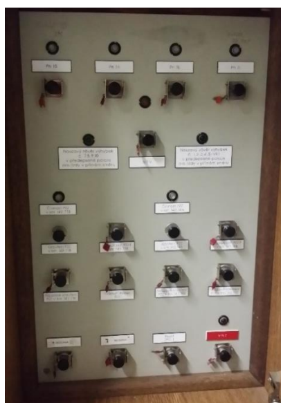
Obrázek 1-6 – Deska nouzových obsluh v ŽST Huštěnovice
