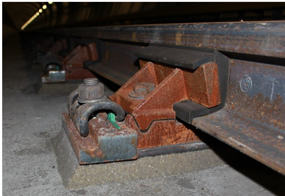
Obr. 33 – uchycení kolejnic v úseku Dejvická – Bořislavka, autor: Ing. Jakub Vágner, Ph.D
