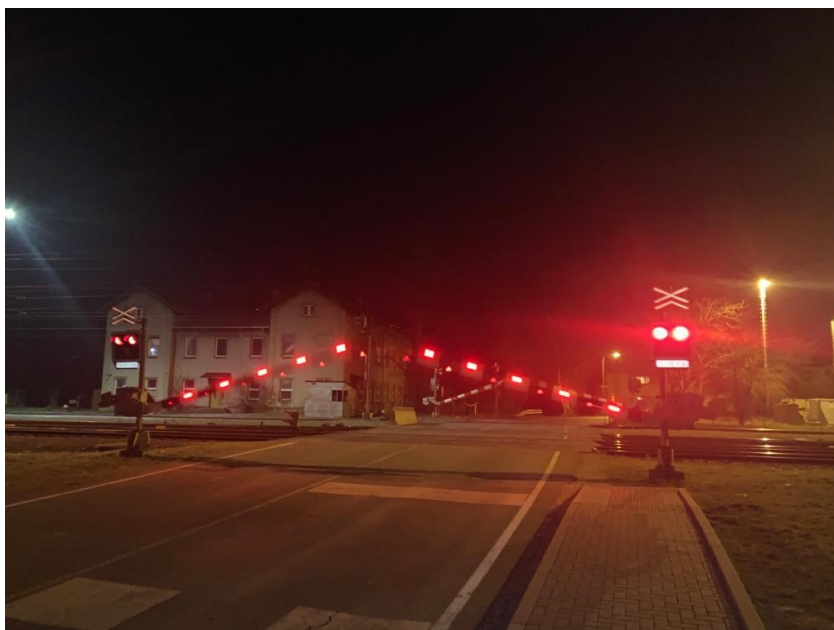
Závora s LED diodovými světly (SŽ, 2020)
