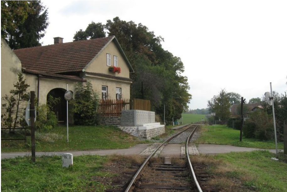
Obrázek 16 Původní stav ŽP P5178 (SŽ, 2021)
