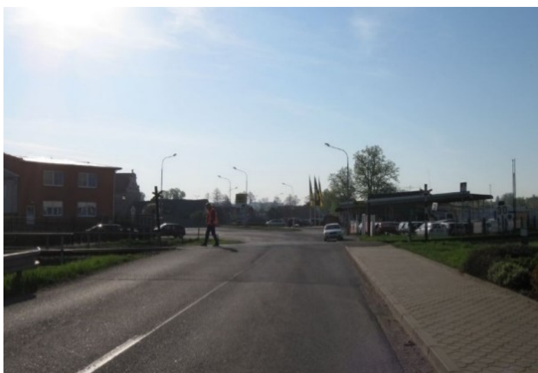
Obrázek 20 Původní stav ŽP P5189 (SŽ, 2021)
