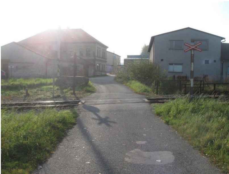
Obrázek 38 Železniční přejezd P5177 (autorka)
