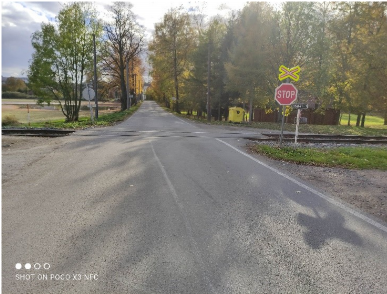
Obrázek 40 Železniční přejezd P5185 (autorka)
