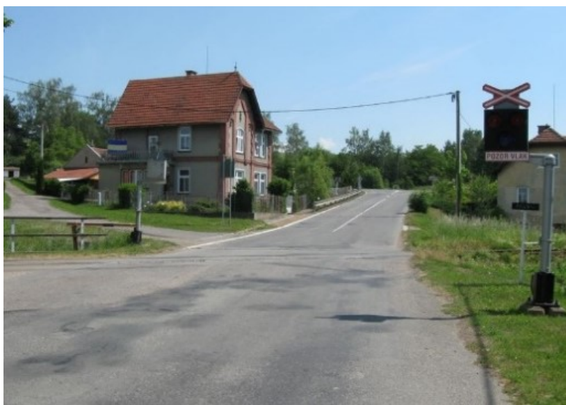
Obrázek 18 Původní stav ŽP P5179 (SŽ,2021)
