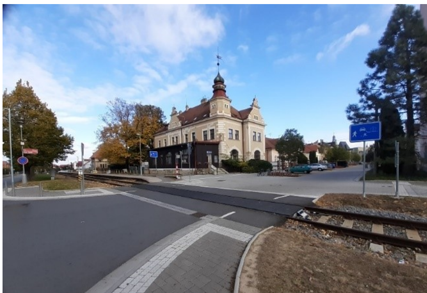
Obrázek 33 Železniční přejezd P5166 (autorka)
