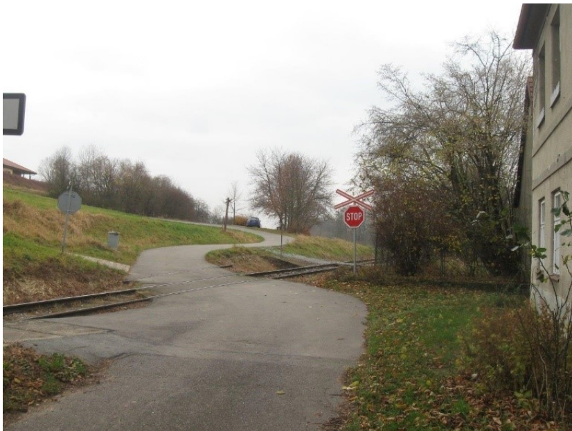
Obrázek 39 Železniční přejezd P5181 (SŽ, 2021)
