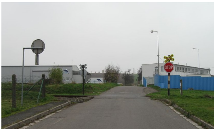
Obrázek 22 Původní stav ŽP P5190 (SŽ, 2021)
