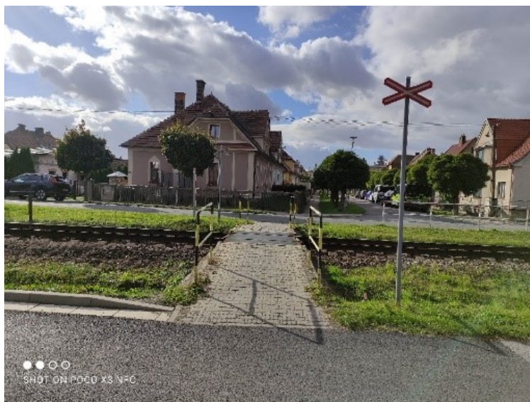
Obrázek 30 Železniční přejezd P5163 (autorka)
