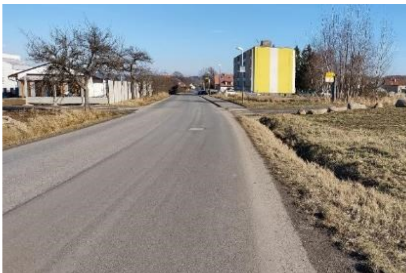
Obrázek 30: Chybějící část chodníku (foto pořízené autorem)
