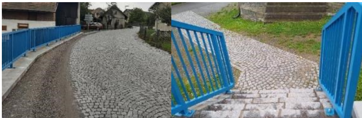
Obrázek 25: Ochranné zábradlí (vlevo) a absence bezbariérového přístupu (vpravo) (foto pořízené autorem)
