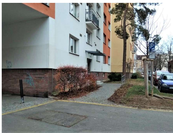
Obrázek 10 - Nástupní plocha pro požární techniku
