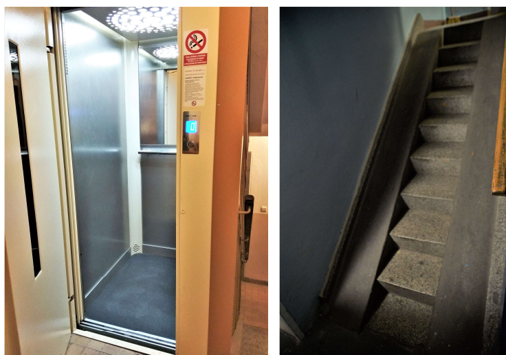
Obrázek 14 – Kabina výtahu a schody s nájezdy mezi vchodem a podzemním podlažím
