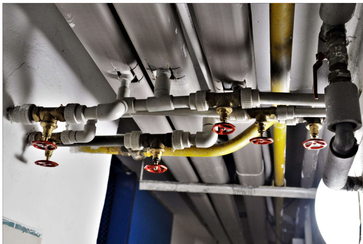
Obrázek 21 - Neoznačené uzávěry vody
