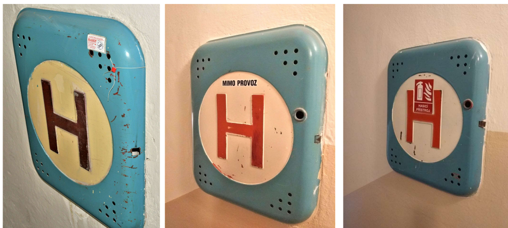
Obrázek 16 - Nástěnné hydranty
