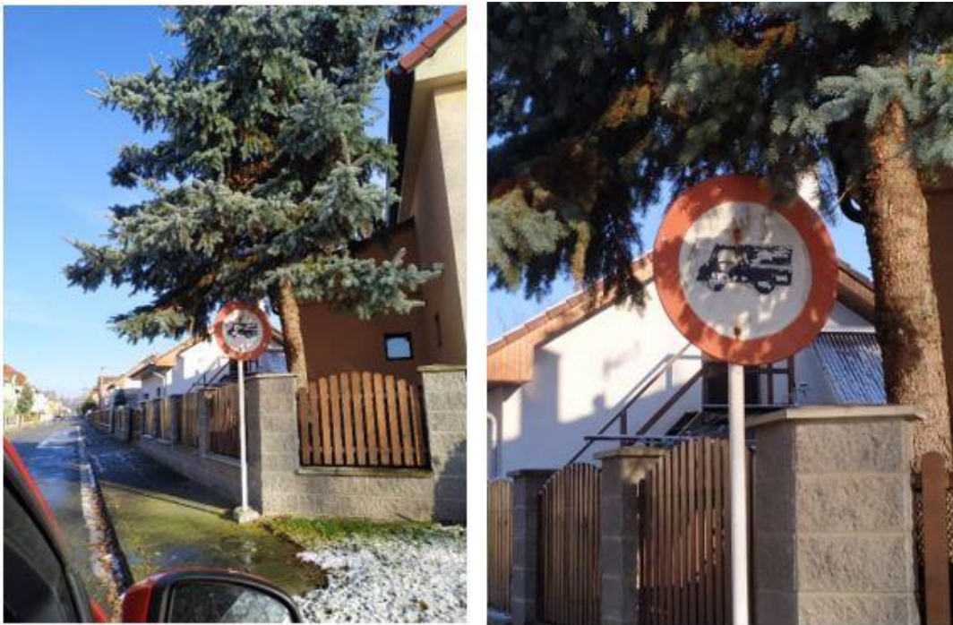
Obrázek 3 - Dopravní značka ve špatném stavu
