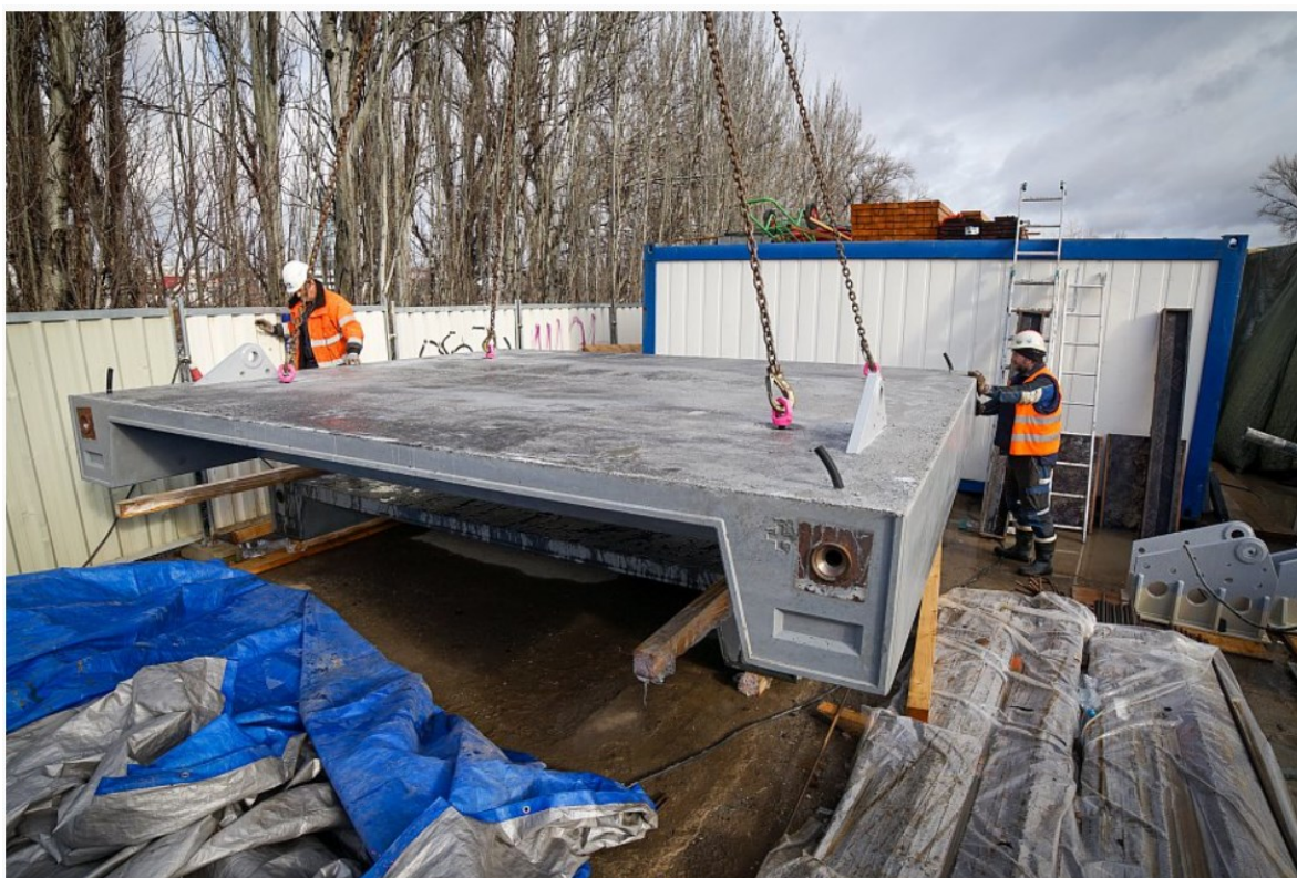
Obrázek 12 Manipulace jednoho ze segmentů lávky [38]
