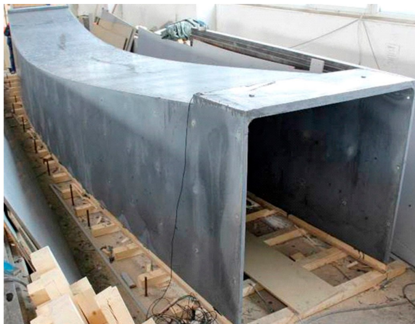
Obrázek 16 Odbedňování tenkostěnné lávky [44]
