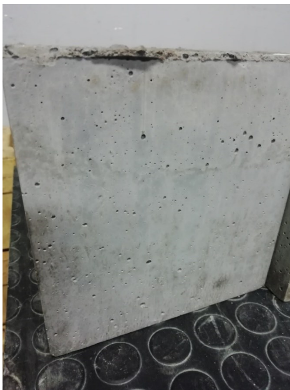
Obrázek 64 Detail povrchu UHPC po odbednění
