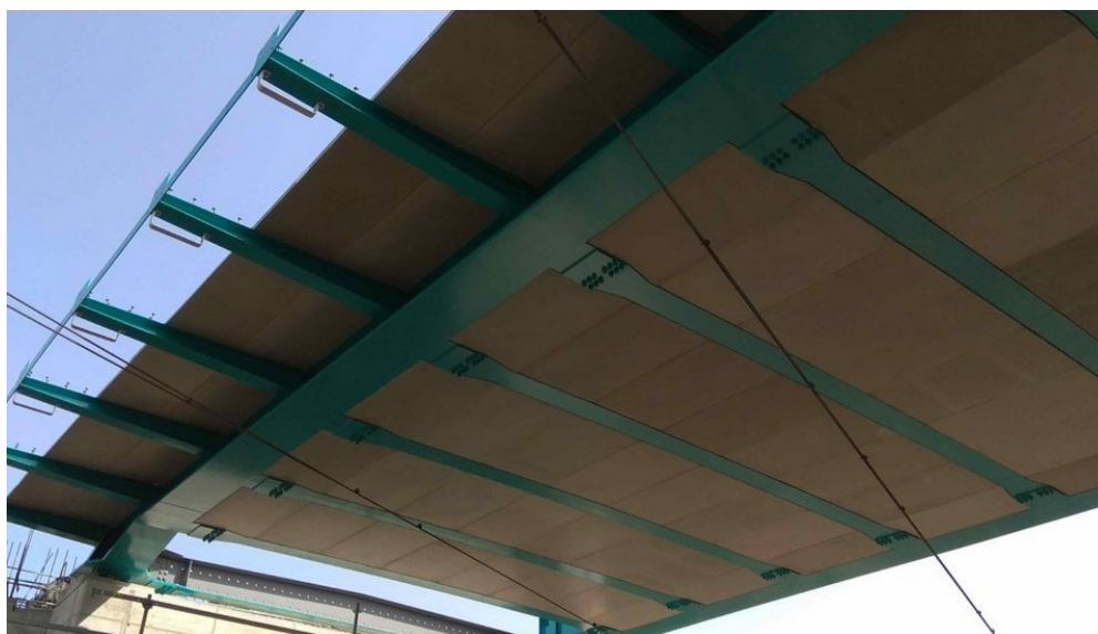
Obrázek 17 Pohled na líc bednicích desek z UHPC [46]
