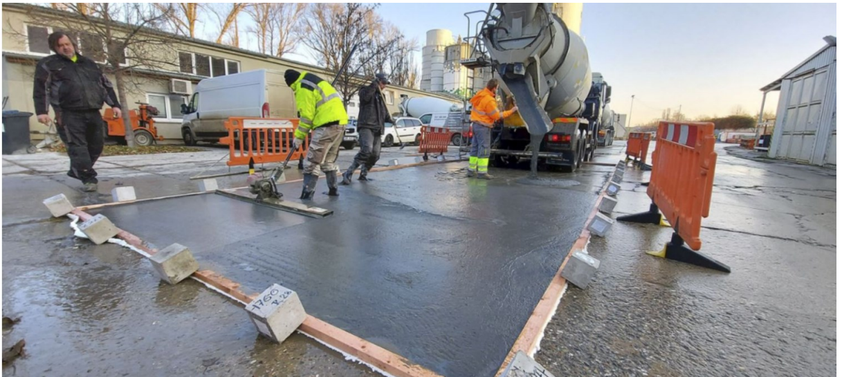
Obrázek 20 Hlazení uloženého čerstvého UHPC pro sanaci vozovky [51]
