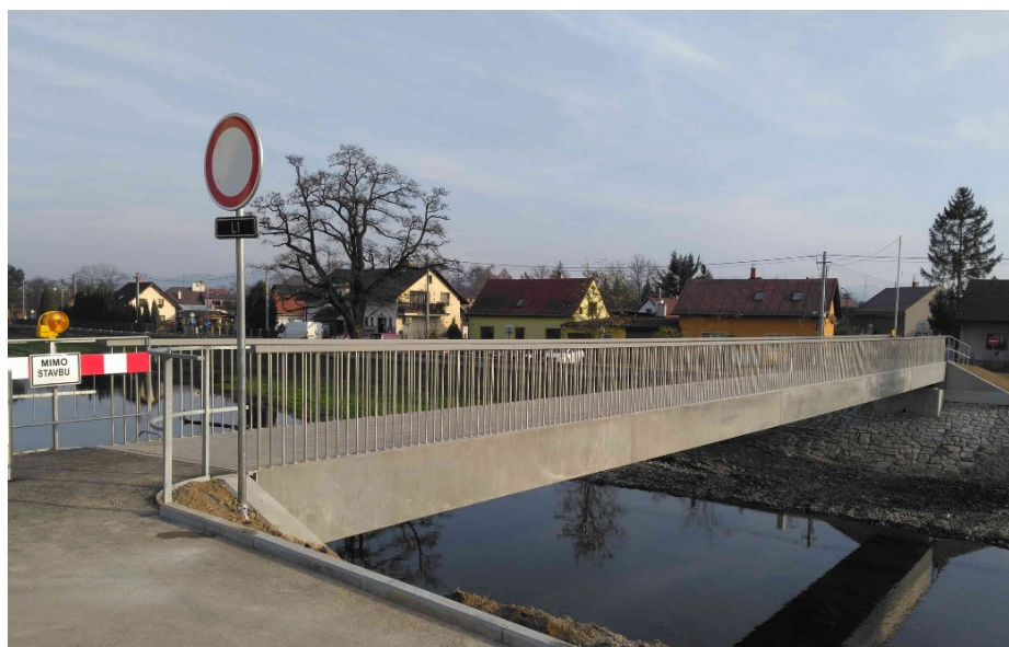
Obrázek 15 Pohled na lávku přes řeku Lubinu [43]
