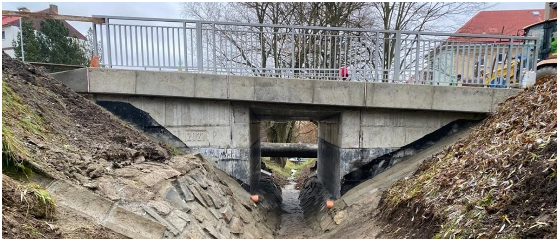
Obrázek 21 Zesílení spodní části mostu [52]
