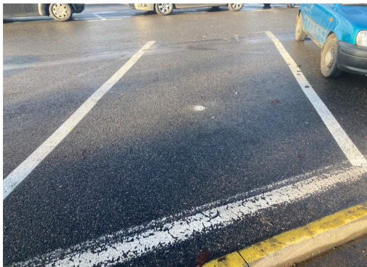
Obrázek 15 Parkovací stání s osazeným senzorem na parkovišti u zimního stadionu
