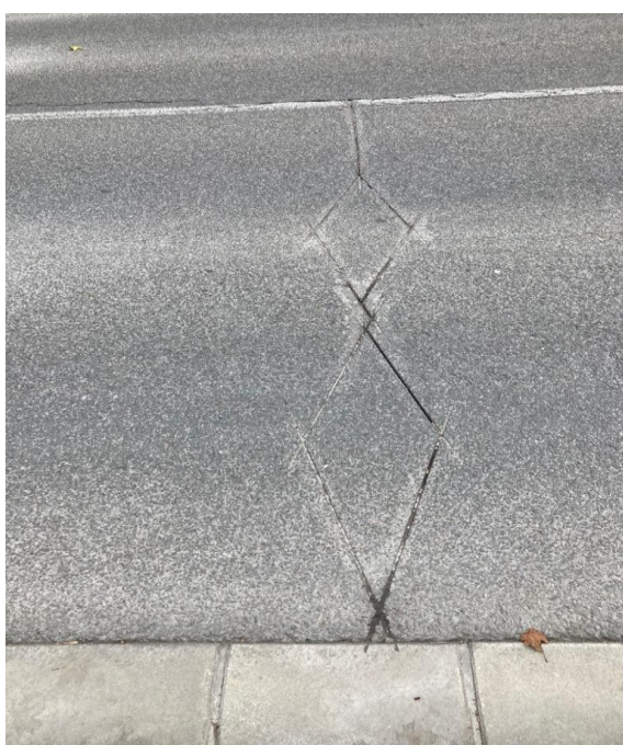
Obrázek 24 Indukční smyčka v konfiguraci Selective v ulici Husova
