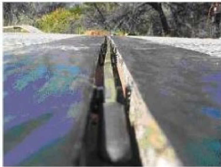
Obrázek 6 Uložení piezoelektrického kabelu do vozovky [11]
