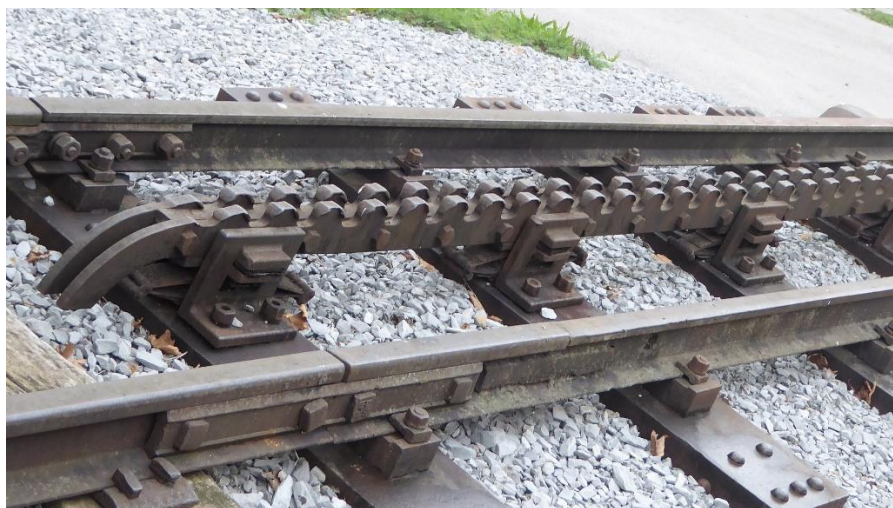
Obrázek č. 26 Přechod do z adhezní do ozubnicové části na bývalé ozubnicové železniční trati v Bosně a Hercegovině [36]
