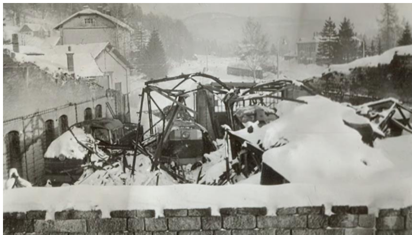
Obrázek č. 4 Zřícená střecha Kořenovské výtopny v roce 1987 [12]
