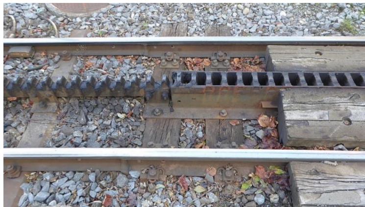
Obrázek č. 10 Riggenbachova ozubnice na železničním přejezdu St. Gallen – Gais – Appenzell – Altstätten – Bahn [19]
