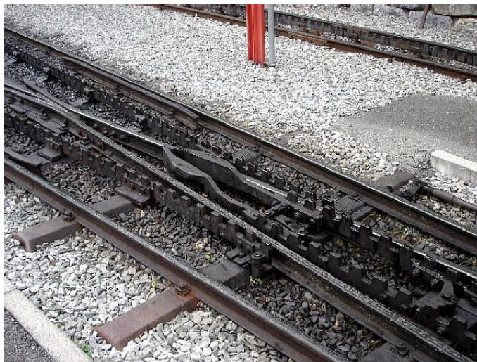
Obrázek č. 13 Řešení výhybek pomocí Abtovy jednoduché ozubnice [22]
