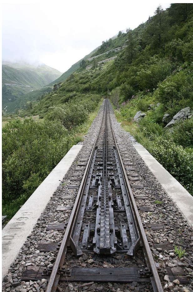
Obrázek č. 27 Přechod mezi adhezní a ozubnicovou částí na trati Furka – Bergstrecke [37]
