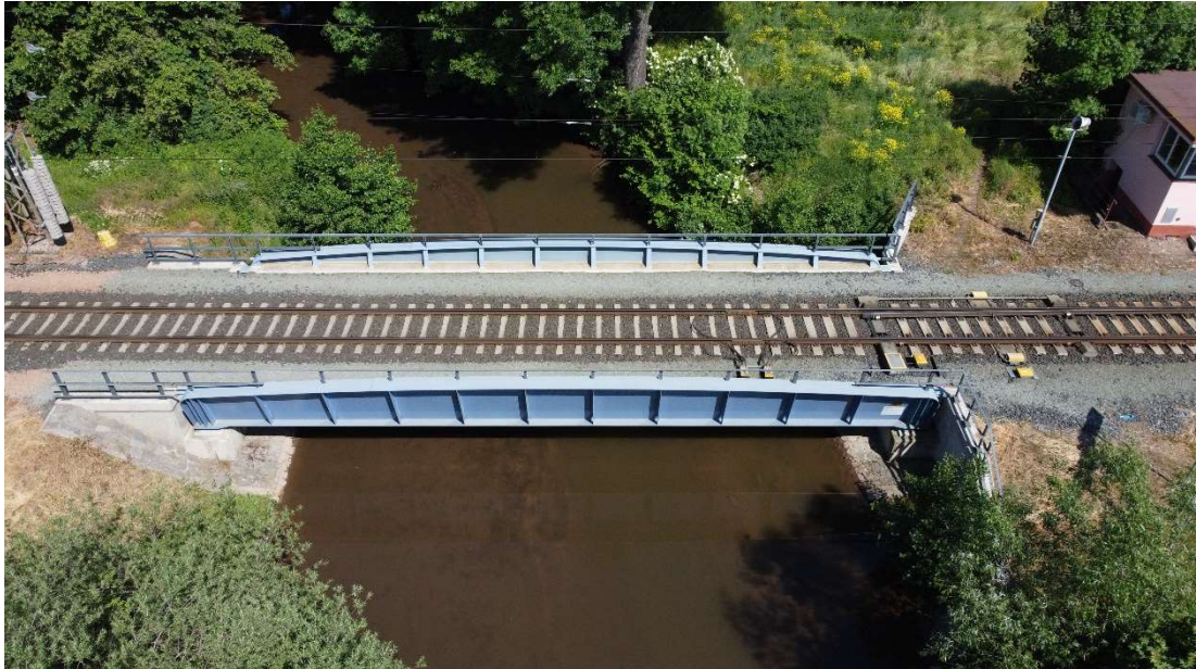
Obrázek 4 – Most s vylehčenou ocelobetonovou mostovkou (dle MVL 155 typ 7) v Předměřicích nad Labem
