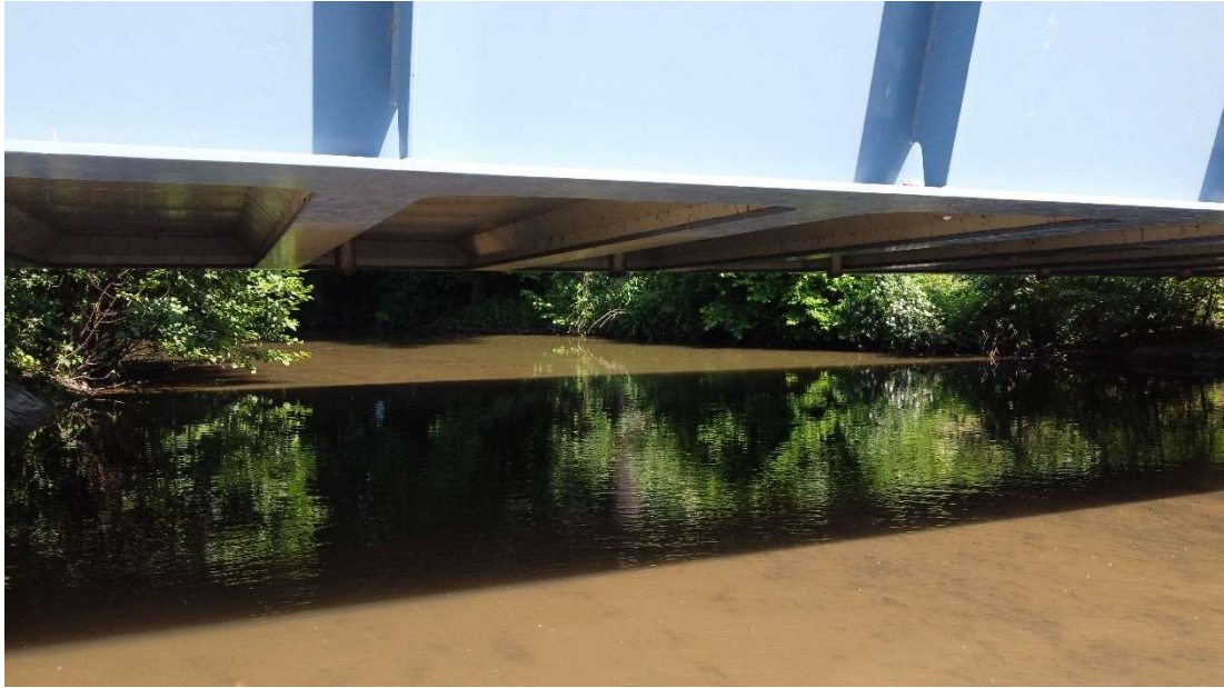
Obrázek 6 - Most s vylehčenou ocelobetonovou mostovkou (dle MVL 155 typ 7) v Předměřicích nad Labem
