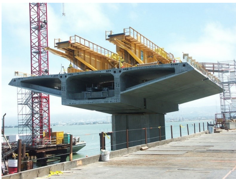
Obrázek 36 – Již zabudovaný segment po erekci [21]
