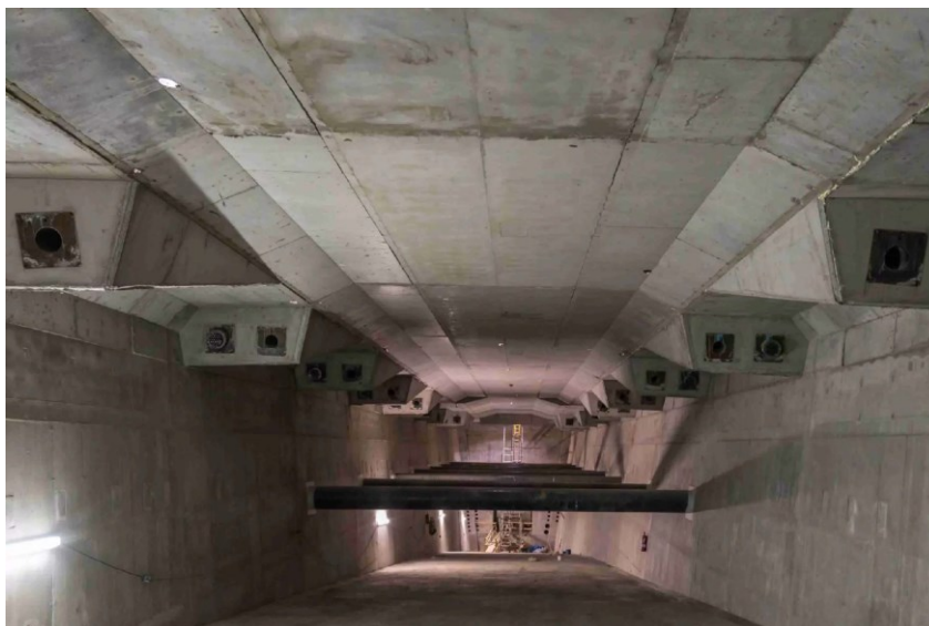
Obrázek 50 – nálitky pro kotvení záporných kabelů [26]
