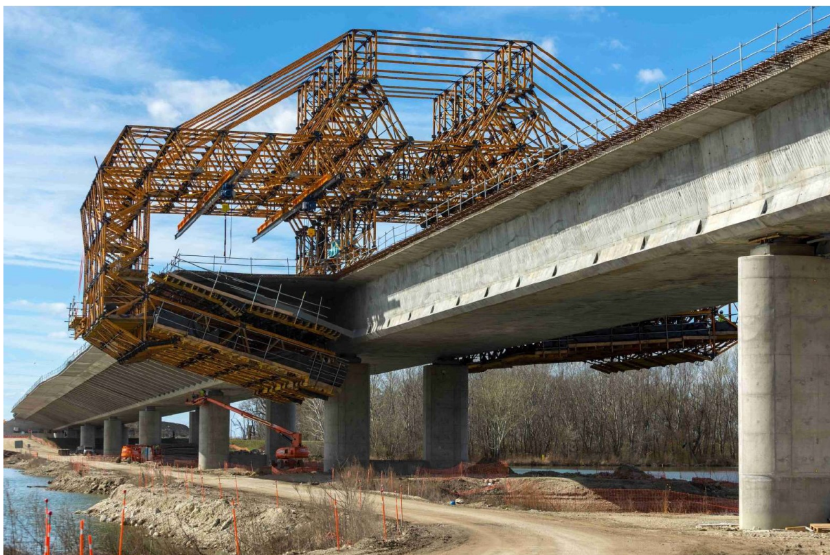
Obrázek 55 – Betonáž konzol a osazení vzpěr [29]
