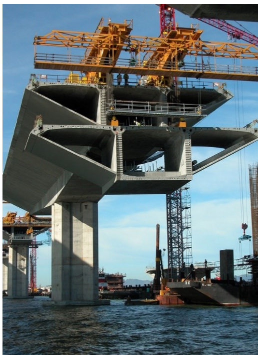
Obrázek 35 – Erekcce segmentu [20]
