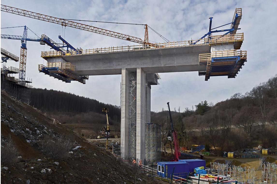
Obrázek 32 – Pohled na dvojici pilířů včetně jejich ztužení [19]
