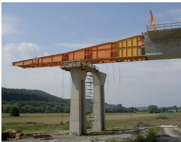
Obrázek 17 – Výsuvný nos (ocelový nástavec) [12]
