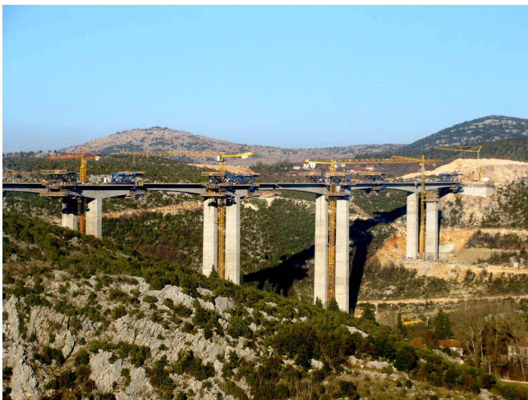
Obrázek 44 - Studenčica Viaduct před dokončením [25]
