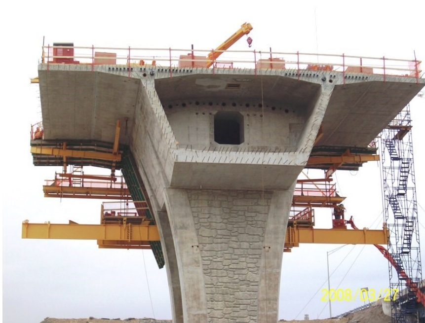
Obrázek 24 – Typický příčný řez letmo betonovaného mostu [15]
