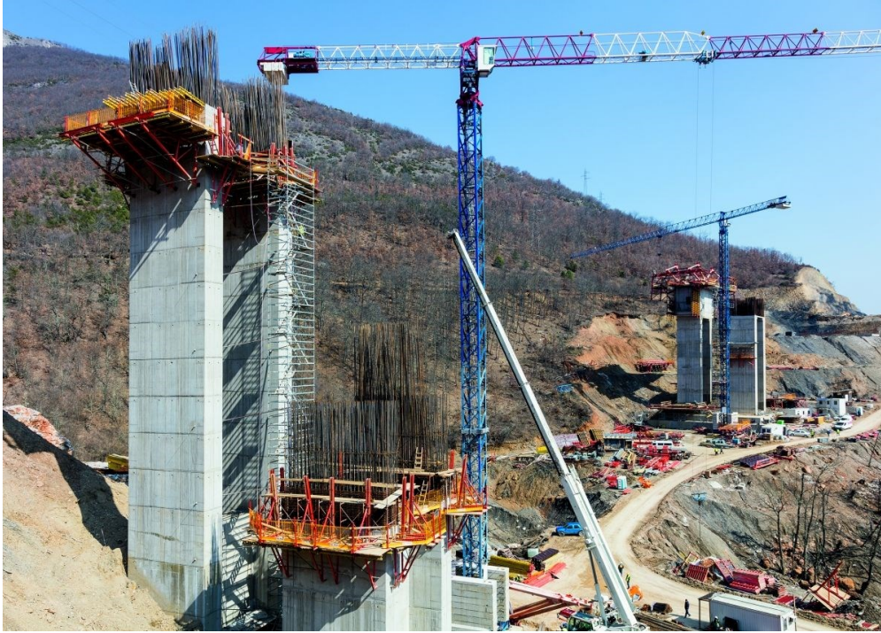
Obrázek 54 – Průběh výstavby spodní stavby [28]
