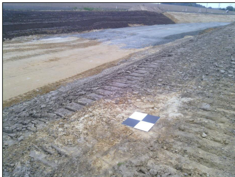
Obrázek 28 - Stavba před měřením metodou leteckého mapování [vlastní fotografie]
