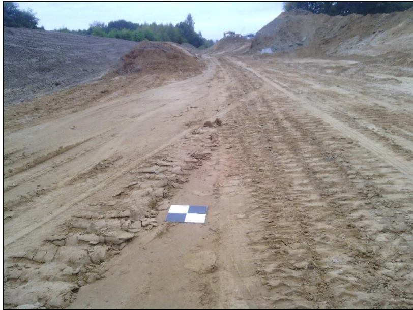
Obrázek 29 - Stavba před měřením metodou leteckého mapování [vlastní fotografie]
