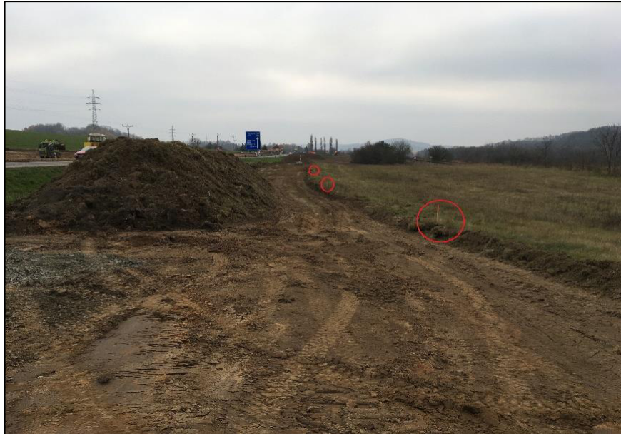
Obrázek 2 - Vytyčení obvodu stavby [vlastní fotografie]
