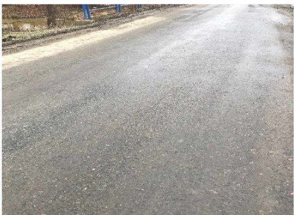
Vozovka na začátku mostu
