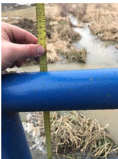
Výška zábradlí 1000 mm
