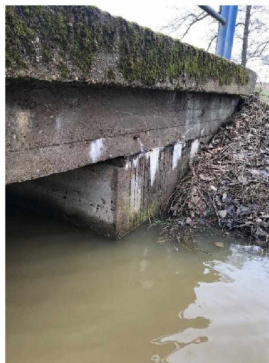
Levé křídlo na začátku mostu
