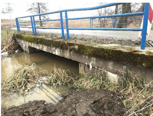
Pohled na objekt zprava
