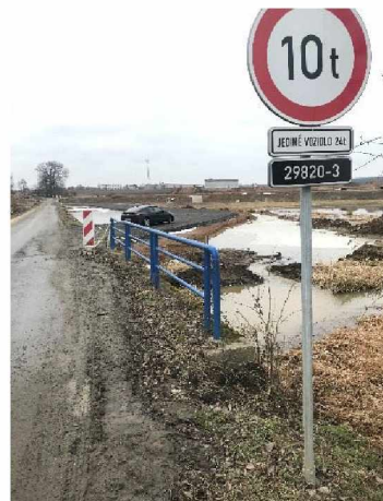
Pohled na pravou římsu ve směru staničení
