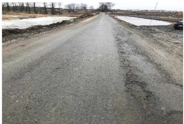
Vozovka na konci mostu
