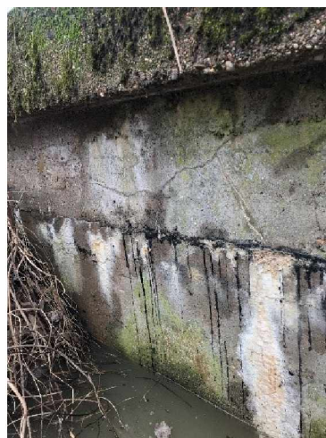
Levé křídlo na konci mostu
