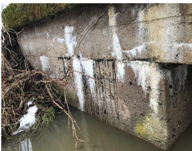
Pravé křídlo na začátku mostu
