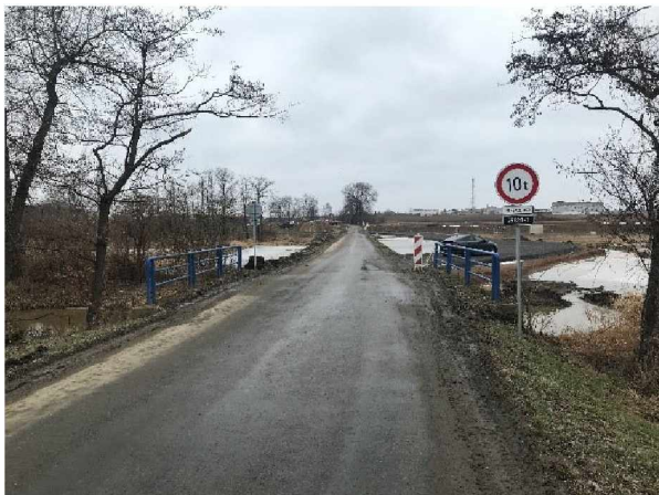
Pohled ve směru staničení
