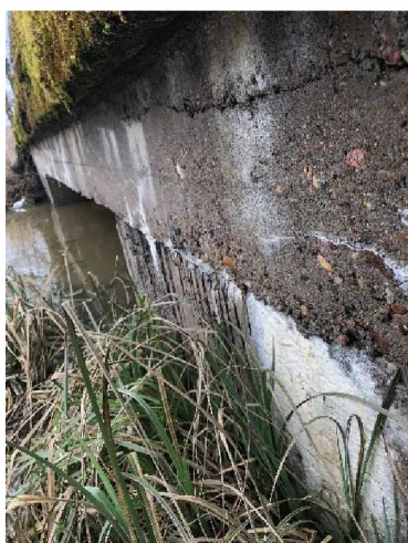
Pohled na NK zprava
