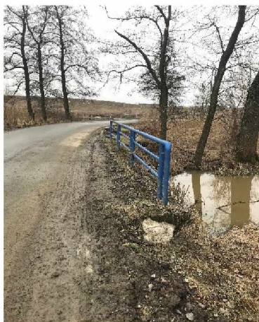
Pohled na levou římsu proti směru staničení
