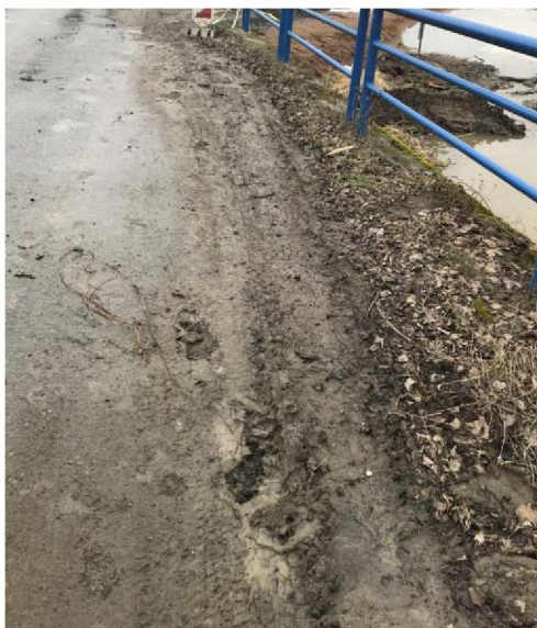
Nánosy nečistot podél obou říms
