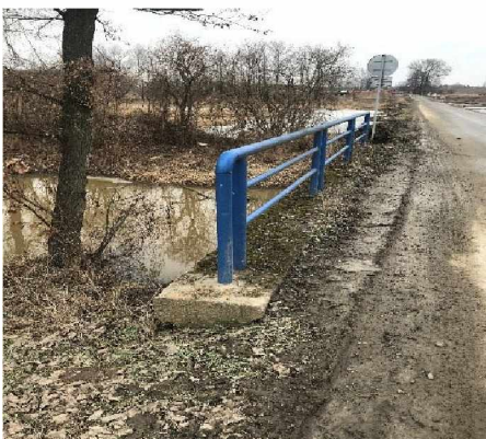
Pohled na levou římsu ve směru staničení
