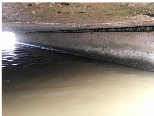
Pohled na opěru O1
