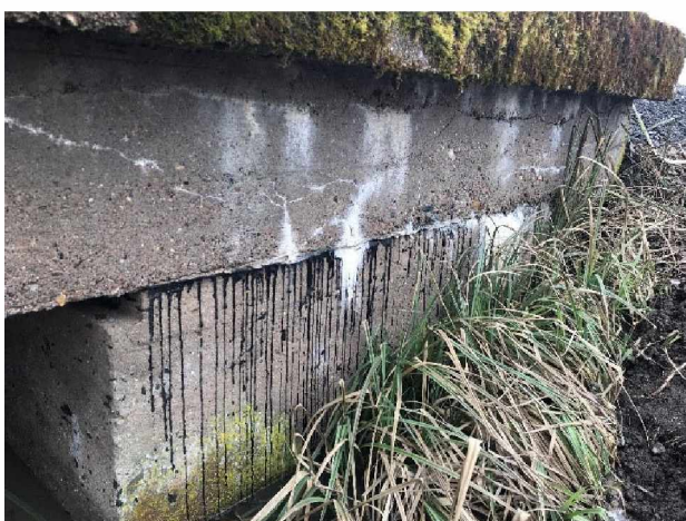
Pravé křídlo na konci mostu
