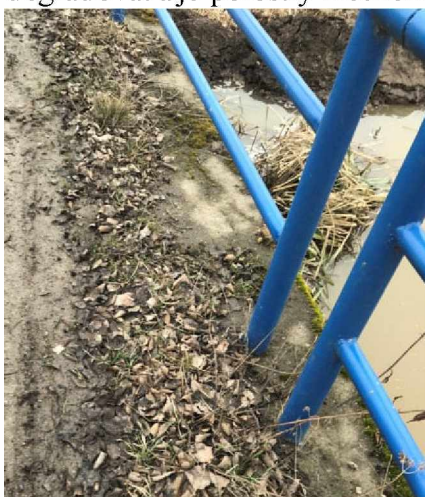
Povrch levé i pravé římsy začíná degradovat a je porostlý mechem
