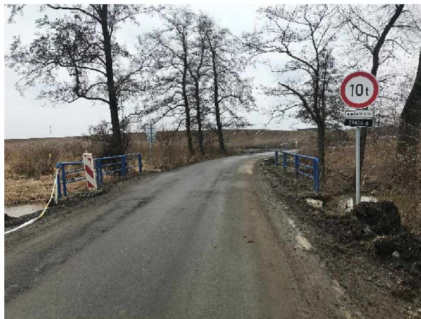
Pohled proti směru staničení
