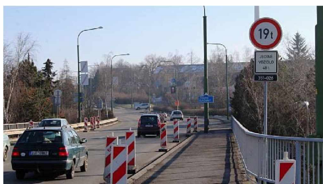
Obr. 15 Příklad značení zatížitelnosti na mostě
