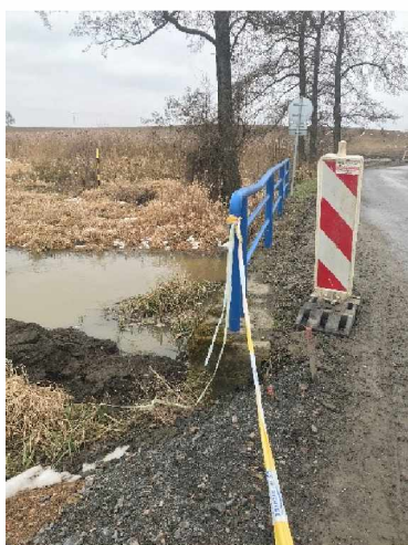
Pohled na pravou římsu proti směru staničení
