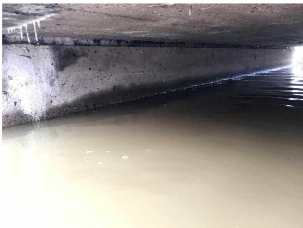
Pohled na opěru O2
